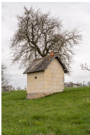
Vue d'ensemble. Phot. Jeanne Minier IVR52_20267200318NUCA
