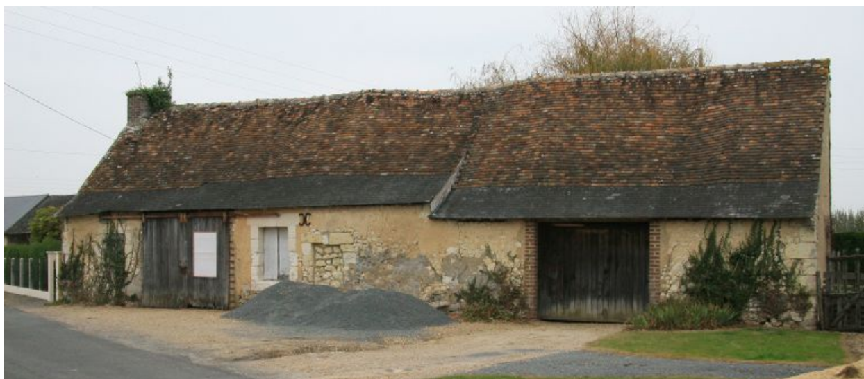
Vue de volume : maison et dépendances.
