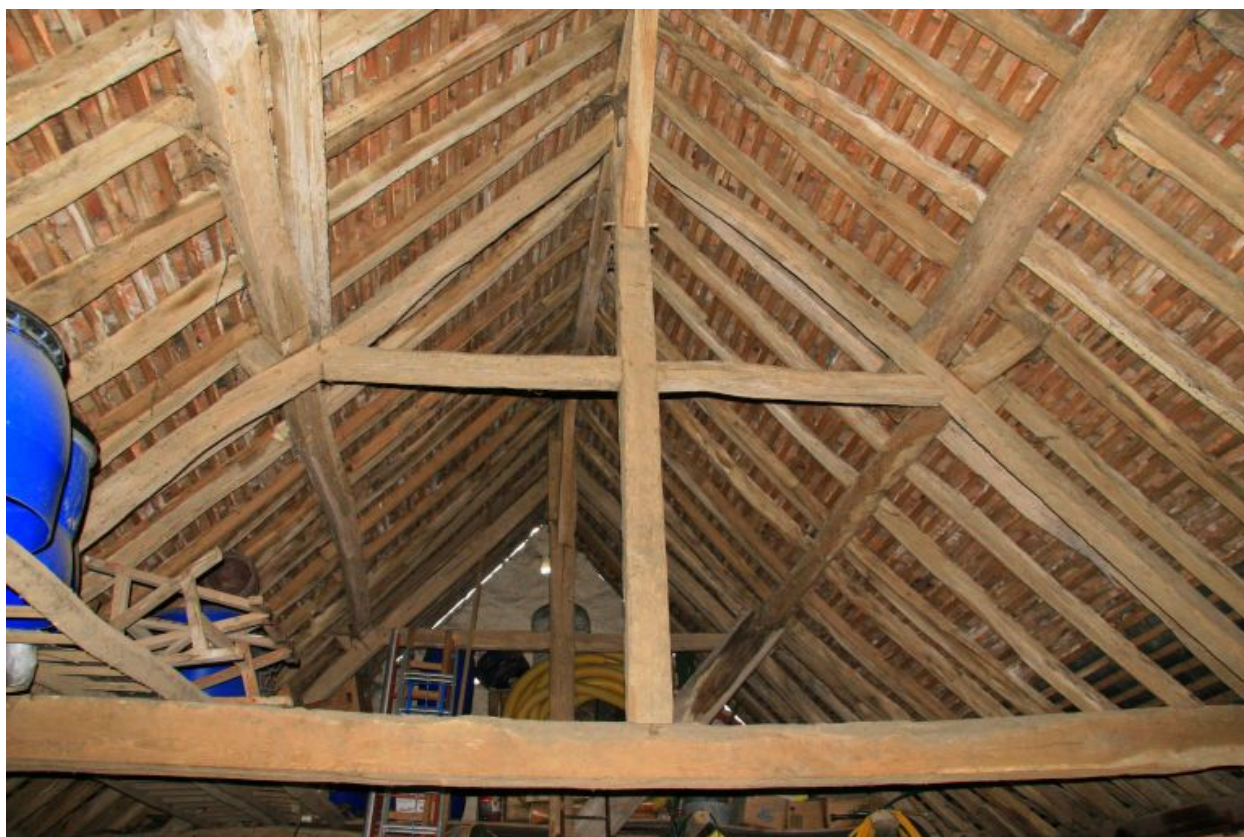
Charpente à pannes au-dessus des dépendances.
