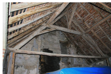
La maison entièrement vidée : vestige du conduit de cheminée. Phot. Jean-Baptiste Darrasse IVR52_20077202491NUCA
