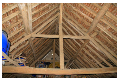
Charpente à pannes au- dessus des dépendances. Phot. Jean-Baptiste Darrasse IVR52_20077202493NUCA
