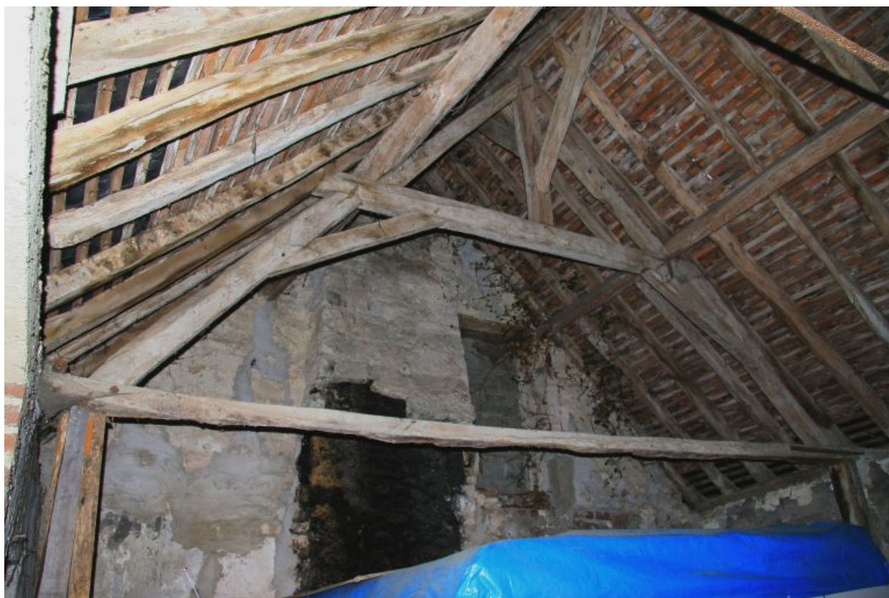
La maison entièrement vidée : vestige du conduit de cheminée.
