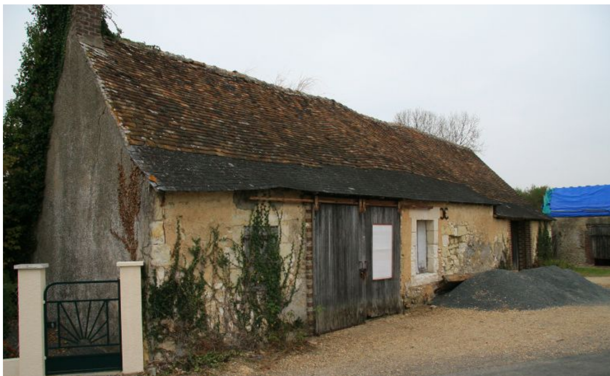
La maison éventrée par une porte de garage.
