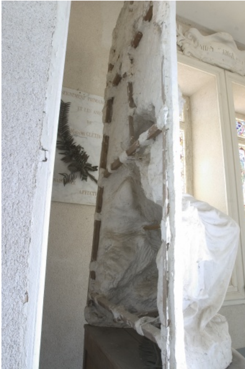
Vue de trois-quarts de la structure en bois soutenant le plâtre.
