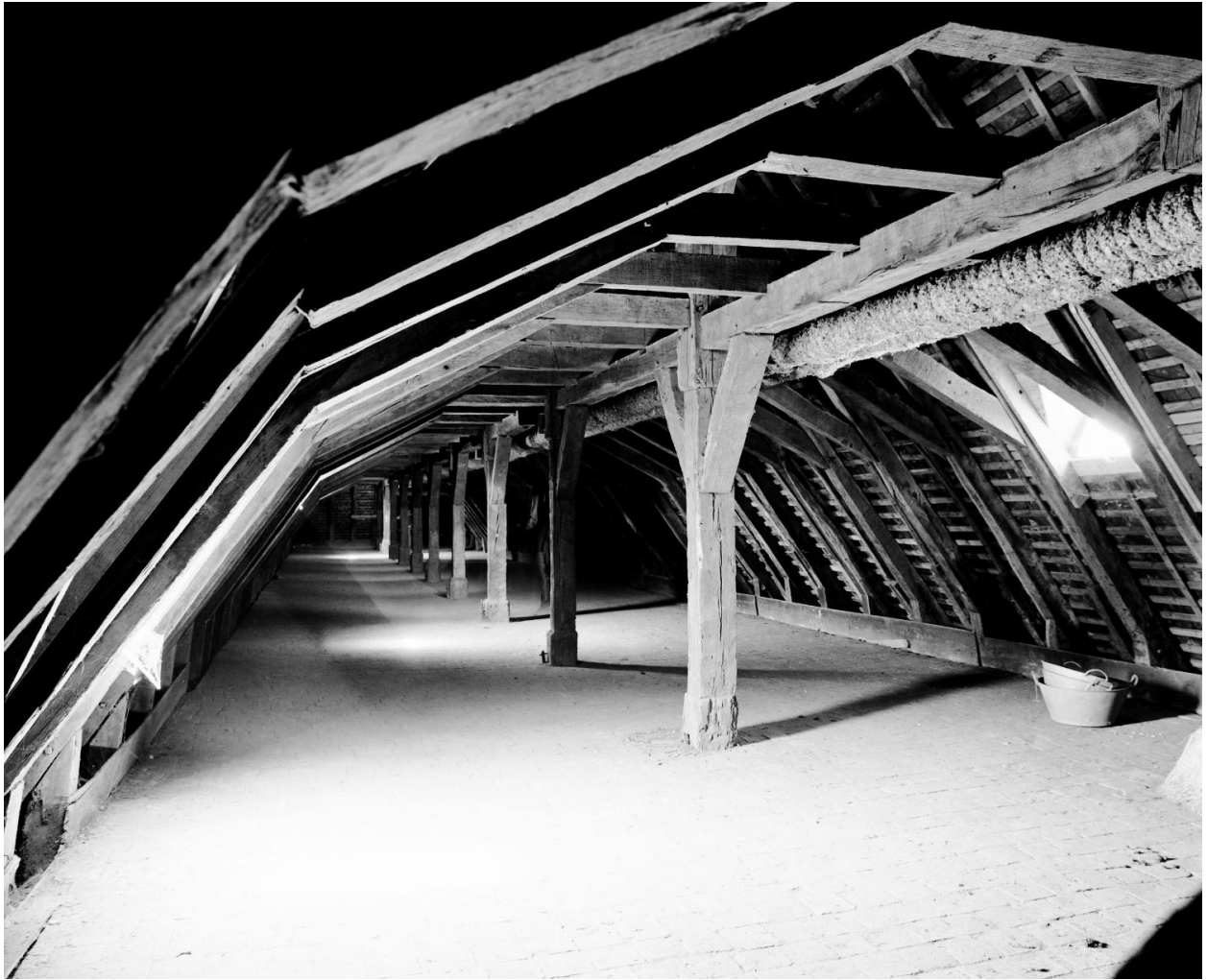
Aile est du cloître (aile du réfectoire), 2e niveau du comble : vue d'ensemble de la charpente, en axe nord-sud.
