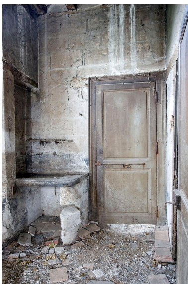
La ferme, corps d'habitation, vestibule, mur latéral gauche avec un évier à l'angle de la face antérieure, et porte ouvrant sur la pièce latérale gauche.
