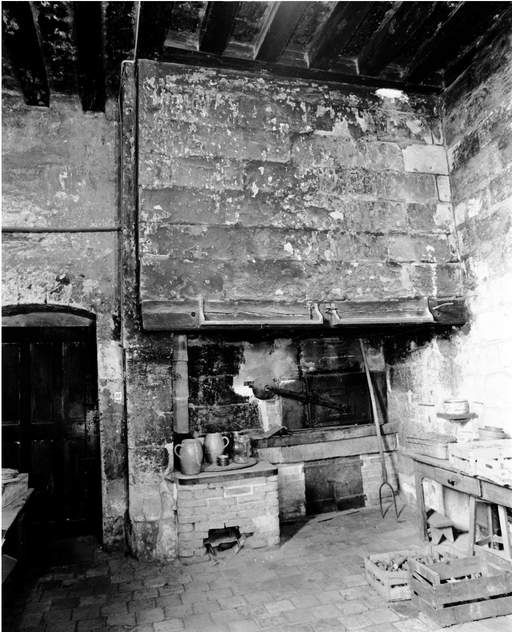
Bâtiment dit des lieux communs de communs, rez-de-chaussée, deuxième boulangerie (sur le plan de 1796), mur est : cheminée, vue d'ensemble.
