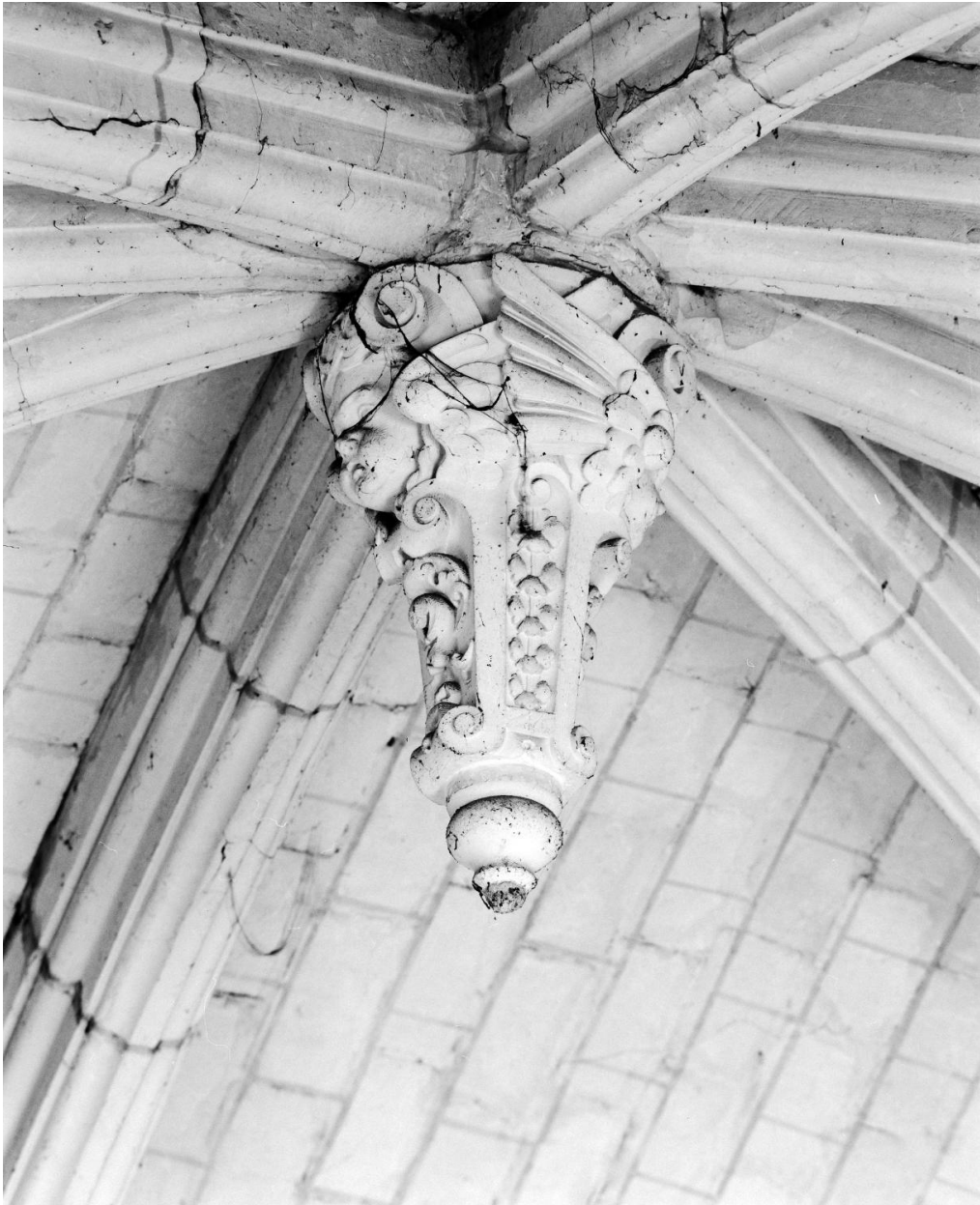
Eglise, nef, deuxième travée : clé de voûte.
