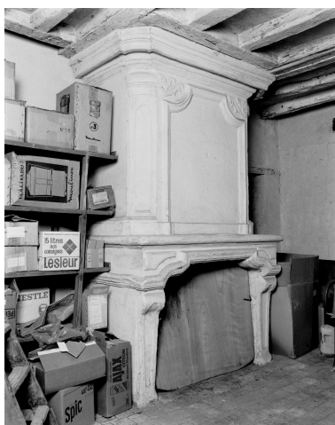
Bâtiment dit des lieux communs, 1er étage, pièce au-dessus de la buanderie (cf. plan 1796), mur ouest : cheminée. Phot. François Lasa IVR52_19814900472X
