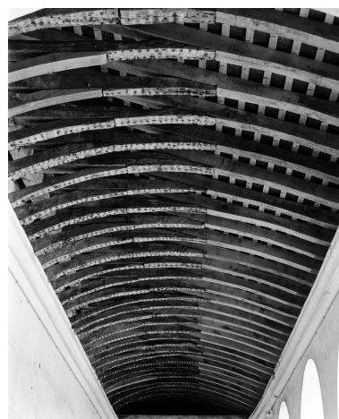
Galerie nord du cloître : vue d'ensemble du couvrement, d'ouest en est. Phot. François Lasa IVR52_19974901362X
