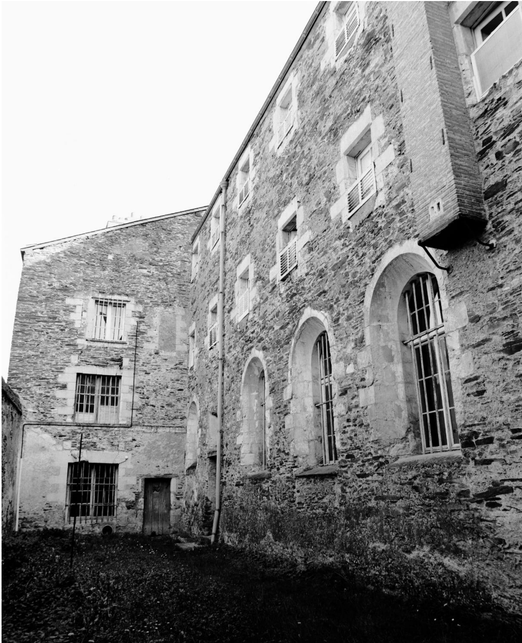
Aile nord du chapitre : élévation nord, vue d'est en ouest ; en arrière-plan, élévation du bâtiment qui abritait au rez-de-chaussée la 1ère boulangerie (ainsi nommée sur le plan de 1796).
