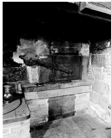
Bâtiment dit des lieux communs, rez- de-chaussée, deuxième boulangerie (sur le plan de 1796), mur est : cheminée, détail sur le four. Phot. François Lasa IVR52_19974901369X
