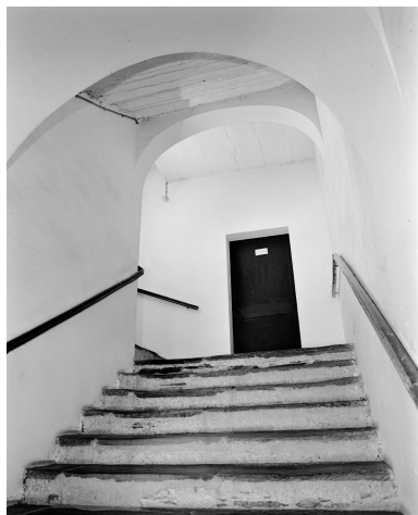
Aile nord du cloître (aile du chapitre), escalier est : première volée. Phot. François Lasa IVR52_19974901367X
