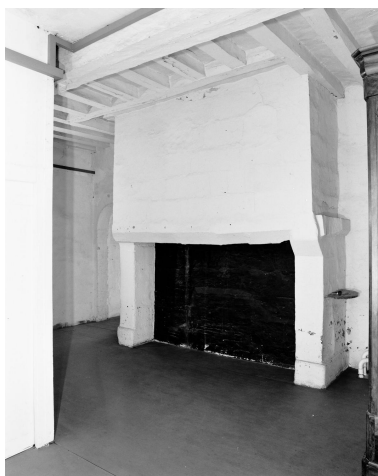
Aile est du cloître, deuxième étage, cellule d'angle nord-est (cloisons aujourd'hui disparues) : cheminée appuyée au mur est. Phot. François Lasa IVR52_19974901374X
