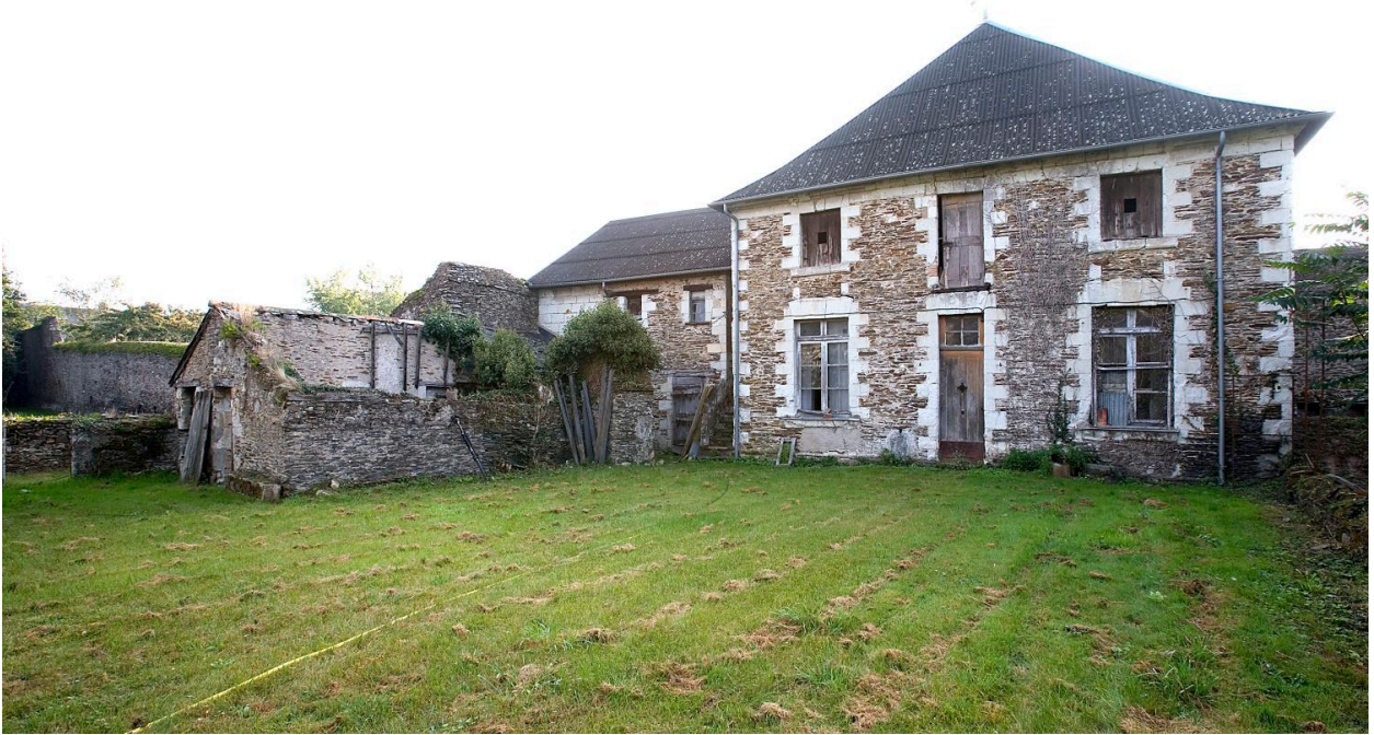
La ferme : vue d'ensemble de la basse-cour avec le corps d'habitation à droite, et les bâtiments agricoles - en partie en ruines -, à gauche.
