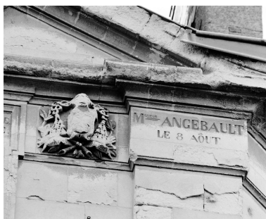
Le pensionnat, élévation est sur le jardin, avant-corps central, partie supérieure droite : inscription, date et armoirie de l'évêque d'Angers Mgr Angebault, en vis-à-vis de celles concernant Pie IX.
