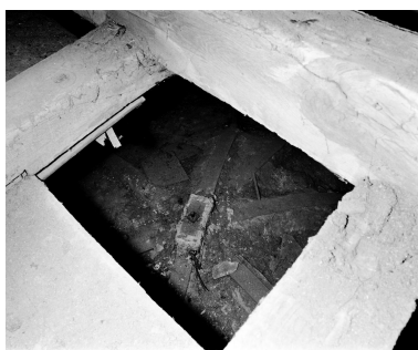
Eglise, l'une des voûtes de la nef : détail sur le cerclage métallique épousant les nervures, à l'extrados. Phot. François Lasa IVR52_19974901364X
