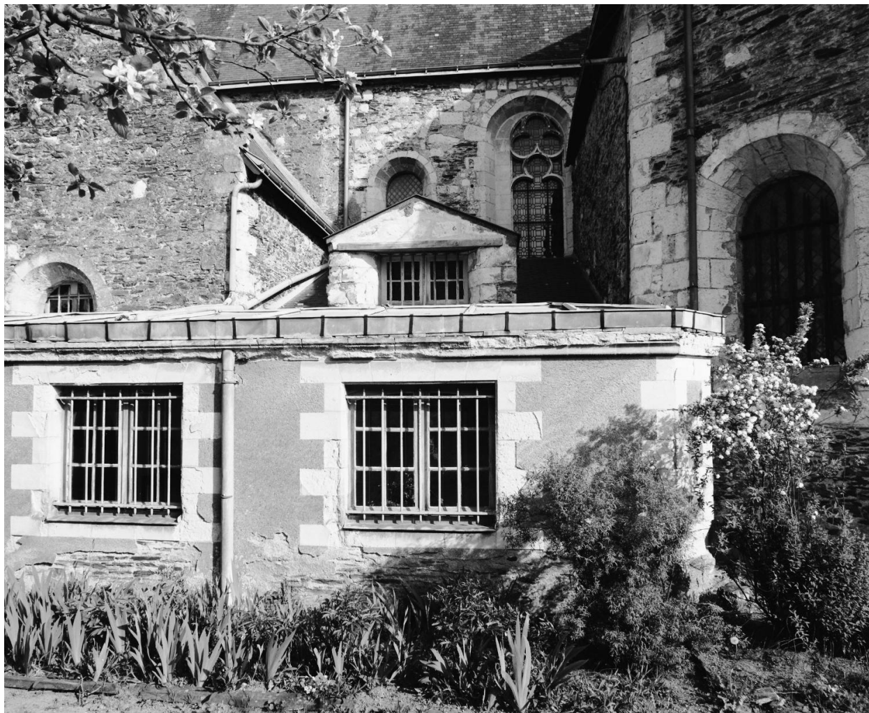
Eglise, élévation gauche : vue sur les baies éclairant la dernière travée de la nef et le choeur des religieuses entre la grande sacristie à gauche et la chapelle de Guéméné à droite ; au centre la petite sacristie et une galerie de passage au 1er plan.
