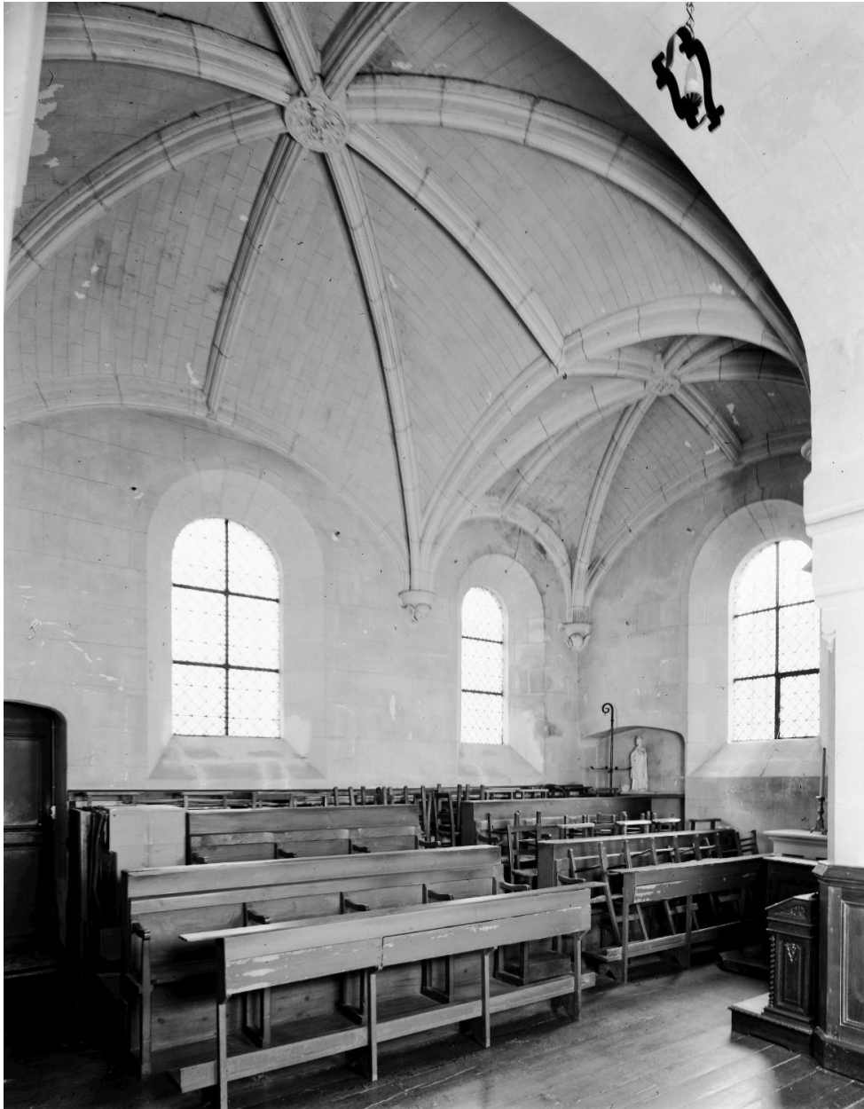
Eglise, chapelle sud : vue intérieure vers l'angle sud-ouest.
