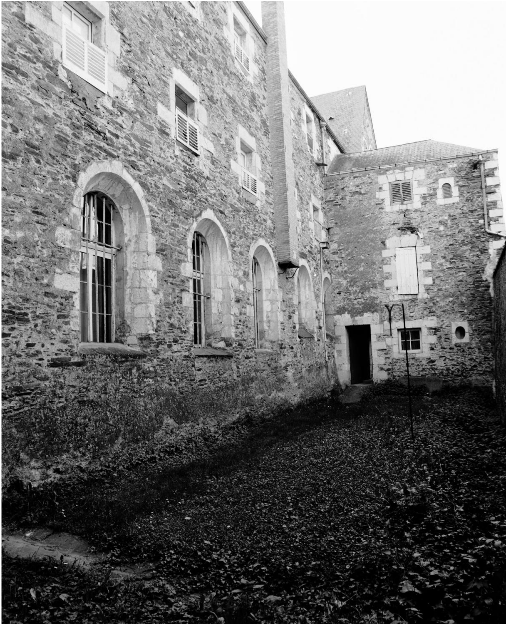
Aile nord du chapitre : élévation nord, vue d'ouest en est ; en arrière-plan, la partie supérieure du chevet de l'église.
