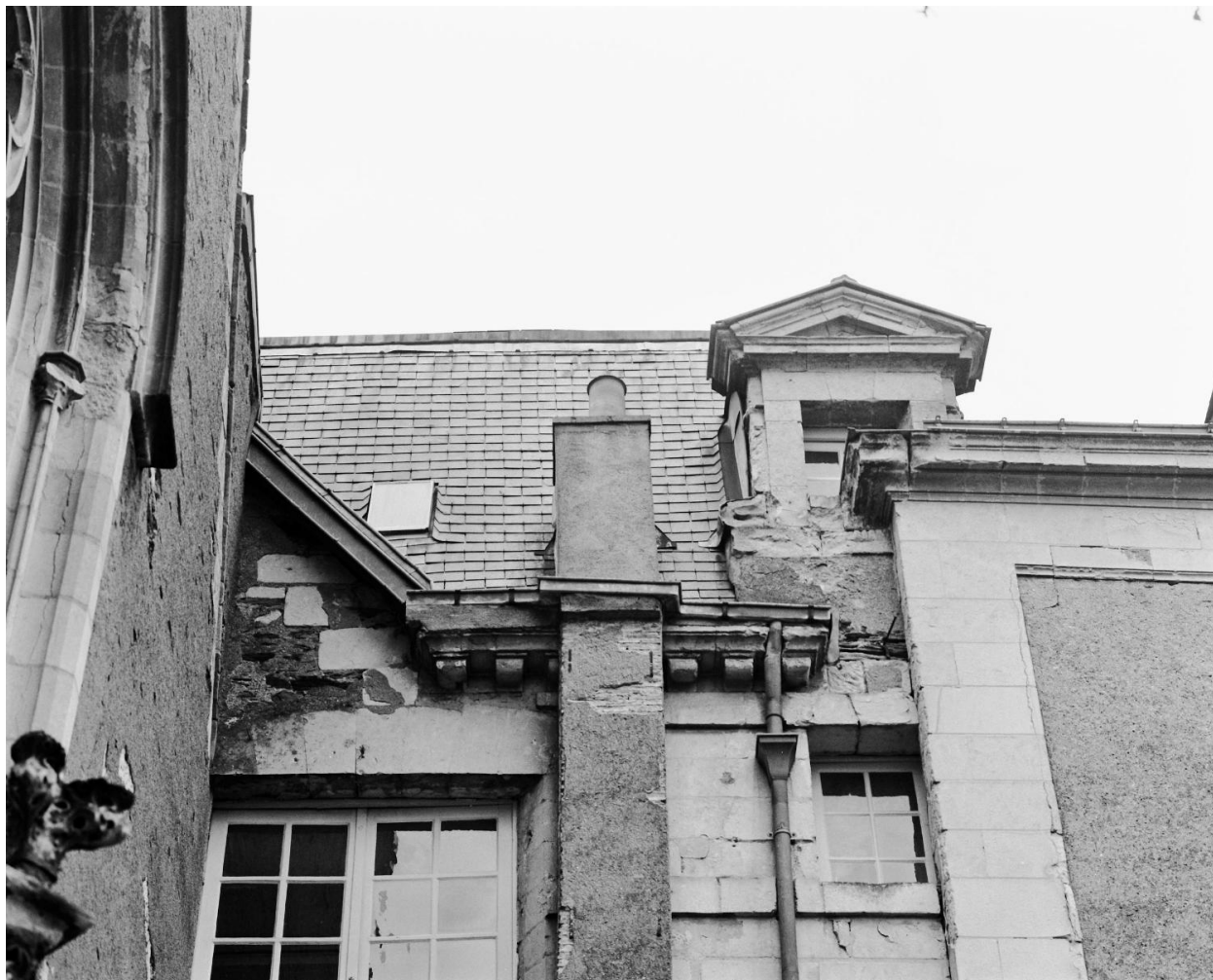
Porterie (entre la chapelle à gauche et le pensionnat à droite) : élévation ouest, partie haute.
