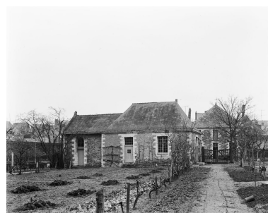
Chapelle et maison dite du Souvenir : façade ouest. A l'arrière- plan, bâtiment de la basse-cour. Phot. François Lasa IVR52_19814900318V
