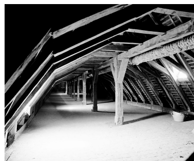
Aile est du cloître (aile du réfectoire), 2e niveau du comble : vue d'ensemble de la charpente, en axe nord-sud. Phot. François Lasa IVR52_19974901366X
