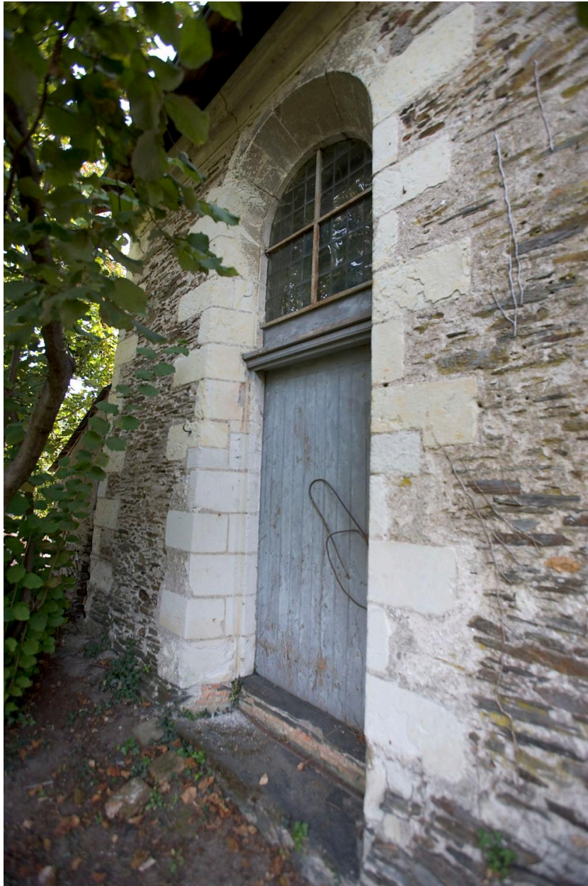
Chapelle adjacente à la maison dite du Souvenir, élévation latérale gauche : ancienne fenêtre transformée en porte.
