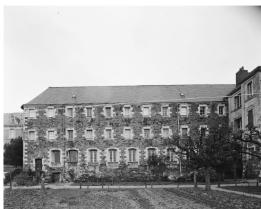
Aile du réfectoire : façade est, sur jardin.
