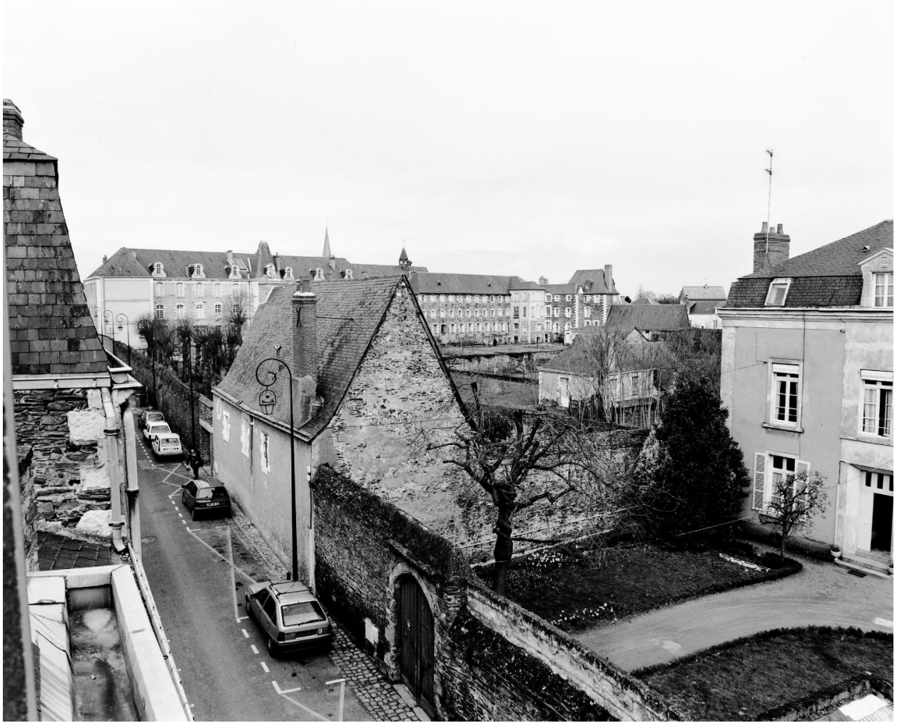
Vue de situation au sud-est, depuis les combles du 2 rue de la Harpe. Au premier plan, maison n° 6 bis rue Vauvert.
