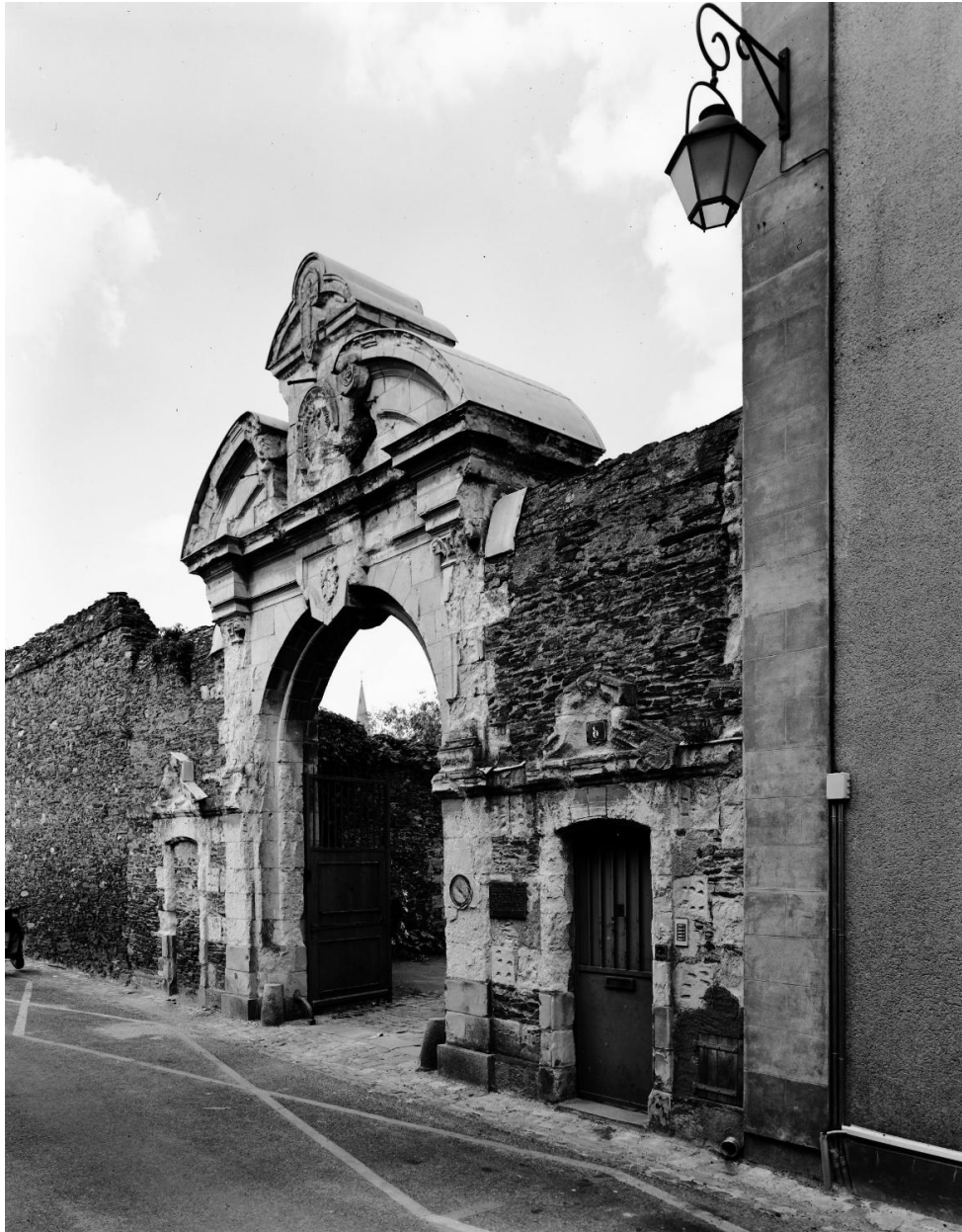
Portail de la cour d'entrée : élévation sur la rue Vauvert.
