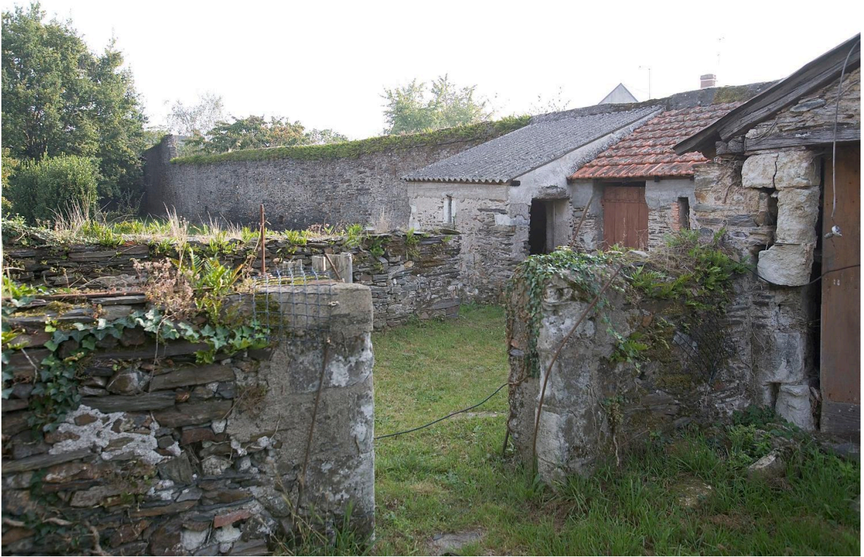
La ferme : bâtiments de dépendances adossé au mur de clôture, au nord du corps d'habitation.
