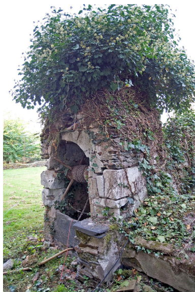
Basse-cour de la ferme : le puits, faisant face à l'angle antérieur gauche du corps d'habitation.
