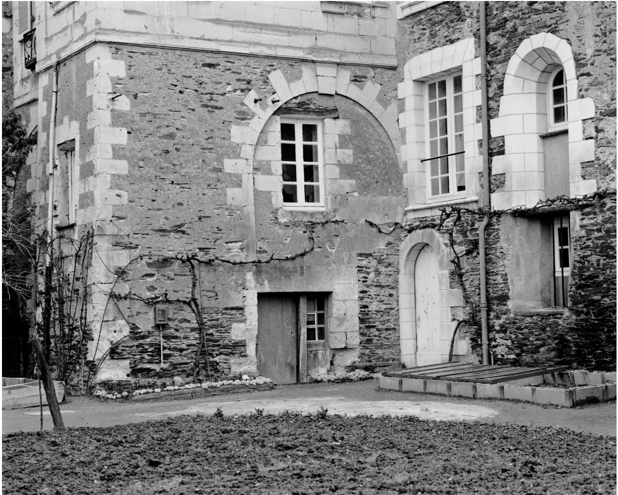
Pavillon du logement de la marquise de Varenne, façade est, 1er niveau : vestiges XVIIe.
