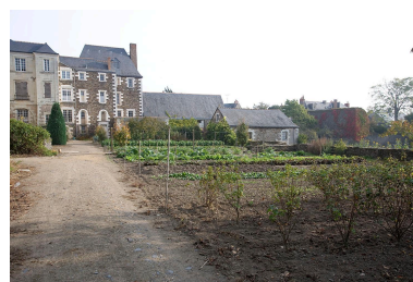
Le jardin potager, avec en arrière- plan de gauche à droite, le pavillon du logement de la marquise de Varenne, le bâtiment des lieux communs et les dépendances attenantes. Phot. François Lasa IVR52_20074901875NUCA
