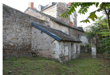
La ferme : un petit bâtiment de dépendances adossé au mur de clôture, au sud du corps d'habitation ; en arrière-plan, un autre bâtiment, en ruines.
