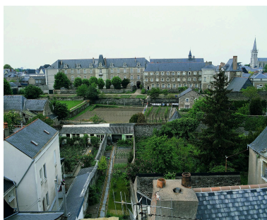
Vue d'ensemble des bâtiments, vers l'est, sur les jardins. Au premier plan, maisons de la rue de l'Hommeau.
