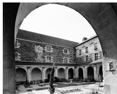
Cour du cloître : ailes est (du réfectoire) et sud (de l'infirmerie). Phot. François Lasa IVR52_19974901350V
