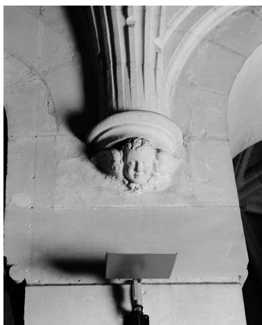
Chapelle de Guéméné, travée d'abside (ouest) : culot antérieur gauche (sud-ouest). Phot. François Lasa IVR52_19974900945X
