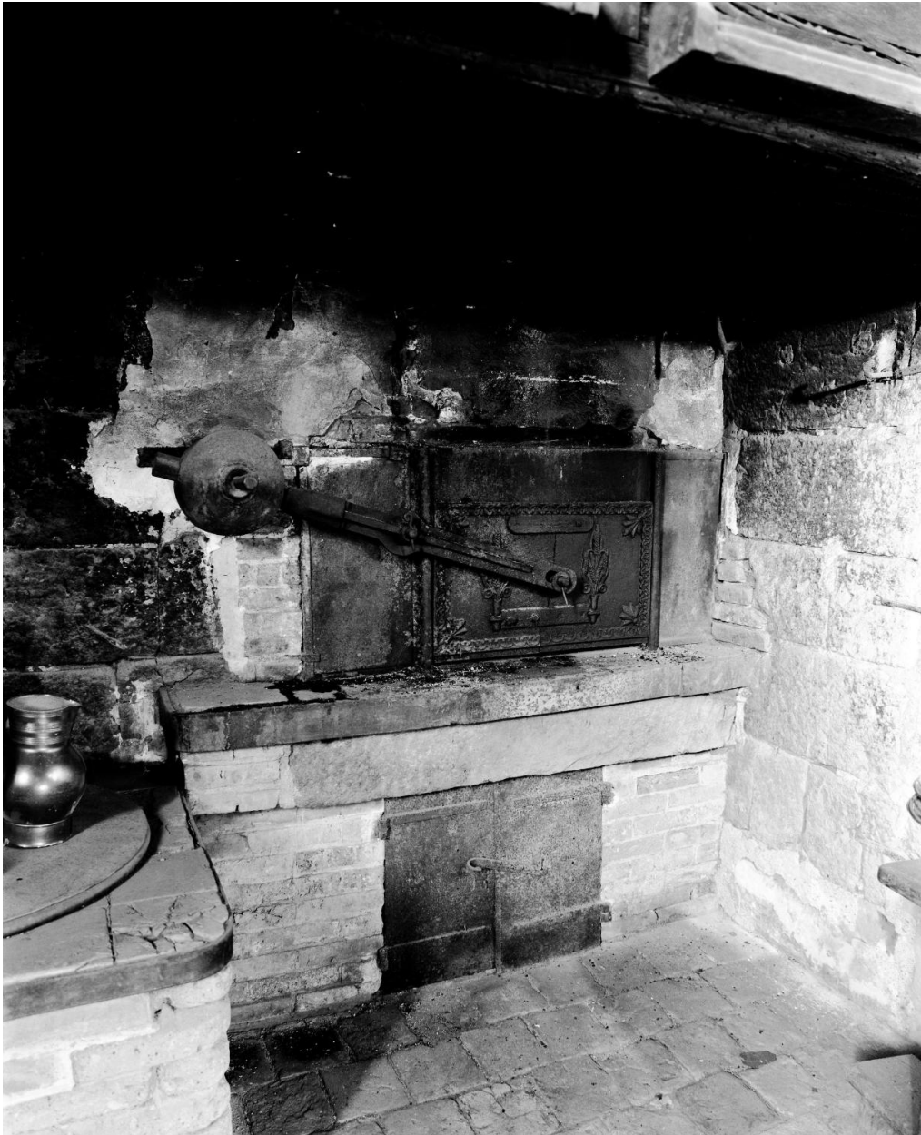
Bâtiment dit des lieux communs, rez-de-chaussée, deuxième boulangerie (sur le plan de 1796), mur est : cheminée, détail sur le four.
