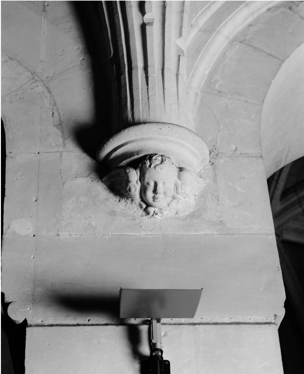
Chapelle de Guéméné, travée d'abside (ouest) : culot antérieur gauche (sud-ouest).
