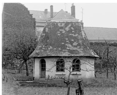
Oratoire Saint-Benoit : façade sud. Phot. François Lasa IVR52_19814900442X
