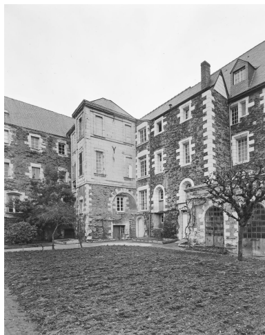
Pavillon du logement de la marquise de Varenne, entre aile du réfectoire et bâtiment dit des lieux communs : façades sur jardin.
