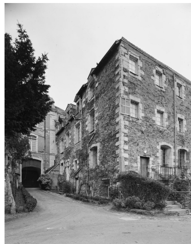
Porterie, façade est (à gauche), bâtiment de l'infirmerie, façades sud (au centre), et extrémité de l'aile du réfectoire, façade est (à droite).
