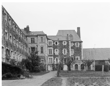
Aile du réfectoire, pavillon du logement de la marquise de Varenne et bâtiment des lieux communs : façades sur jardin.
