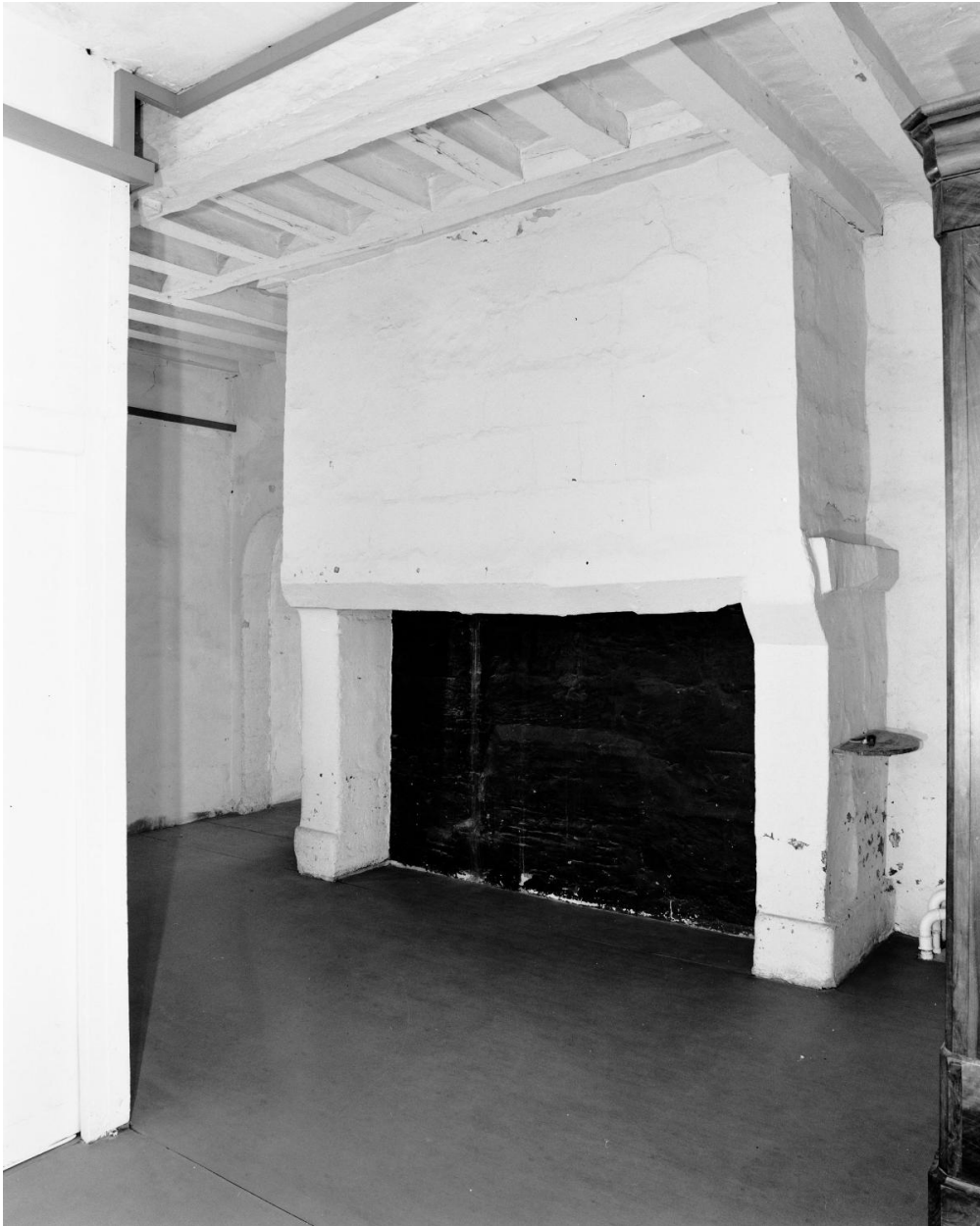
Aile est du cloître, deuxième étage, cellule d'angle nord-est (cloisons aujourd'hui disparues) : cheminée appuyée au mur est.
