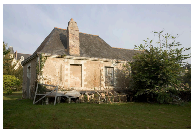
Maison dite maison du Souvenir : élévation postérieure depuis la basse-cour de la ferme. Phot. François Lasa IVR52_20074901868NUCA
