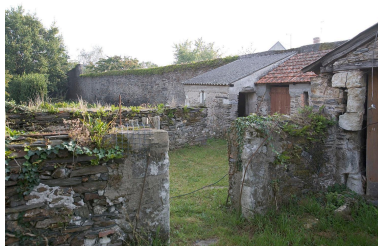
La ferme : bâtiments de dépendances adossés au mur de clôture, au nord du corps d'habitation.
