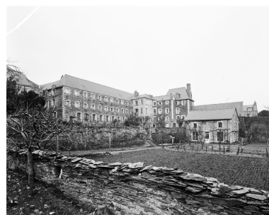
Aile du réfectoire, pavillon du logement de la marquise de Varenne et bâtiment des lieux communs : vue d'ensemble, du sud-est.
