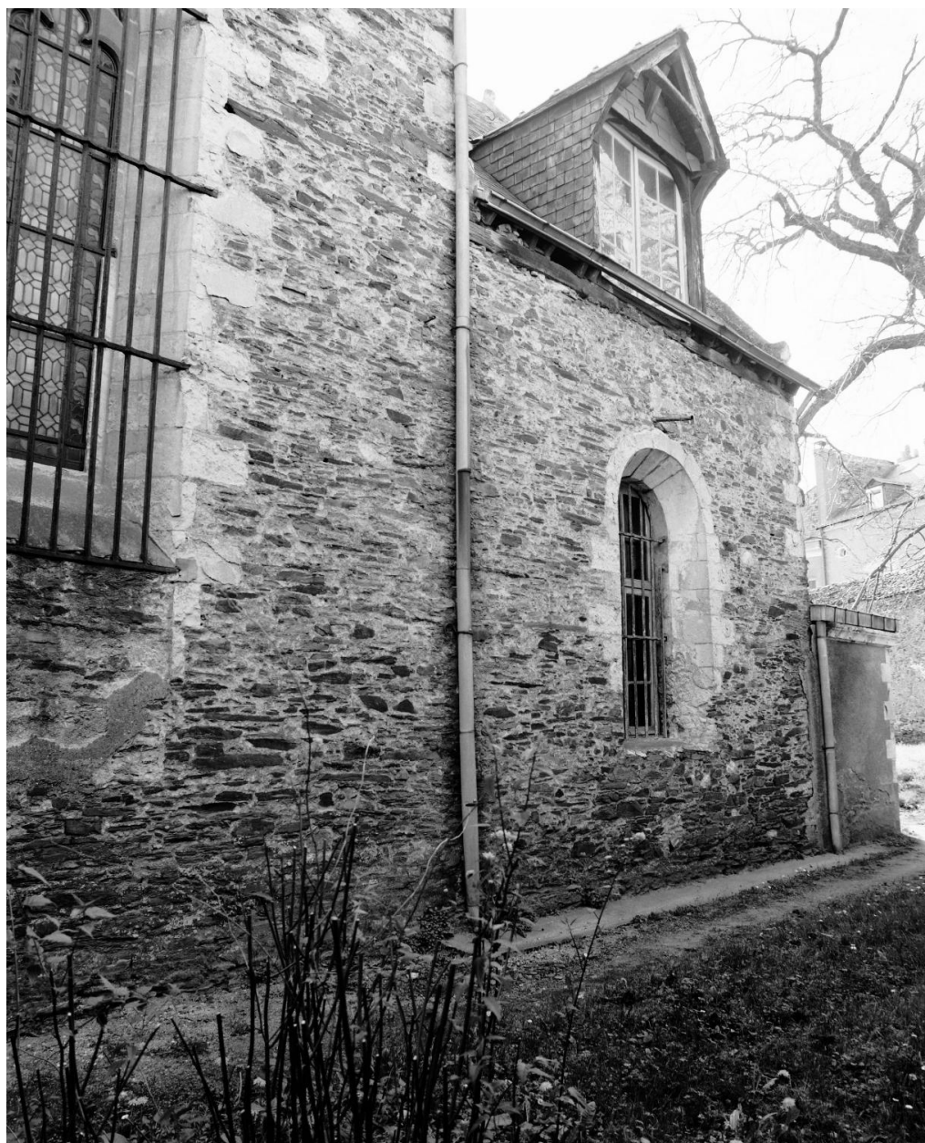
La grande sacristie : élévation nord.
