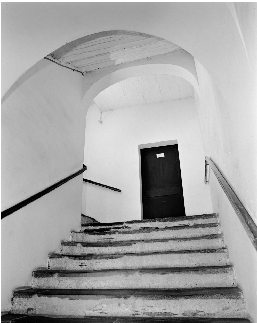
Aile nord du cloître (aile du chapitre), escalier est : première volée.
