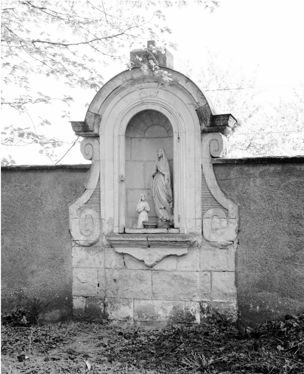
Le pensionnat, mur de clôture séparant le jardin de ce dernier de celui du couvent lui-même : niche faisant face à l'avant-corps central.
