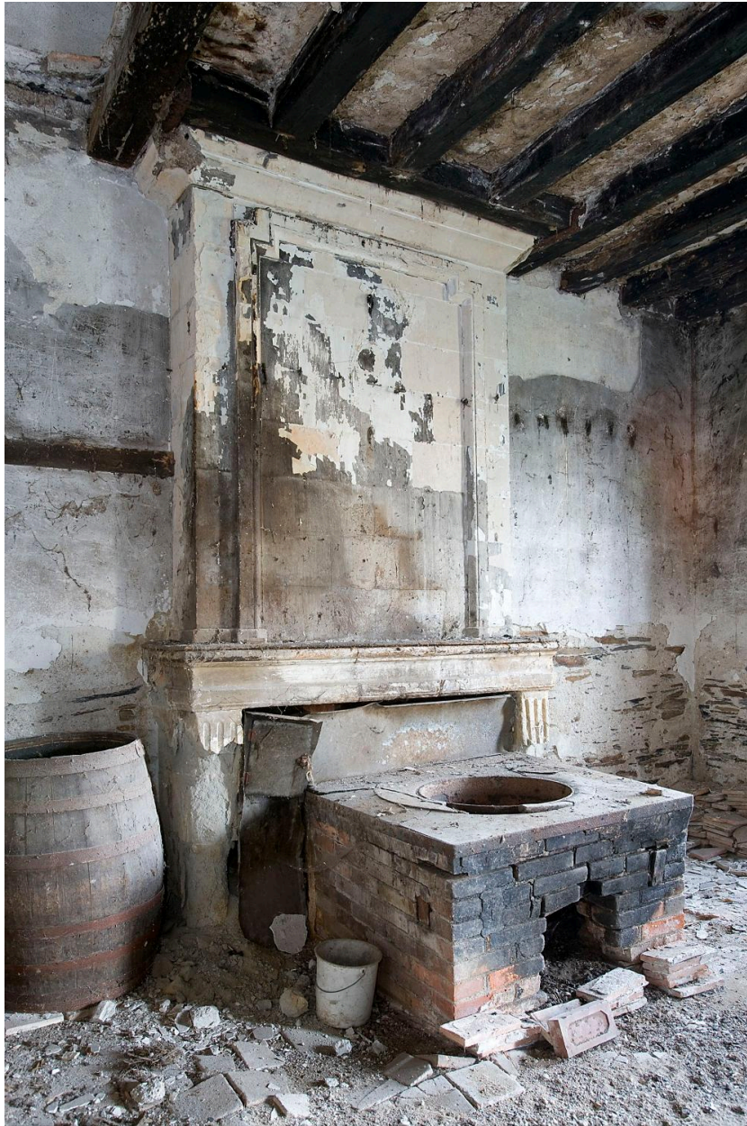
La ferme, corps d'habitation, rez-de-chaussée, pièce droite, mur latéral droit : cheminée.
