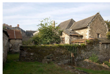
Chapelle (chevet droit et élévation latérale droite) et maison dite du Souvenir, vue d'ensemble depuis les dépendances nord de la ferme. Phot. François Lasa IVR52_20074901869NUCA
