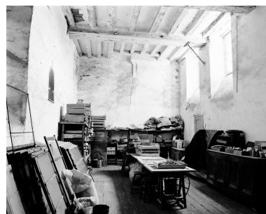
Bâtiment dit des lieux communs, rez-de-chaussée, pièce est : vue d'ensemble, d'ouest en est. Phot. François Lasa IVR52_19974901373X
