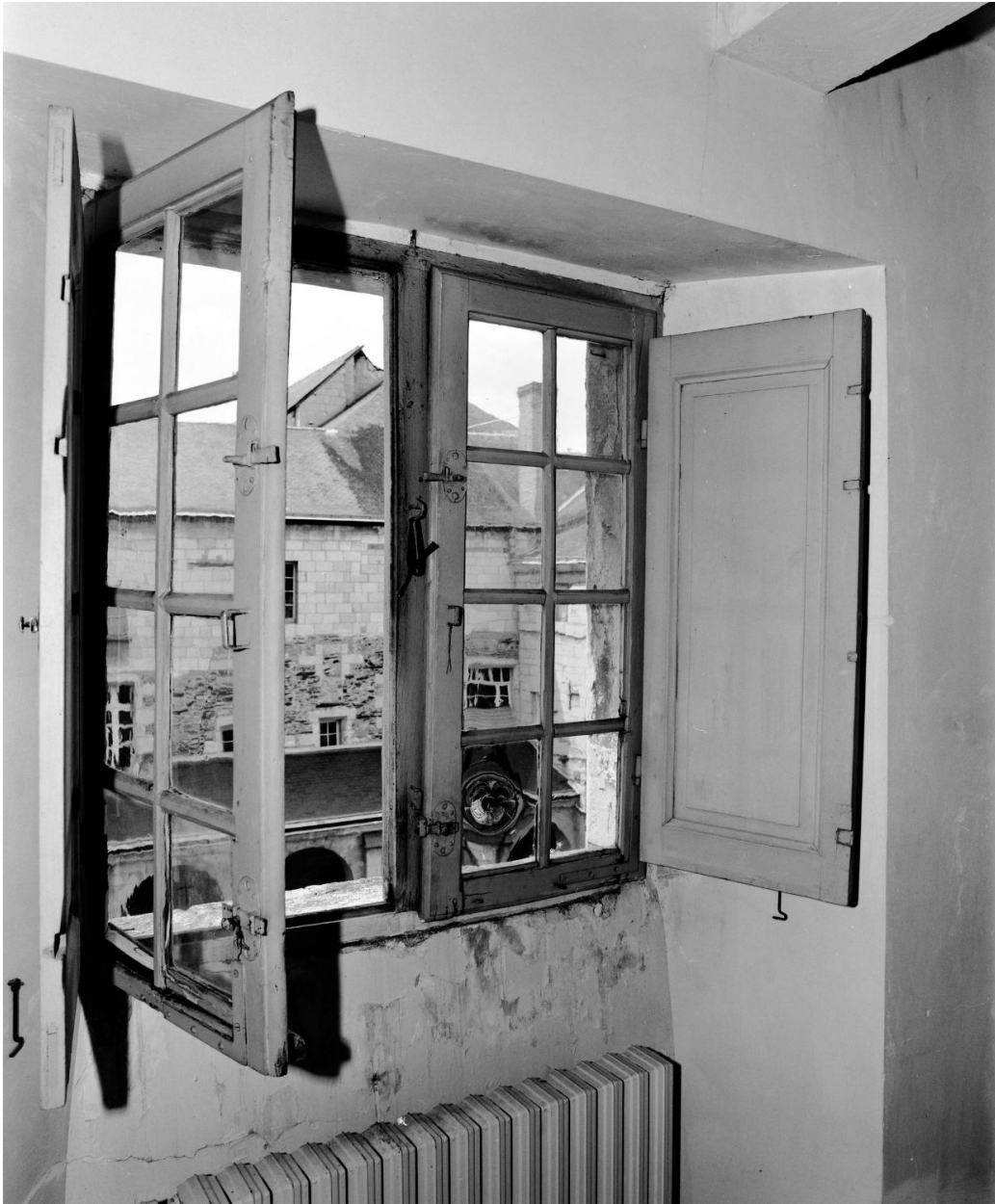
Aile nord du cloître (aile du chapitre), corridor : troisième fenêtre depuis l'ouest, avec quelques carreaux en verre d'origine.
