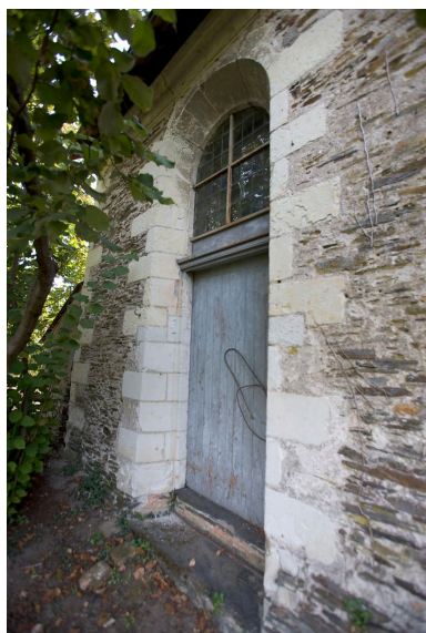
Chapelle adjacente à la maison dite du Souvenir, élévation latérale gauche : ancienne fenêtre transformée en porte. Phot. François Lasa IVR52_20074901873NUCA
