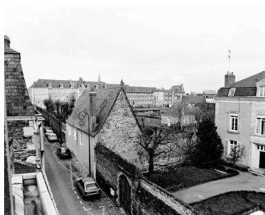
Vue de situation au sud-est, depuis les combles du 2 rue
