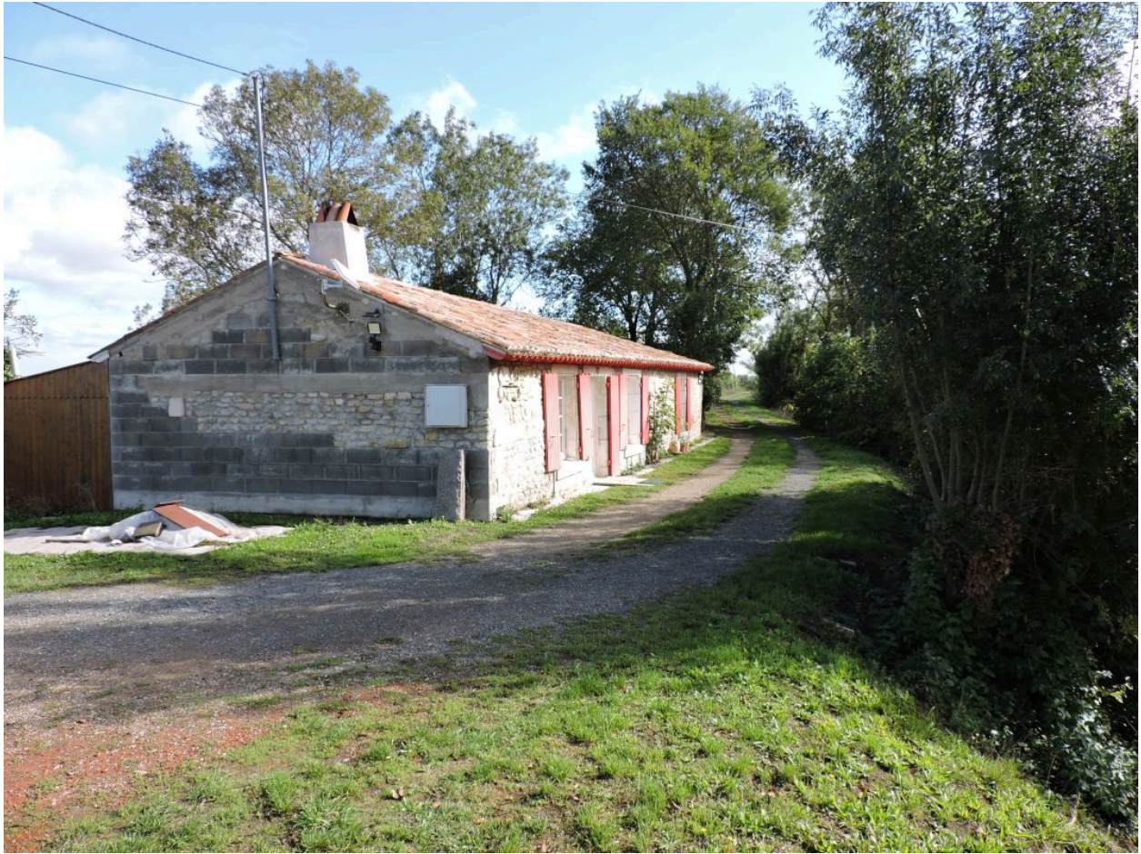
La hutte, sur la digue, vue depuis l'ouest.
