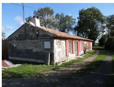
La digue vue depuis l'ouest. Phot. Yannis Suire IVR52_20198503149NUCA
