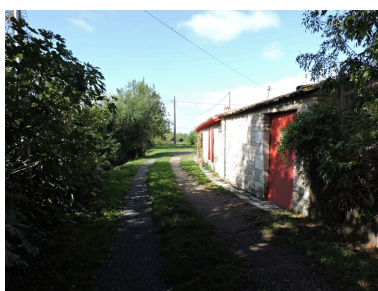
La hutte vue depuis l'est. Phot. Yannis Suire IVR52_20198503153NUCA
