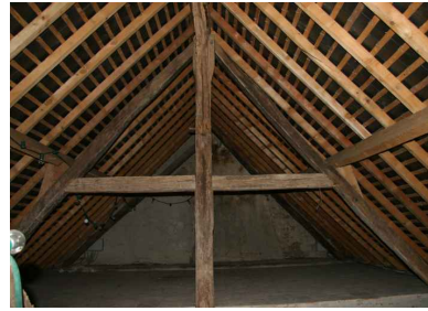
Charpente de la maison. Phot. Jean-Baptiste Darrasse IVR52_20067206639NUCA
