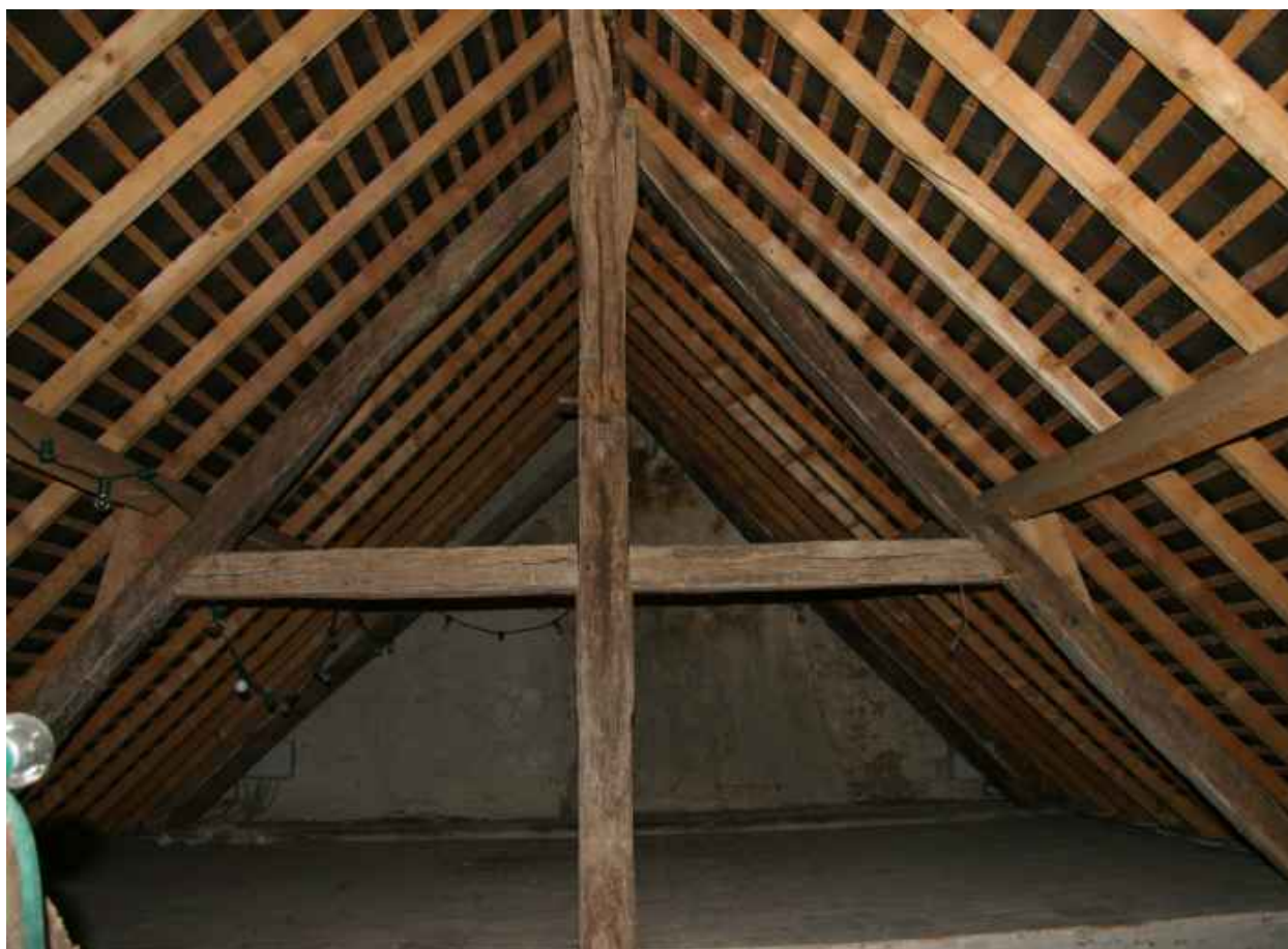
Charpente de la maison.
