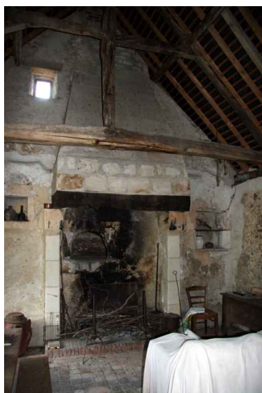
Habitation du meunier : cheminée avec four. Phot. Jean-Baptiste Darrasse IVR52_20067206628NUCA
