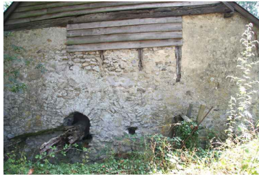
Pignon du moulin : vestige d'un pan-de-bois ? Phot. Jean-Baptiste Darrasse IVR52_20067206643NUCA
