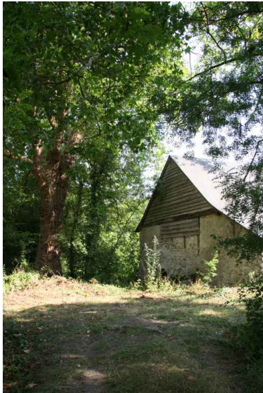
Pignon du moulin sur le bief. Phot. Jean-Baptiste Darrasse IVR52_20067206625NUCA
