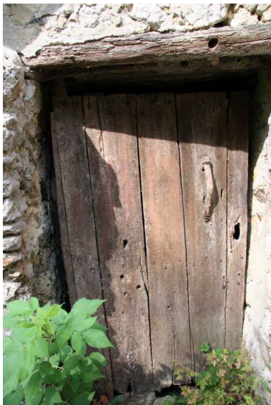
Porte d'entrée. Phot. Jean-Baptiste Darrasse IVR52_20067206641NUCA
