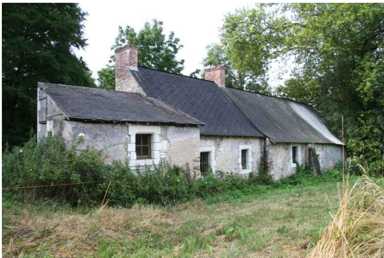
Façade postérieure (nord).
