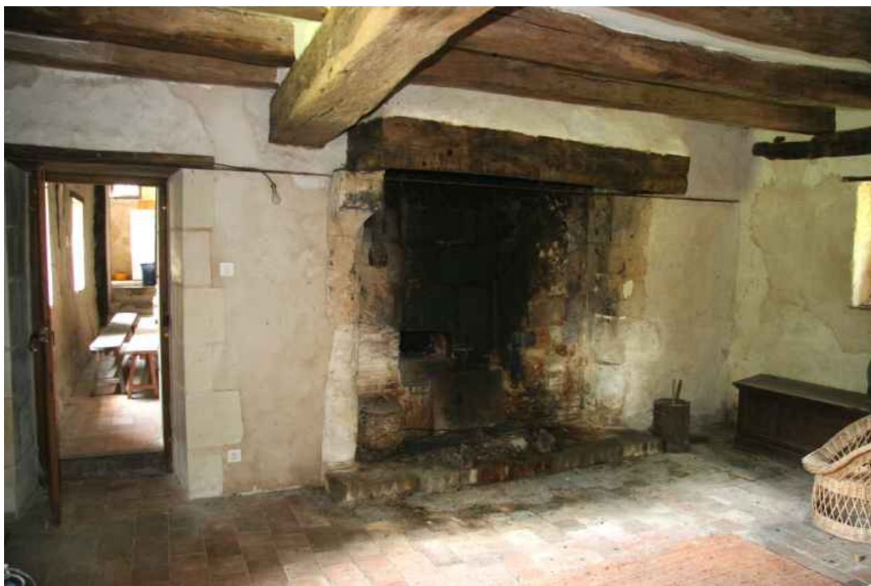
Habitation du meunier, salle centrale : cheminée.
