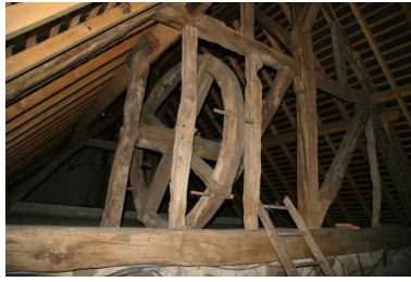
Roue pour manier les meules. Phot. Jean-Baptiste Darrasse IVR52_20067206640NUCA
