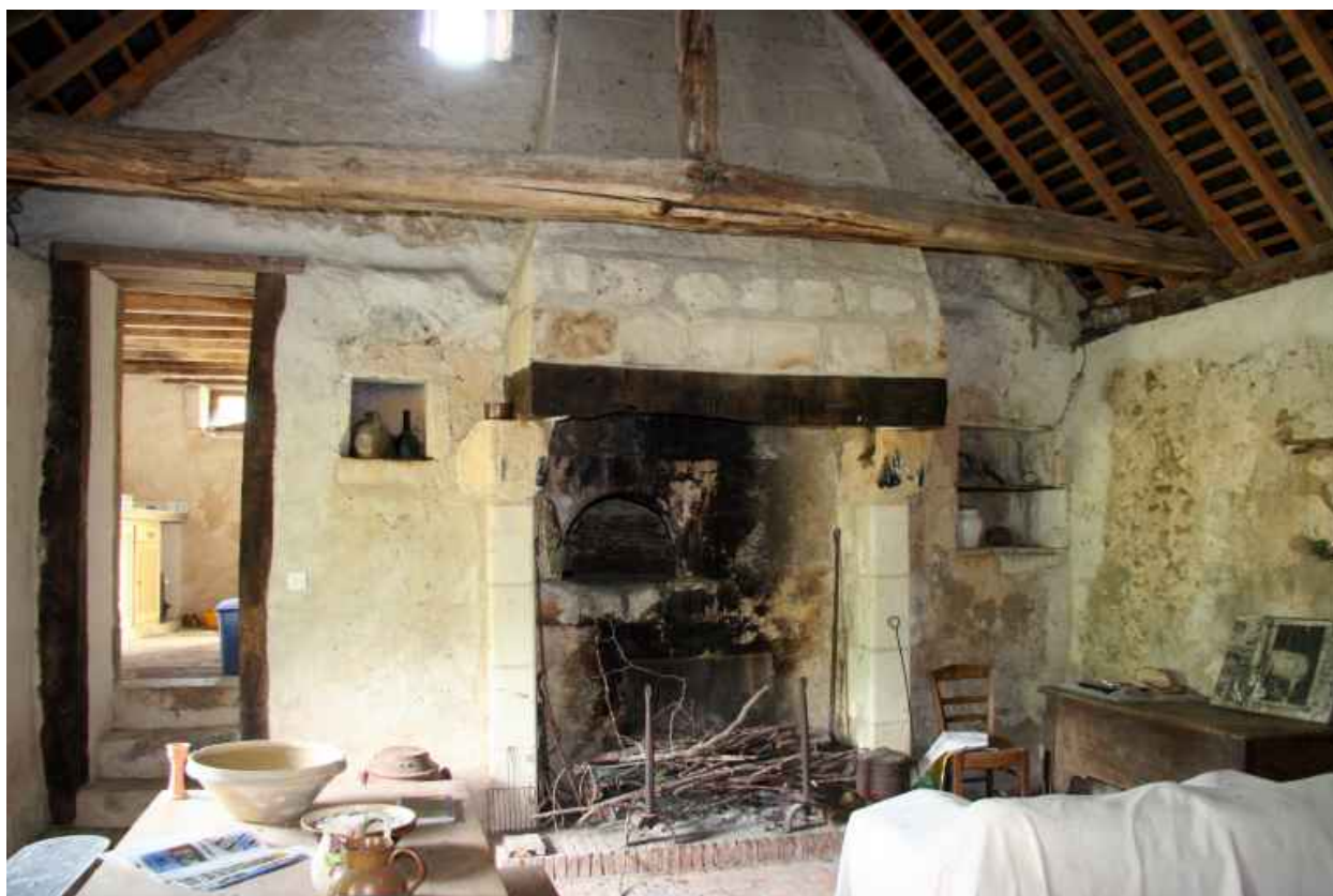
Habitation du meunier : salle sous charpente.
