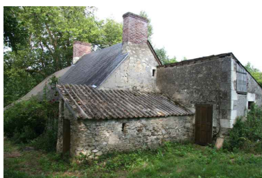
Pignon est : appenti couvert de tuiles courbes. Phot. Jean-Baptiste Darrasse IVR52_20067206631NUCA
