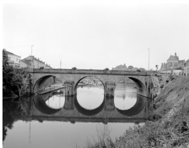
Vue d'amont. Phot. François Lasa IVR52_20025301215X
