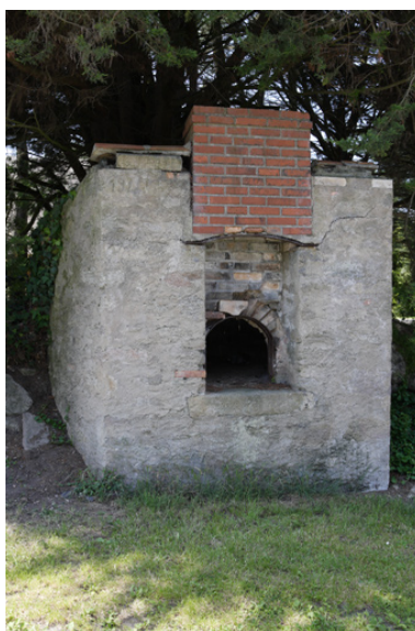
Le four à pain. Phot. Denis Pillet IVR52_20084401776NUCA
