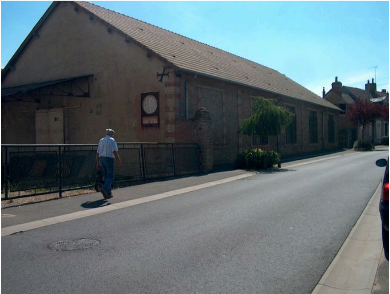
Vue d'ensemble de l'usine.
