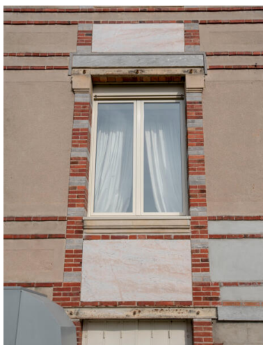
Un détail des décors en tuiles et marbres. Phot. Pierre-Bernard Fourny IVR52_20235300137NUCA
