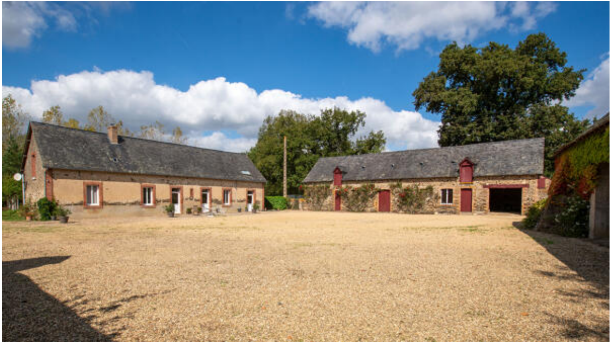
Les corps ouest et nord, logement et dépendances.
