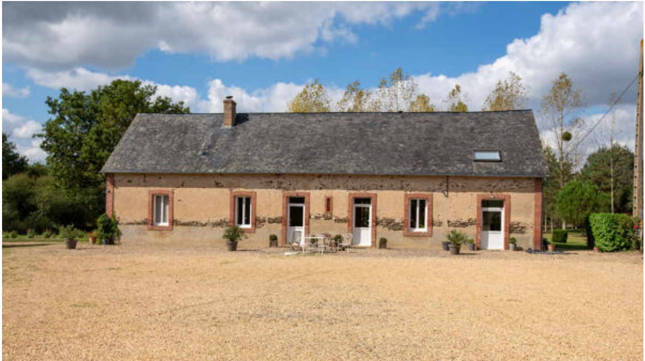
Le corps ouest, logement.
