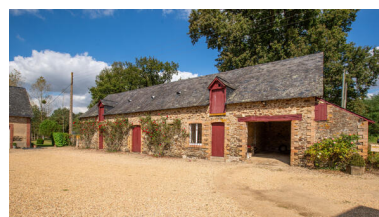
Le corps nord, dépendances. Phot. Pierre-Bernard Fourny IVR52_20235301513NUCA
