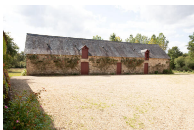
Le corps sud, dépendances. Phot. Pierre-Bernard Fourny IVR52_20235301515NUCA
