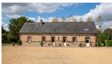
Le corps ouest, logement. Phot. Pierre-Bernard Fourny IVR52_20235301514NUCA
