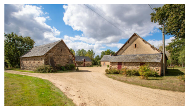
Une vue d'ensemble de la ferme. Phot. Pierre-Bernard Fourny IVR52_20235301512NUCA
