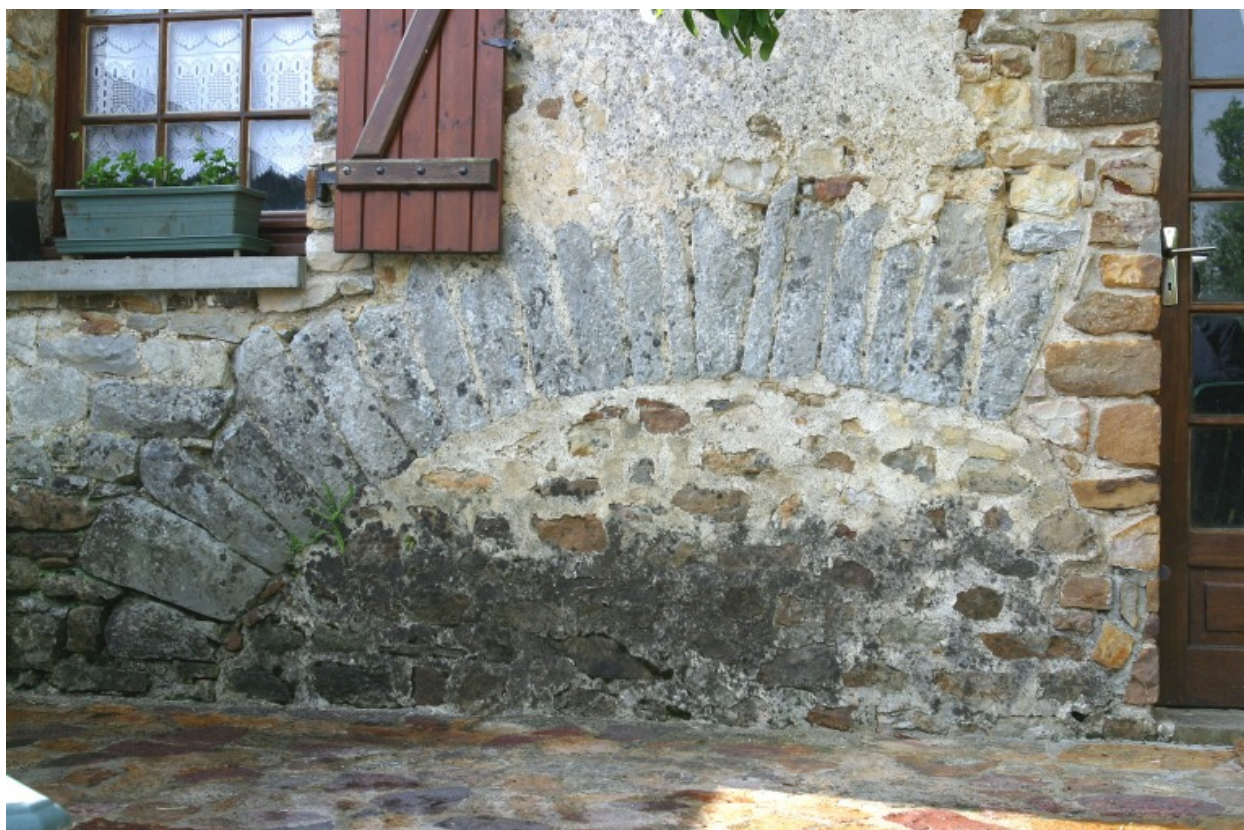
Détail de la façade nord : l'ouverture amont du coursier.
