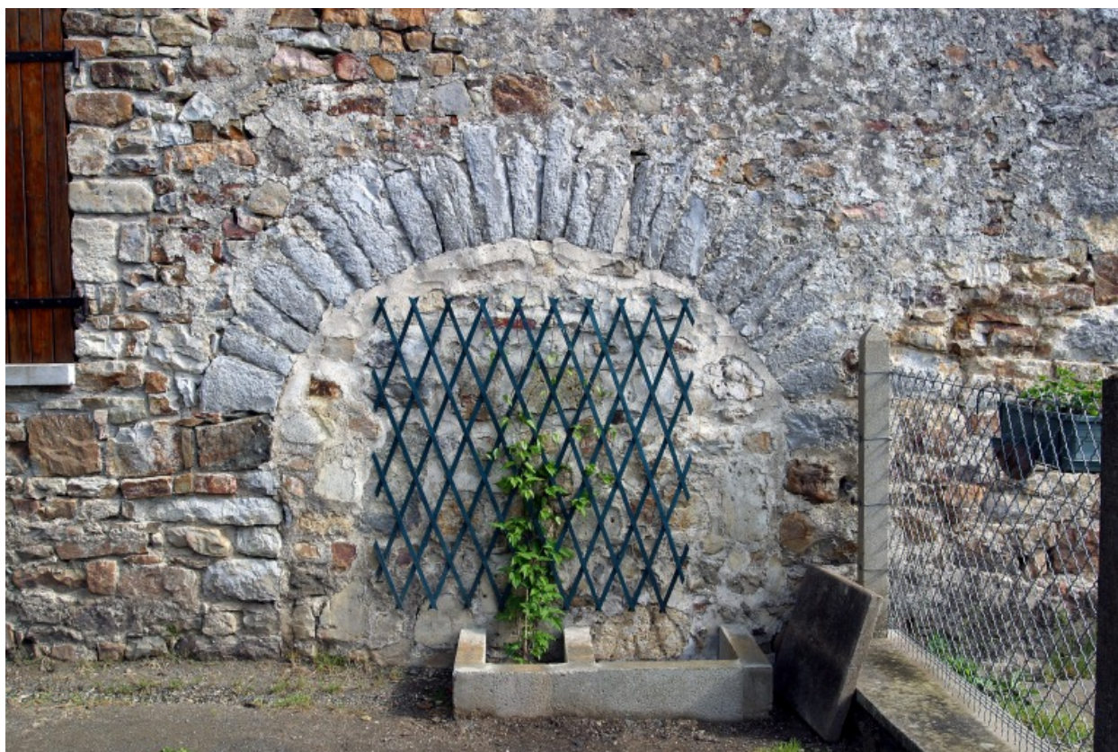
Détail de la façade sud : l'ouverture d'aval du coursier.
