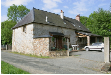
Les élévations est et nord. Phot. François Lasa IVR52_20035301690NUCA
