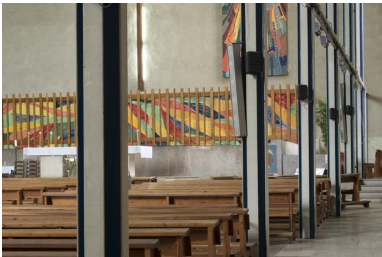
Vue de la charpente métallique avec l'autel en fond.
