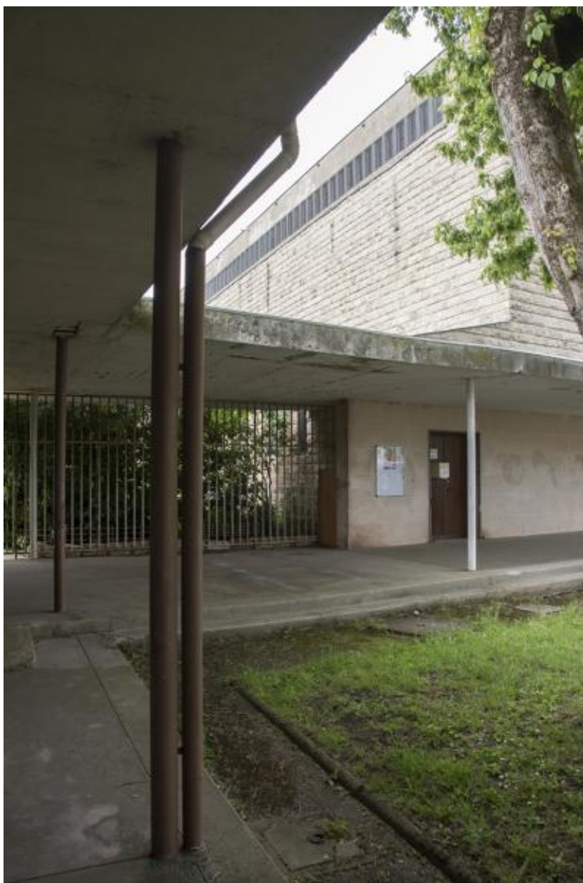
Vue du porche de l'église depuis les salles de catéchisme.
