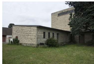
Vue de la sacristie en extérieur. Phot. Bruno Rousseau IVR52_20217200548NUCA
