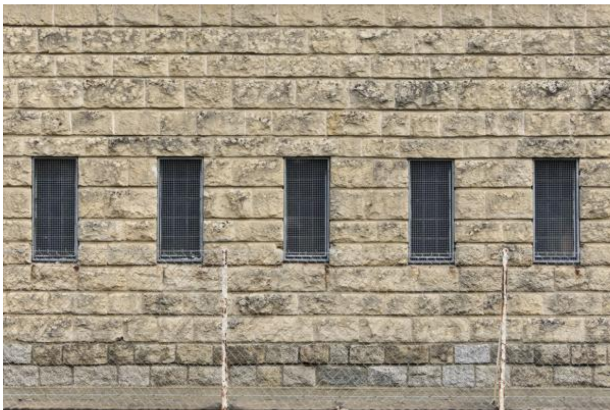
Détail des ouvertures de la sacristie.
