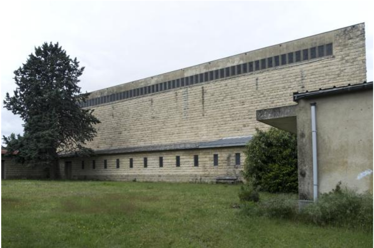
Vue de la façade latérale est.
