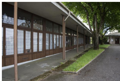
Vue des salles de catéchisme. Phot. Bruno Rousseau IVR52_20217200541NUCA
