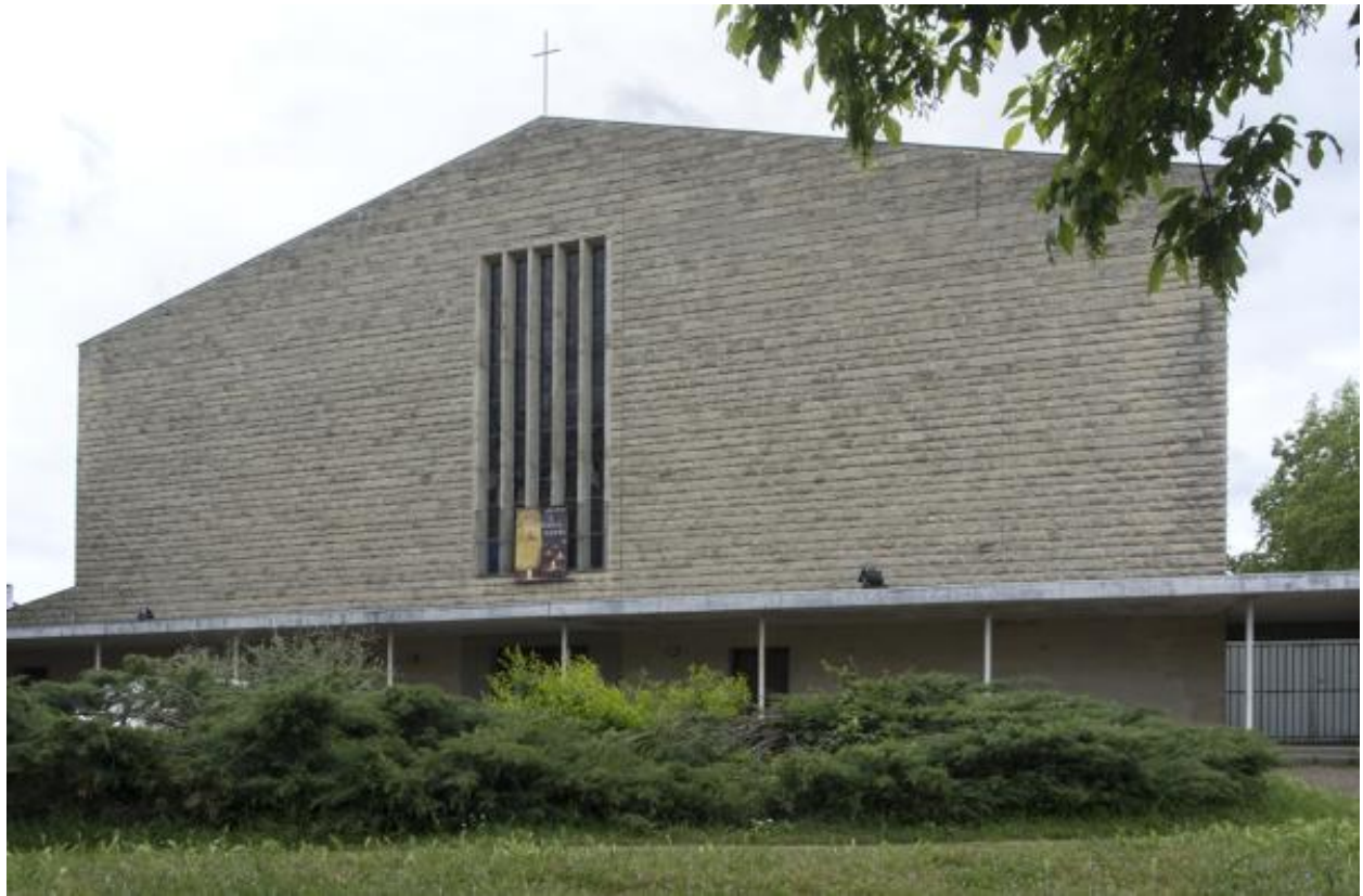
Vue de la façade principale de l'église.
