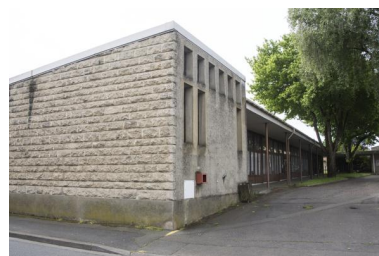
Vue de l'aile est comprenant les salles de catéchisme depuis le parvis. Phot. Bruno Rousseau IVR52_20217200534NUCA
