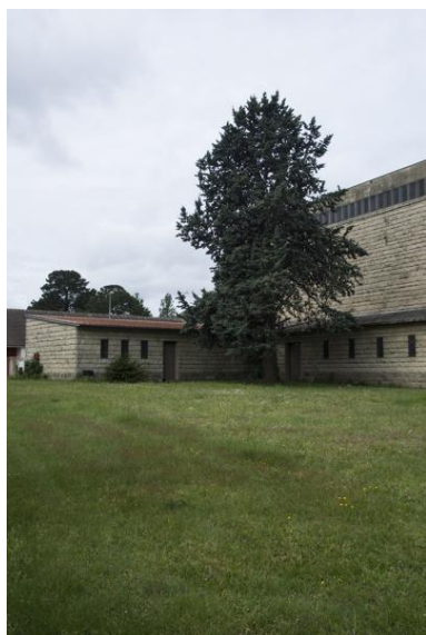
Vue de la cour adjacente à l'église. Phot. Bruno Rousseau IVR52_20217200544NUCA
