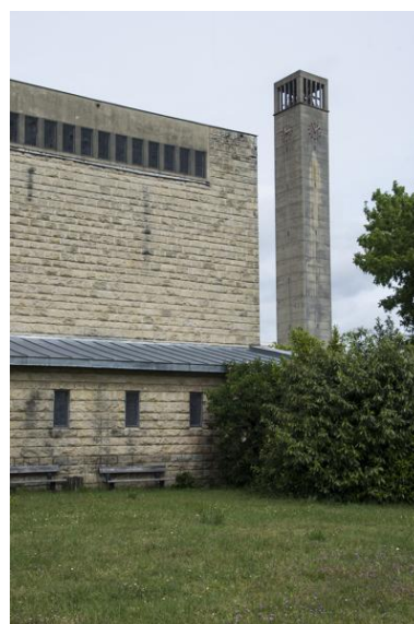
Vue du campanile depuis la cour adjacente à l'église. Phot. Bruno Rousseau IVR52_20217200545NUCA
