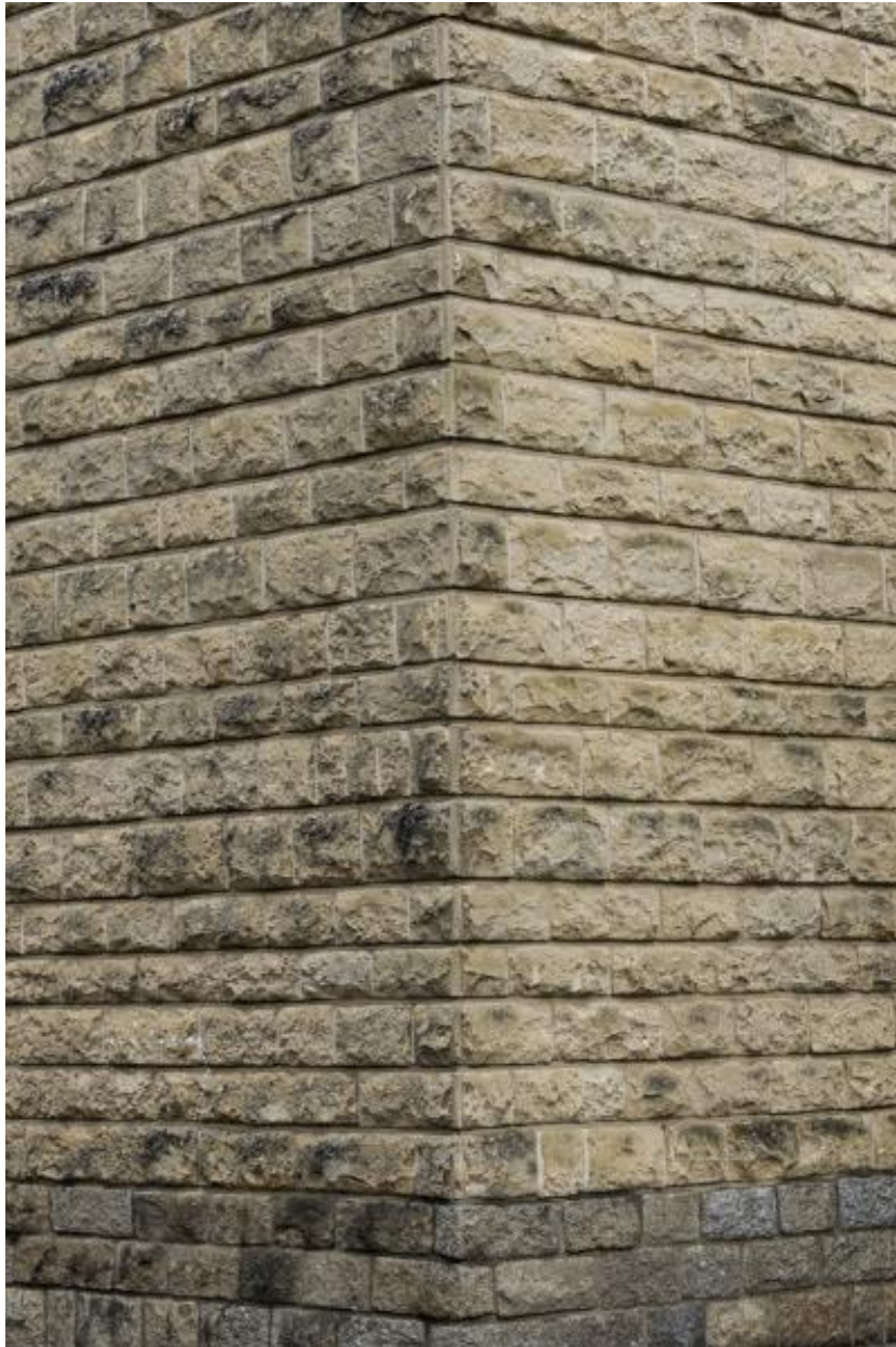
Vue des pierres en parement à l'angle de la façade arrière et de la façade ouest.
