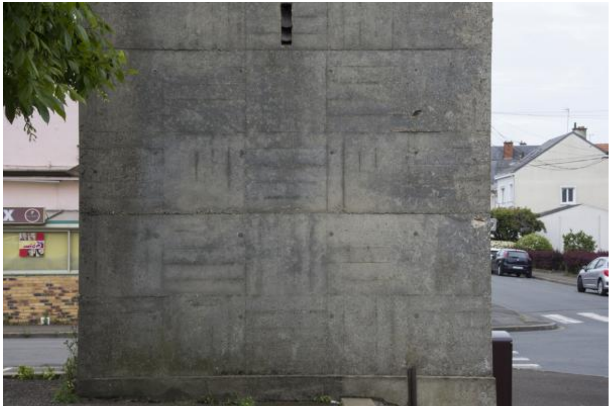
Vue du coffrage béton sur le campanile.
