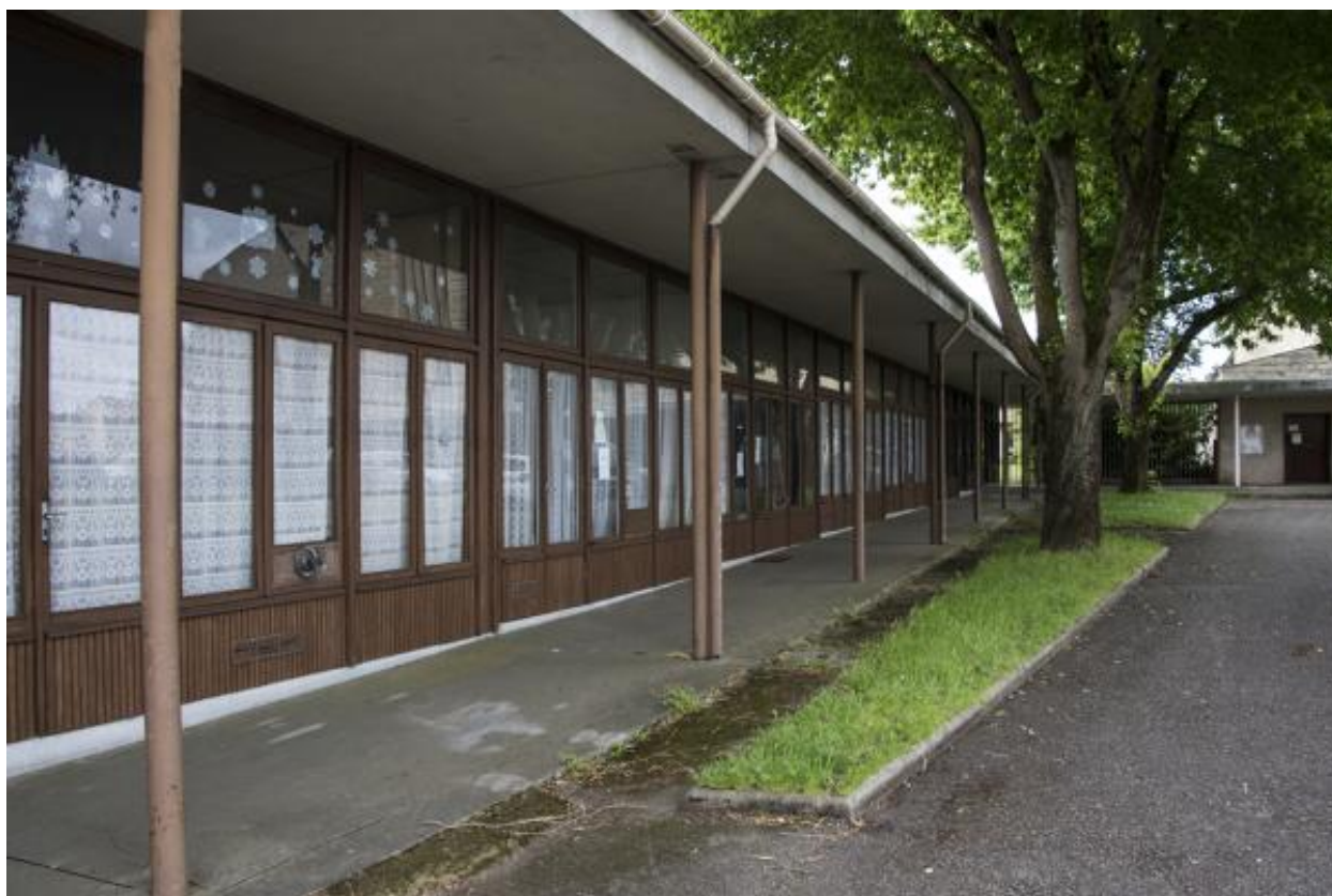
Vue des salles de catéchisme.
