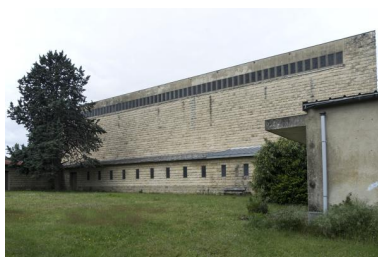
Vue de la façade latérale est. Phot. Bruno Rousseau IVR52_20217200543NUCA
