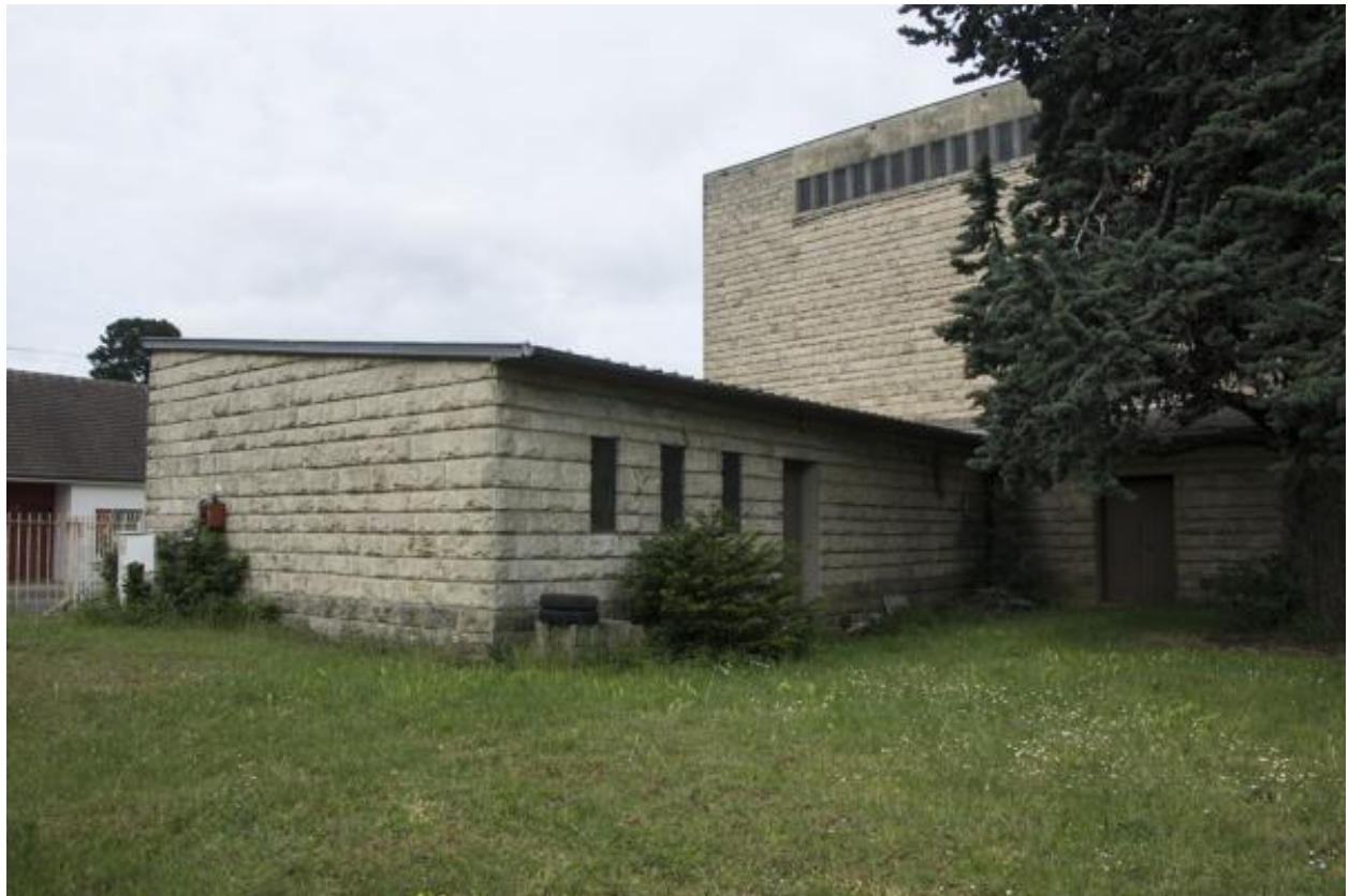
Vue de la sacristie en extérieur.
