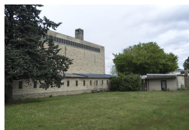
Vue de la façade latérale est depuis la cour adjacente à l'église. Phot. Bruno Rousseau IVR52_20217200547NUCA
