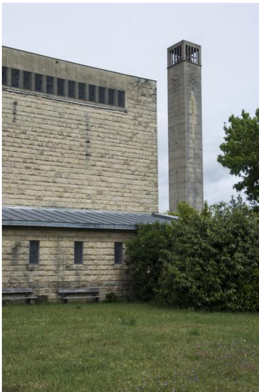
Vue du campanile depuis la cour adjacente à l'église.
