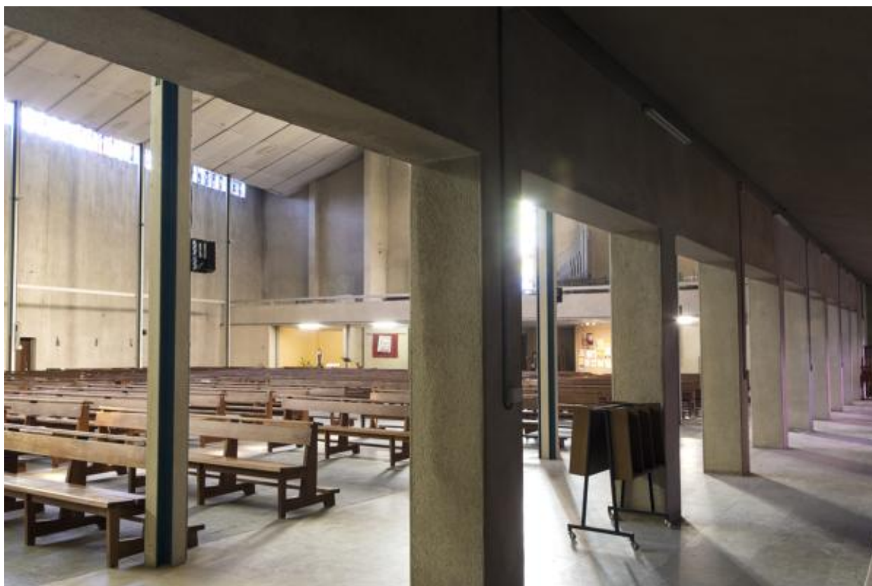
Vue de la nef depuis le bas-côté est.
