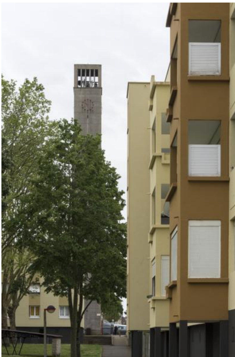
Vue du campanile depuis le Ronceray.
