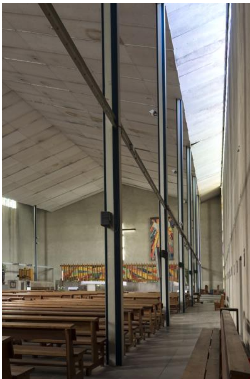
Vue du bas côté ouest formé par la charpente métallique.
