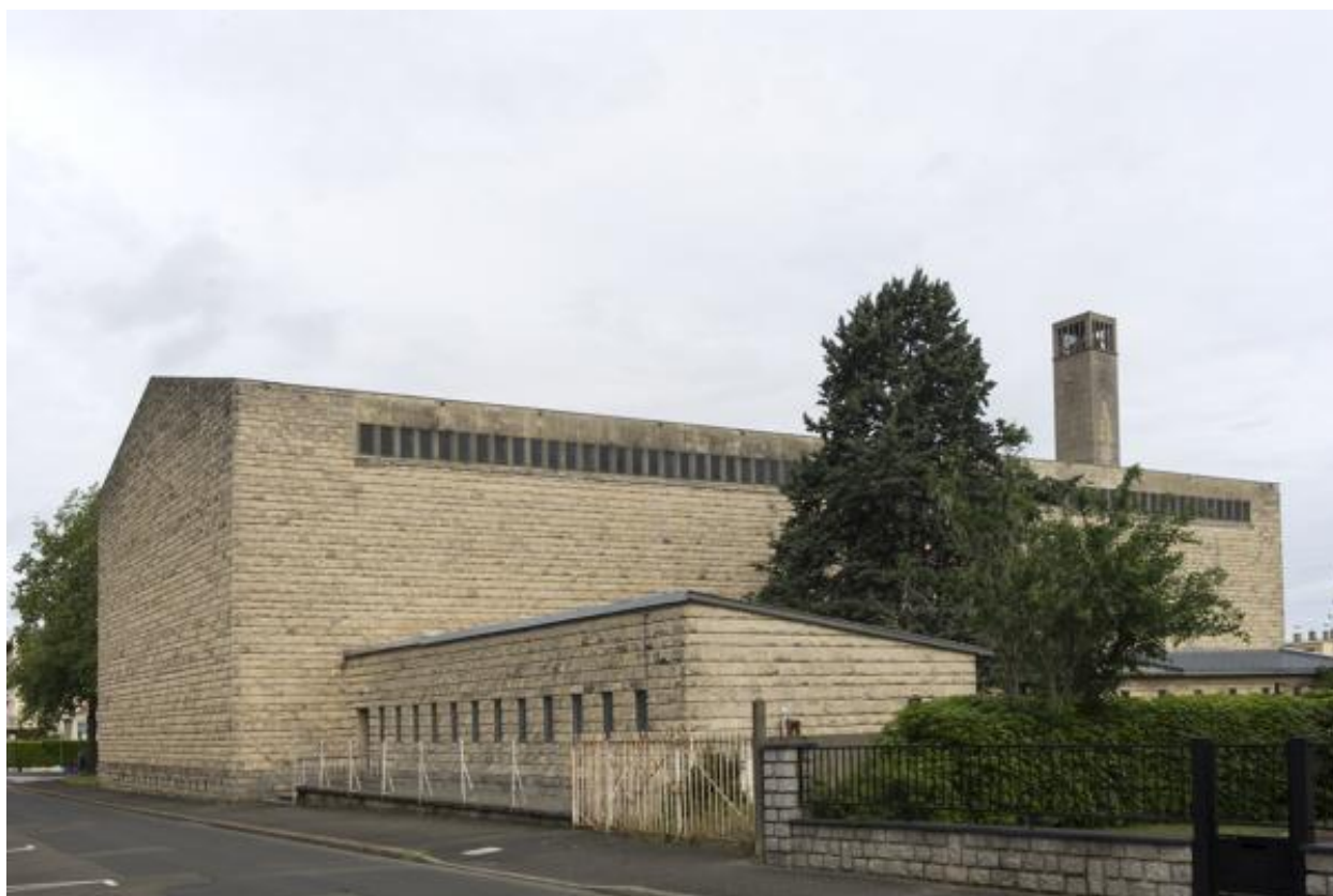
Vue de l'église depuis le sud-est.
