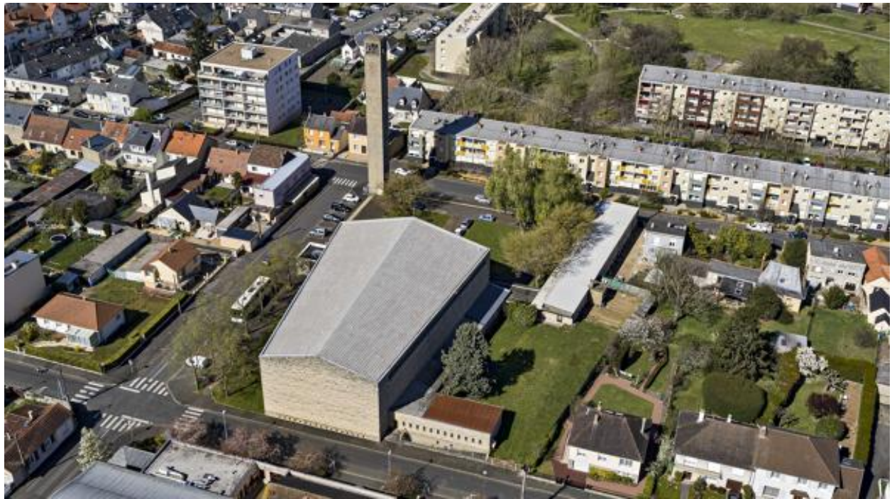
Vue aérienne de l'église Sainte-Thérèse depuis le sud-est.
