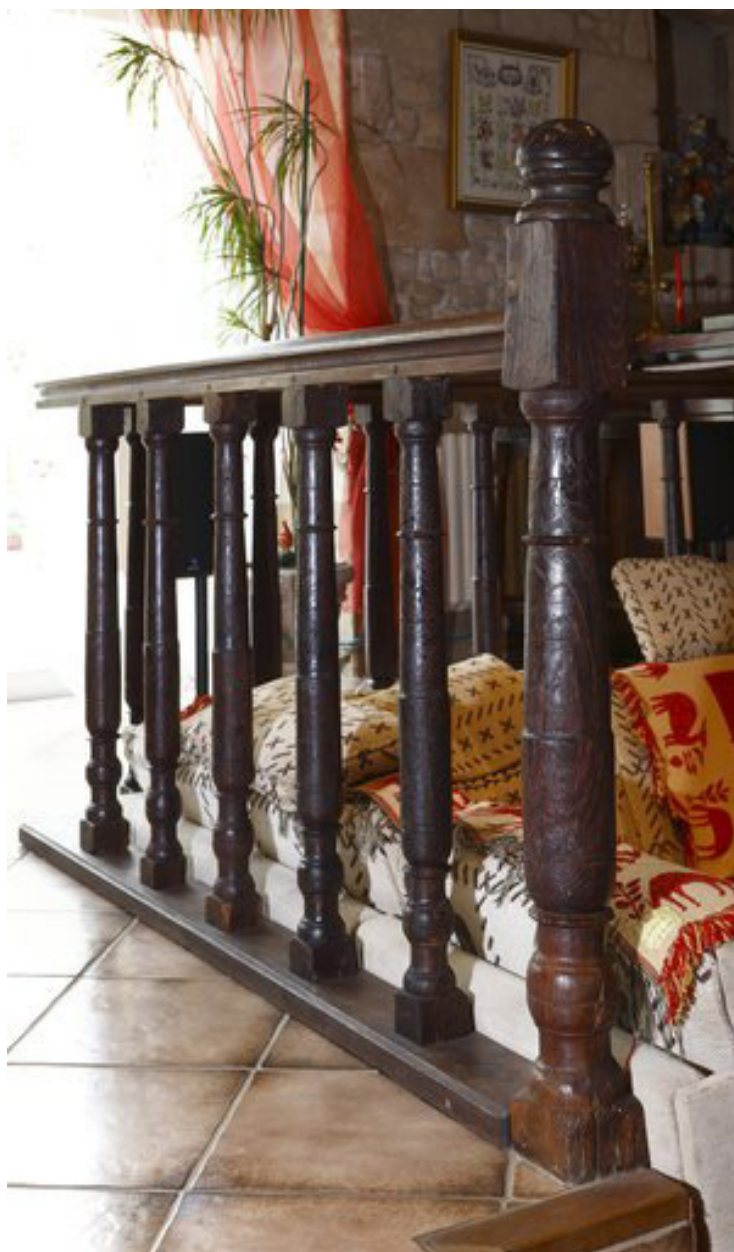
Vestiges de l'escalier d'origine, réutilisés en balustrade dans le salon.
