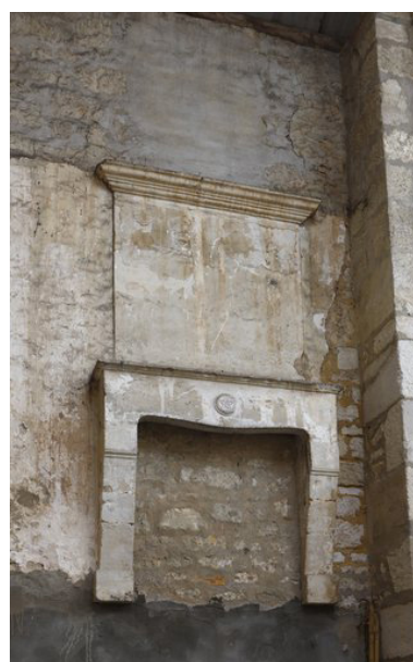
Cheminée à l'étage du bâtiment (partiellement détruit) en fond de parcelle, donnant sur la rue Emile-Zola. Phot. Patrice Giraud IVR52_20098500103NUCA
