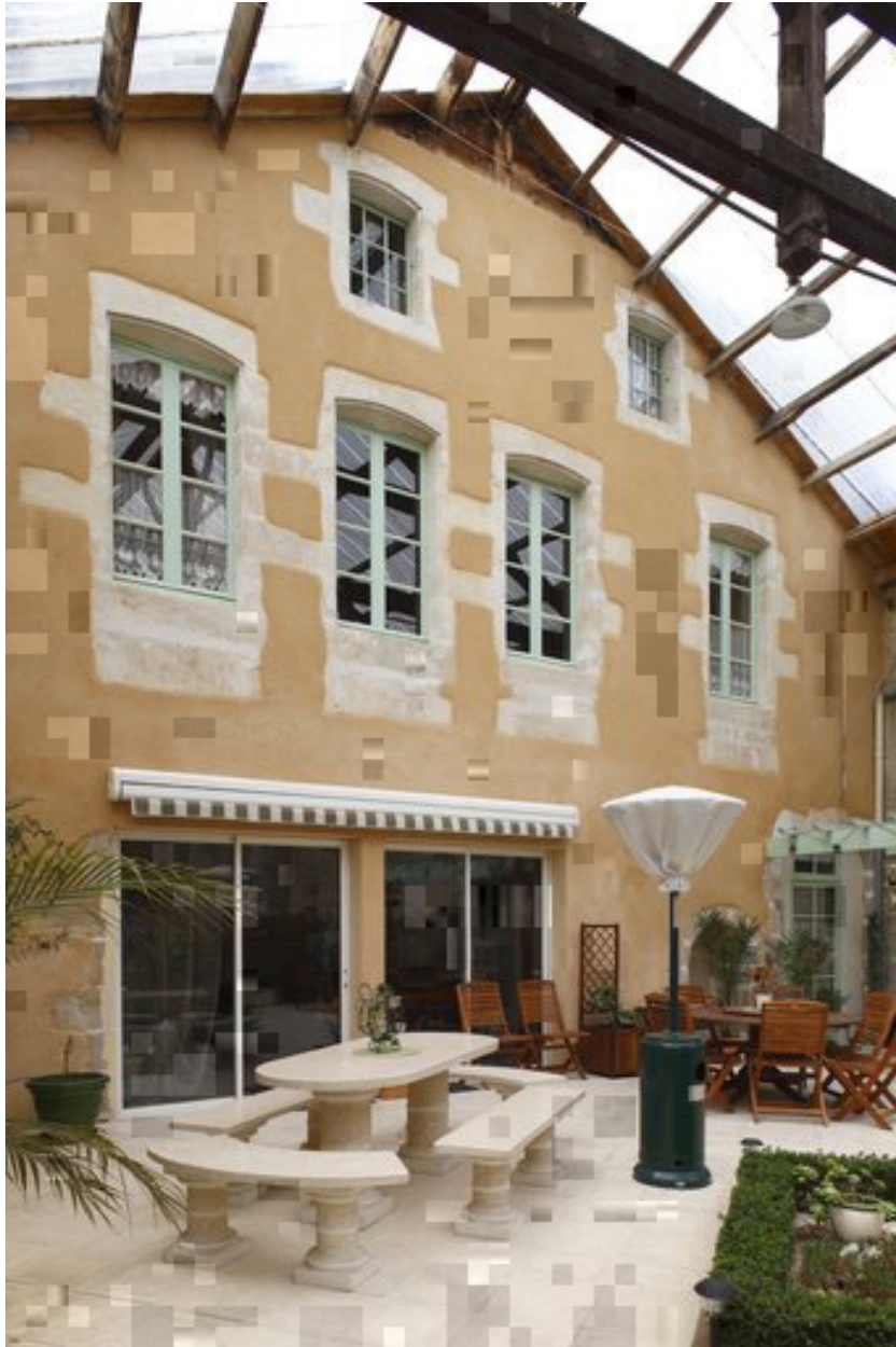
Façade arrière, sur cour, de la maison. La pente de la verrière masque en partie le mur gouttereau et lui donne l'apparence d'un pignon.
