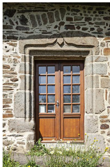
Porte est de la maison sud. Phot. Yves Guillotin IVR52_20215300669NUCA
