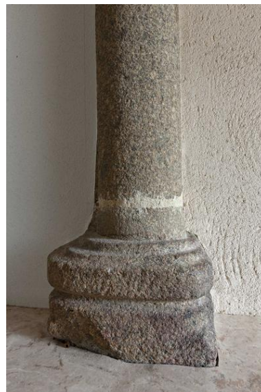
Base du piédroit de la cheminée du premier niveau, ornée d'une moulure torique. Phot. Yves Guillotin IVR52_20205300419NUCA
