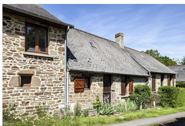
Façade est de la maison centrale. Phot. Yves Guillotin IVR52_20215300670NUCA
