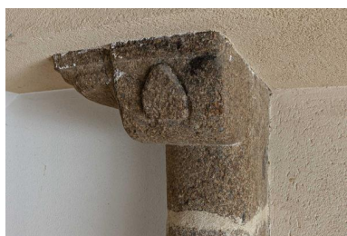
Corbeau orné d'un écu de la cheminée du premier étage. Phot. Yves Guillotin IVR52_20205300420NUCA
