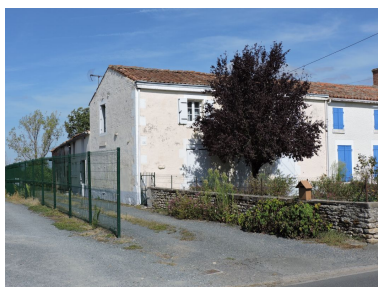
L'ancienne ferme vue depuis le sud-ouest.
