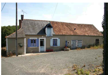
Ferme n° 4 : maison et dépendances sous un même toit. Phot. Jean-Baptiste Darrasse IVR52_20067207008NUCA
