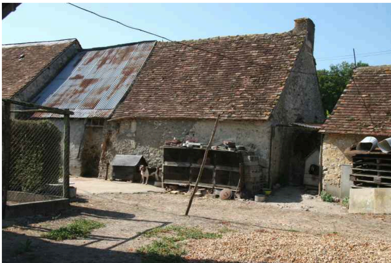
Maison n° 3 : façade postérieure.
