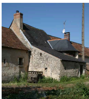
Maison n° 3, façade postérieure : aucune ouverture . Phot. Jean-Baptiste Darrasse IVR52_20067207003NUCA
