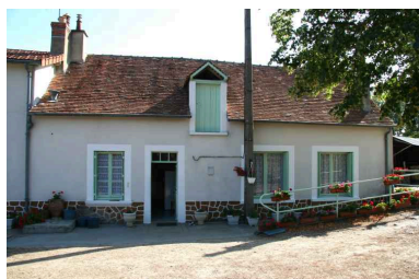
Maison n° 1 : façade antérieure sur la cour. Phot. Jean-Baptiste Darrasse IVR52_20067206999NUCA
