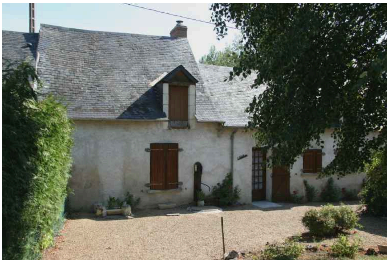
Maison n° 3 : vue partielle de la façade antérieure.
