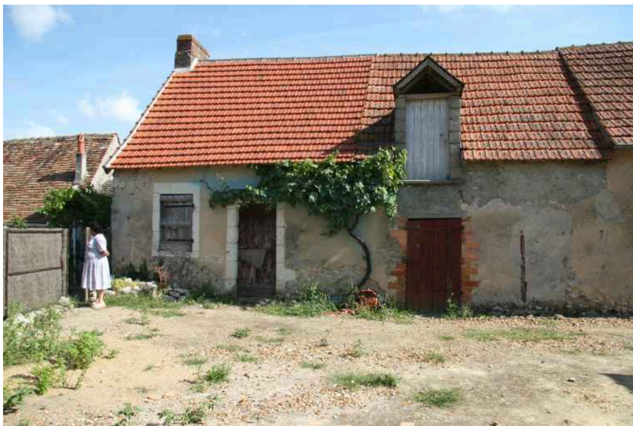
Maison n° 2 : façade antérieure sur cour.
