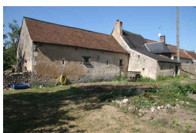
maison n° 3 : façade postérieure. Phot. Jean-Baptiste Darrasse IVR52_20067207002NUCA
