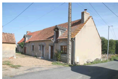
Maison n° 2 : vue de volume. Phot. Jean-Baptiste Darrasse IVR52_20067207000NUCA
