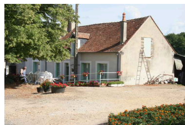
Maison n° 1 : vue de volume. Phot. Jean-Baptiste Darrasse IVR52_20067207006NUCA
