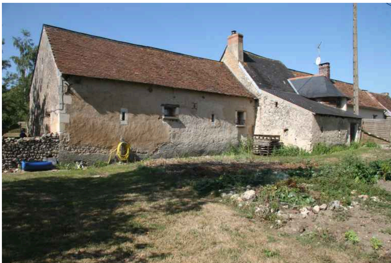
maison n° 3 : façade postérieure.
