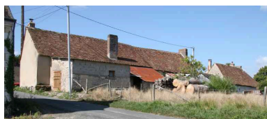
Maison n° 2 : façade postérieure. Phot. Jean-Baptiste Darrasse IVR52_20067207011NUCA
