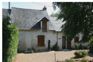
Maison n° 3 : vue partielle de la façade antérieure. Phot. Jean-Baptiste Darrasse IVR52_20067207004NUCA
