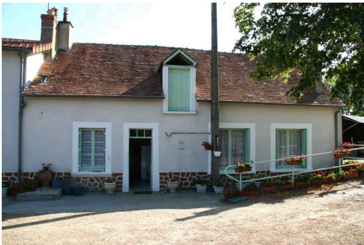
Maison n° 1 : façade antérieure sur la cour.
