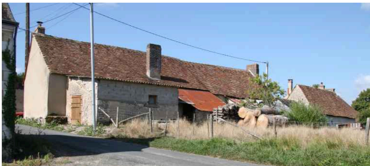
Maison n° 2 : façade postérieure.
