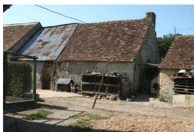
Maison n° 3 : façade postérieure. Phot. Jean-Baptiste Darrasse IVR52_20067207007NUCA
