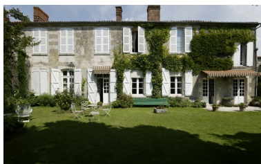
Façade sur jardin. Phot. Patrice Giraud IVR52_20078500400NUCA
