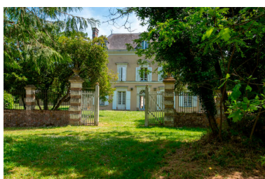
La demeure depuis le chemin. Phot. Pierre-Bernard Fourny IVR52_20235300598NUCA
