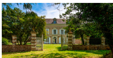
La demeure depuis le chemin. Phot. Pierre-Bernard Fourny IVR52_20235300600NUCA
