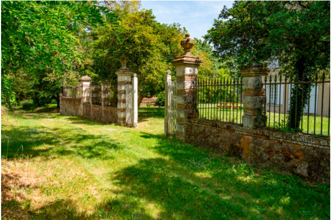
Le mur de clôture et le portail.
