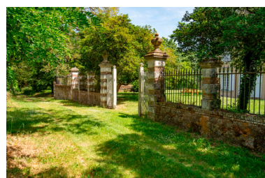
Le mur de clôture et le portail. Phot. Pierre-Bernard Fourny IVR52_20235300597NUCA
