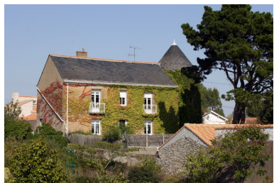
Vue d'ensemble depuis la rue des Remparts. Phot. François Lasa IVR52_20054401529NUCA
