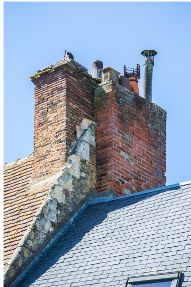
Un des pignons découverts. Phot. Pierre-Bernard Fourny IVR52_20187201053NUCA
