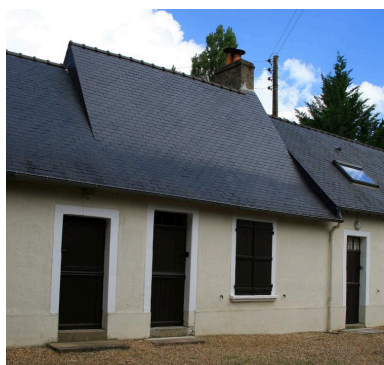
Maison élémentaire, La Picardière (XVIe siècle). Phot. Jean-Baptiste Darrasse IVR52_20107201483NUCA
