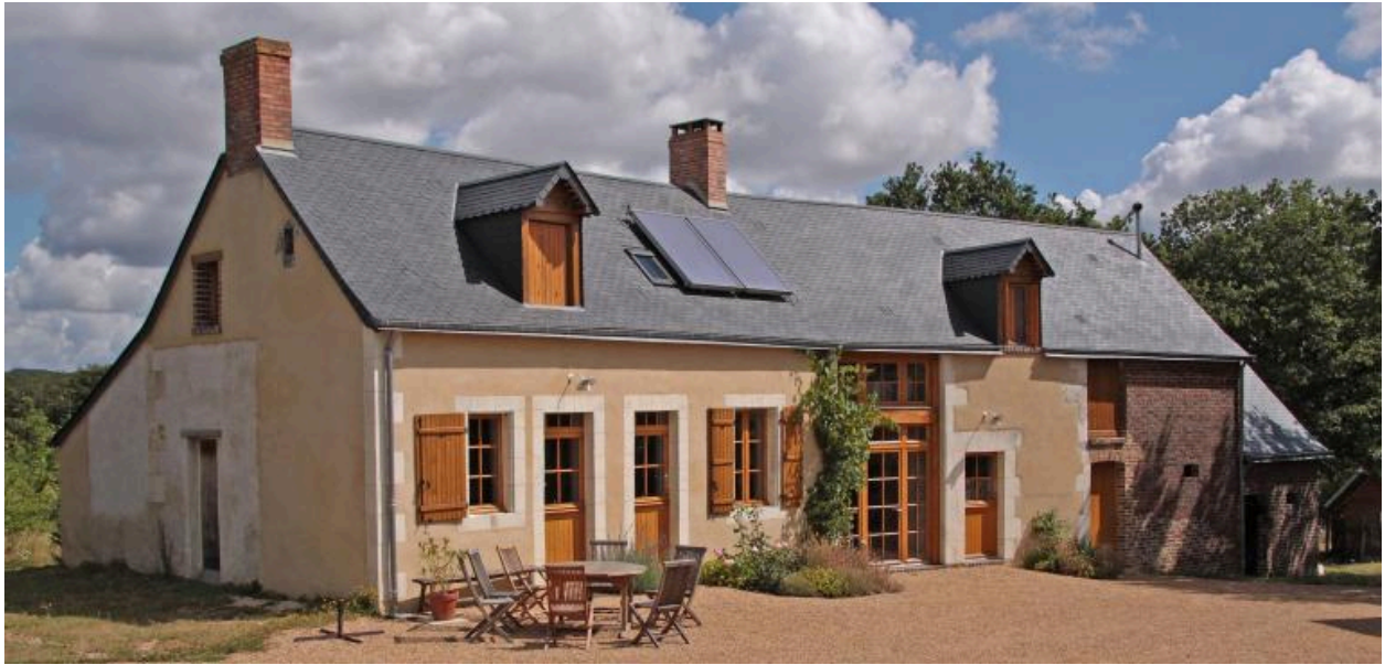
Ferme bloc à terre, La Renardière (XIXe siècle).
