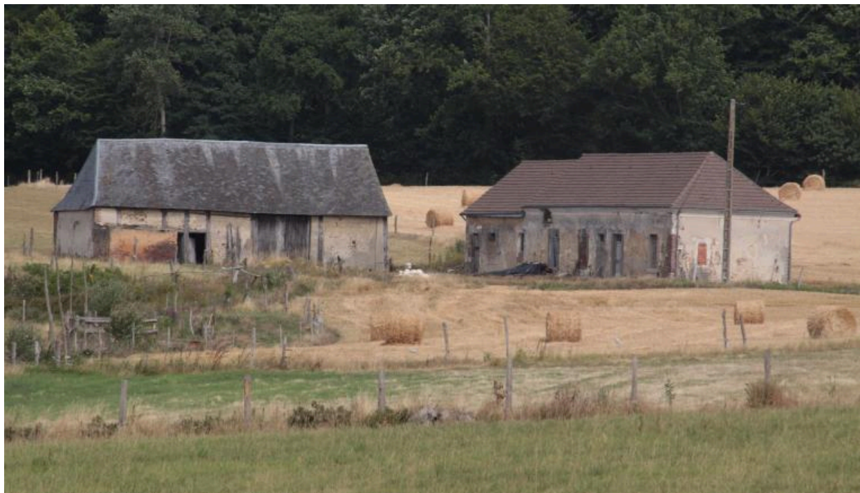
Ferme en L non jointif, maison reconstruite en 1840, grange à pan de bois. La Marchandière.
