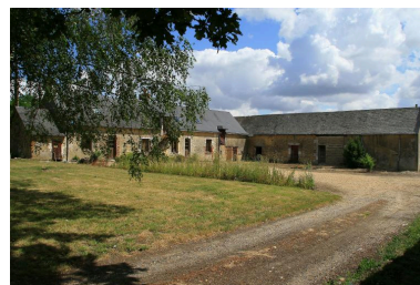
Ferme en L jointif, bâtiments de même hauteur, Madrelle. Phot. Jean-Baptiste Darrasse IVR52_20107201486NUCA
