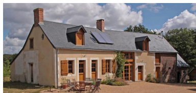
Ferme bloc à terre, La Renardière (XIXe siècle). Phot. Jean-Baptiste Darrasse IVR52_20107201530NUCA
