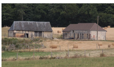
Ferme en L non jointif, maison reconstruite en 1840, grange à pan de bois. La Marchandière. Phot. Jean-Baptiste Darrasse IVR52_20107201402NUCA
