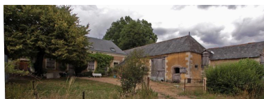
Ferme en L jointif, Le Pont Bec d'Oie (1859). Phot. Jean-Baptiste Darrasse IVR52_20107201567NUCA
