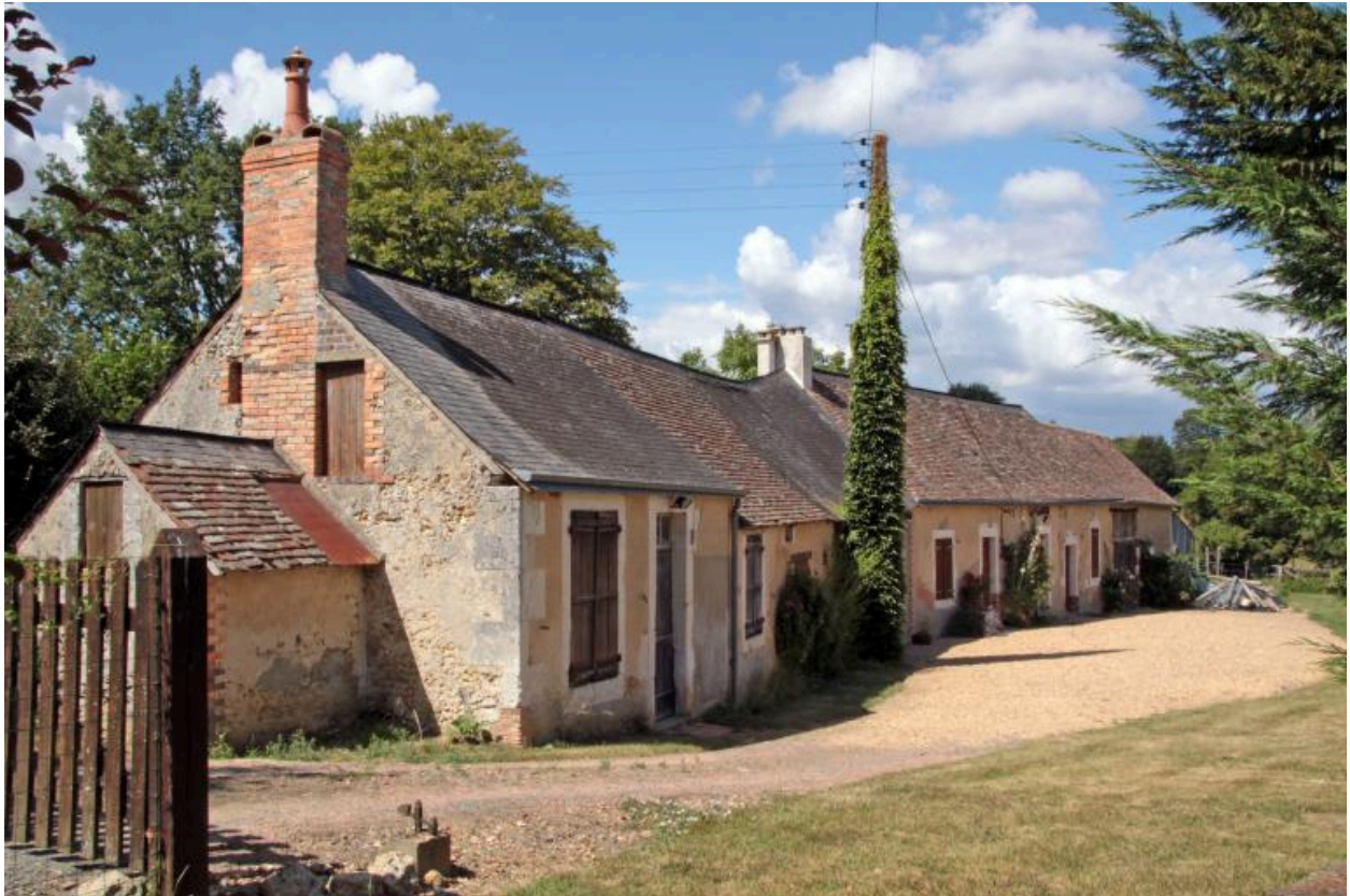
Deux fermes jointives, Les Ruelles.
