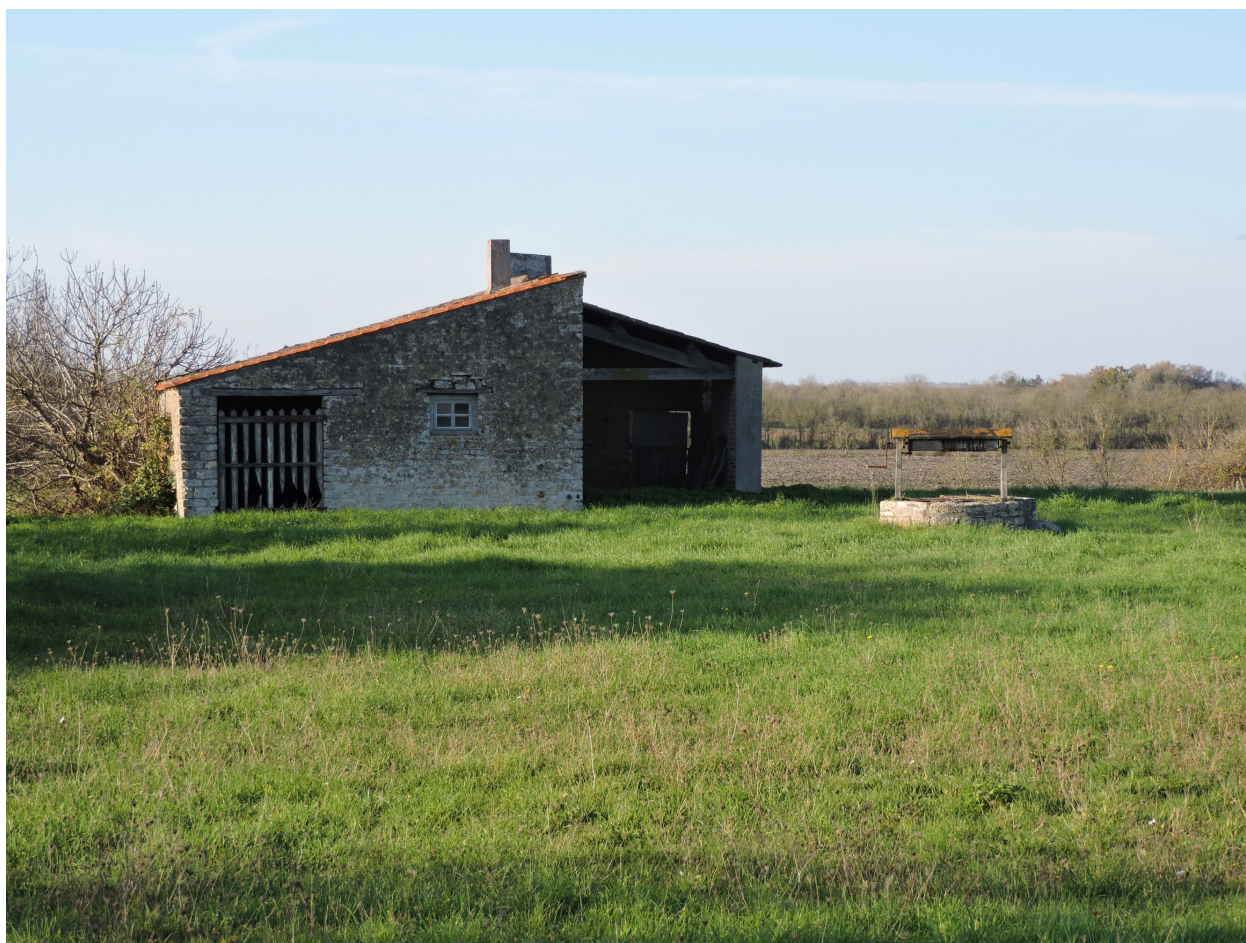
La ferme vue depuis le sud-est.
