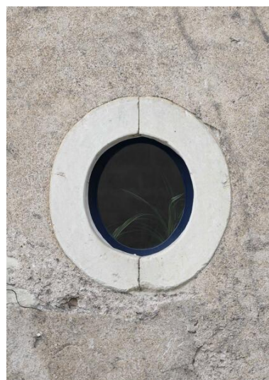
Détail d'un oculus. Phot. Armelle Maugin IVR52_20254900625NUCA
