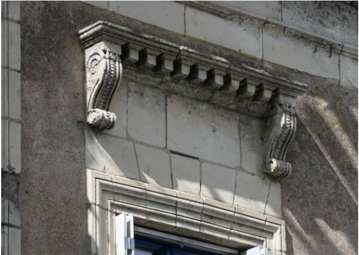
Détail du décor d'une baie : linteau crénelé avec modillons à volutes perlées.
