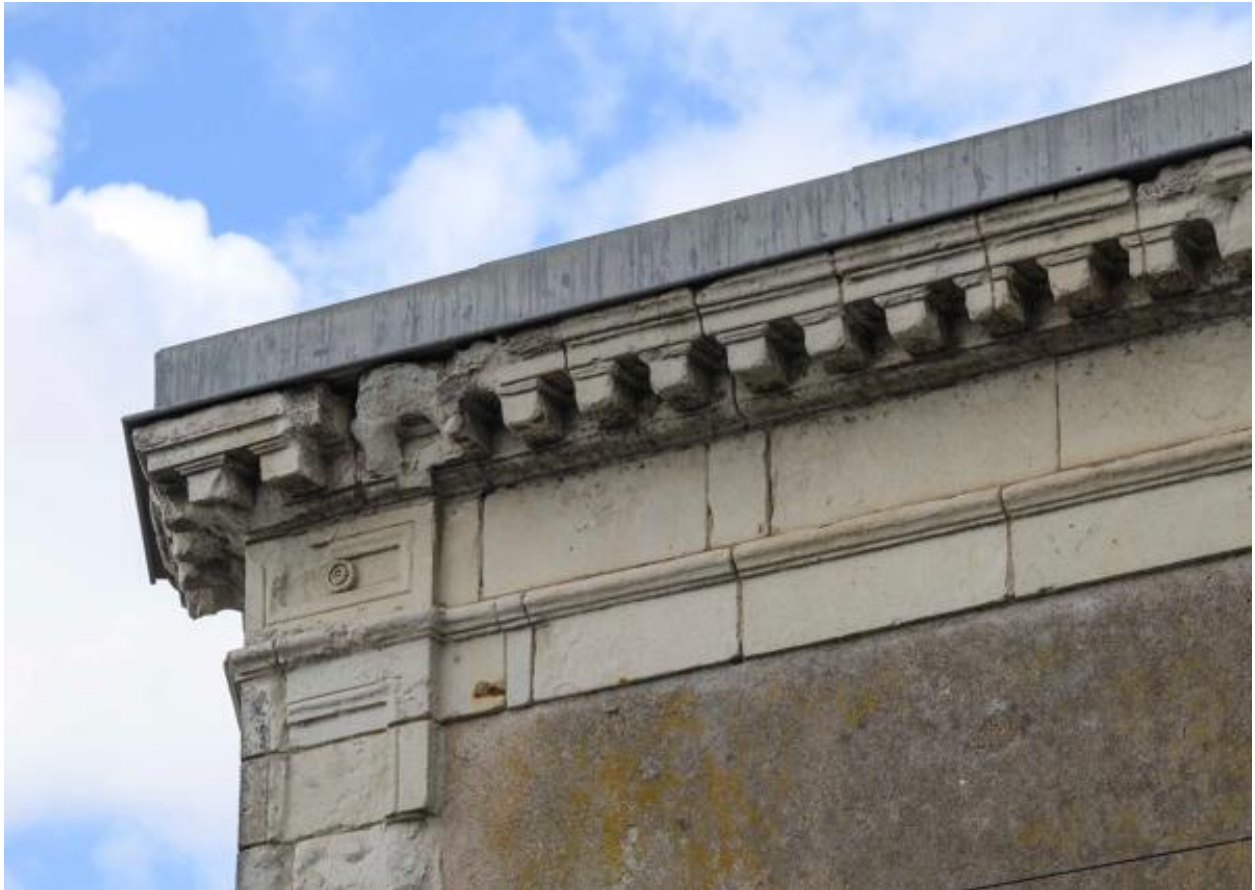
Détail de la corniche crénelée.
