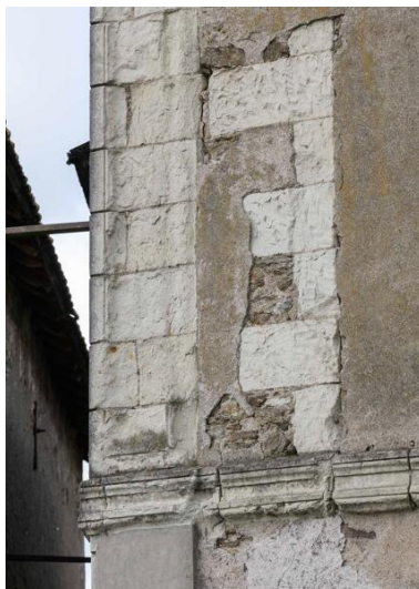
Détail d'un pilastre et d'une ancienne ouverture en pierre de taille de tuffeau. Phot. Armelle Maugin IVR52_20254900627NUCA
