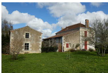
La ferme vue depuis le sud-ouest. Phot. Yannis Suire IVR52_20238500967NUCA
