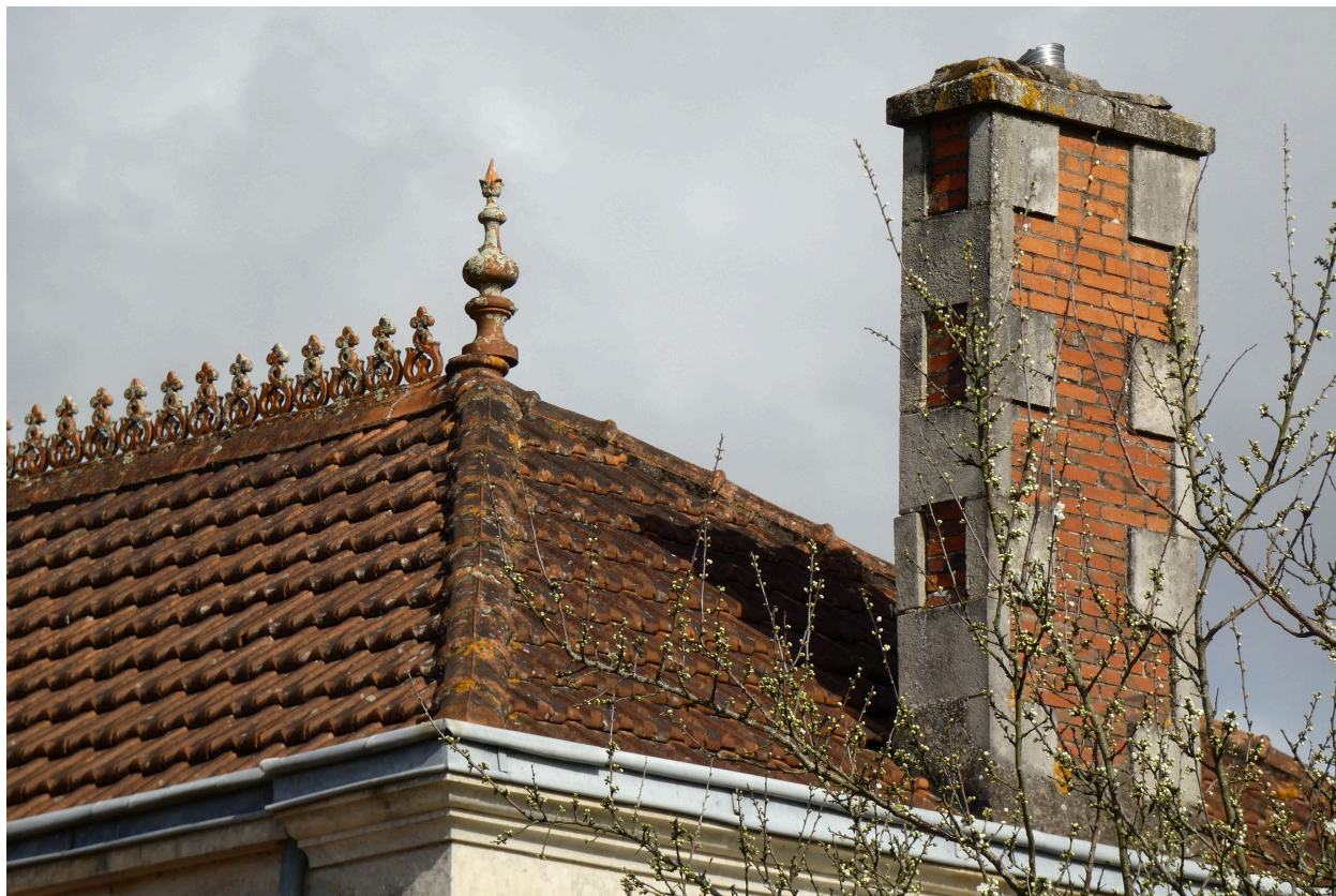
Détail du toit et d'une souche de cheminée.
