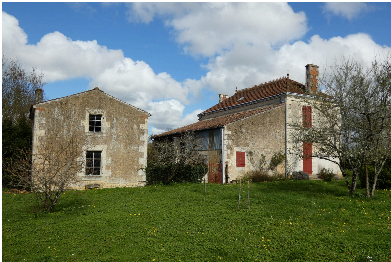
La ferme vue depuis le sud-ouest.
