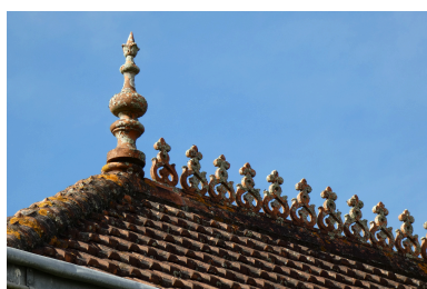
Détail d'un épi et de la crête de faîtage. Phot. Yannis Suire IVR52_20238500979NUCA
