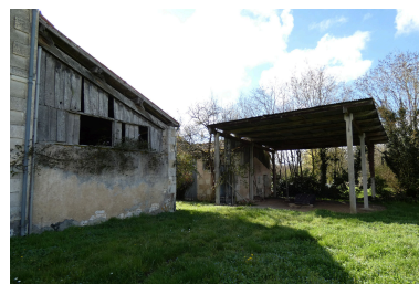
Les dépendances à l'arrière du logis vues depuis l'est. Phot. Yannis Suire IVR52_20238500980NUCA
