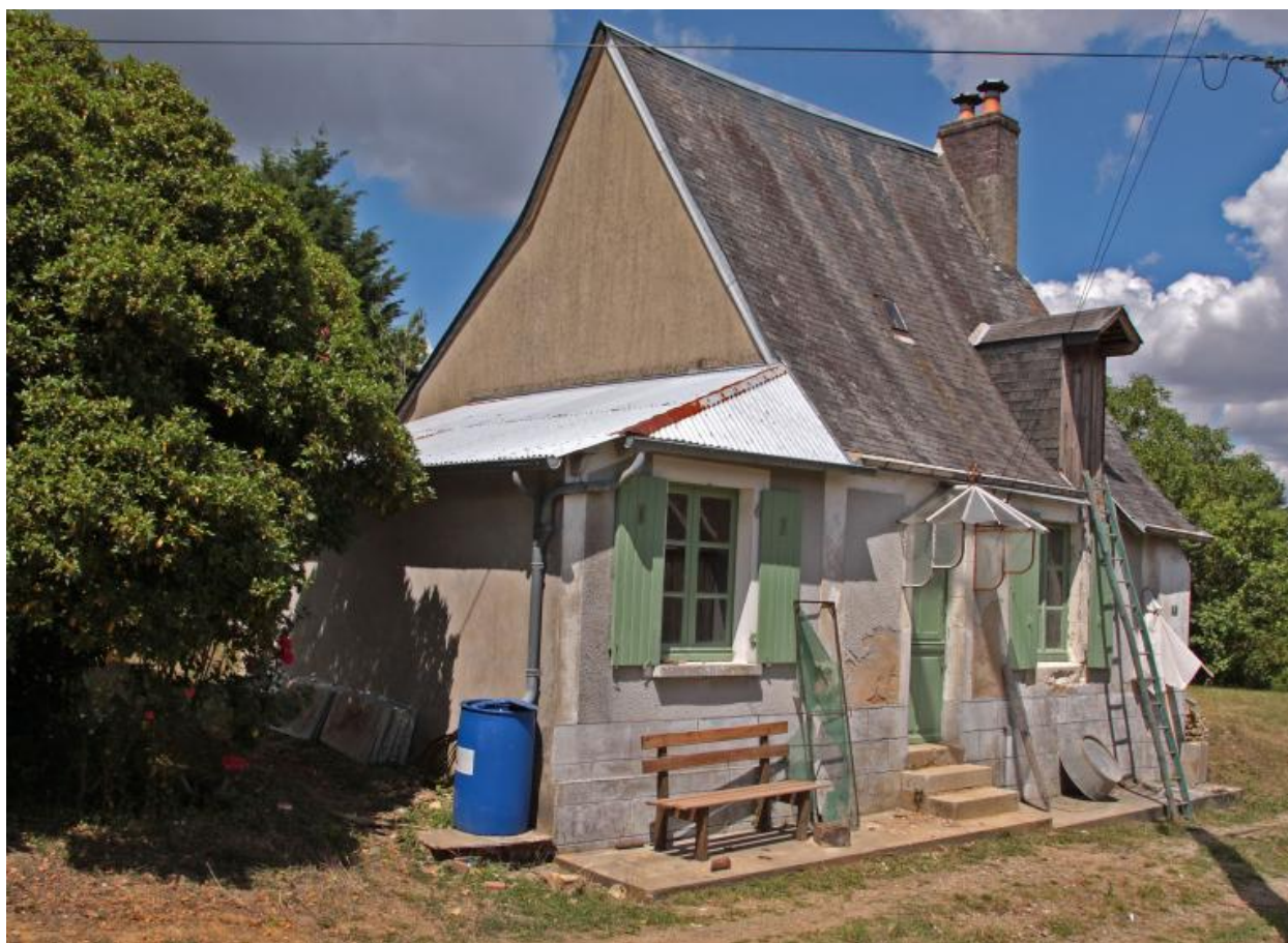
La maison n°9, pignon ouest : noter le rez-de-chaussée surélevé.
