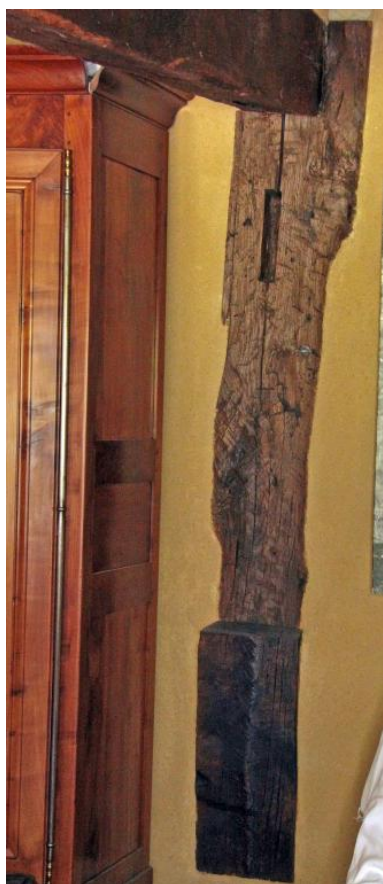
La ferme n°13 : vestige d'un poteau de bois dans le mur nord de la maison ancienne. Phot. Jean-Baptiste Darrasse IVR52_20107201551NUCA
