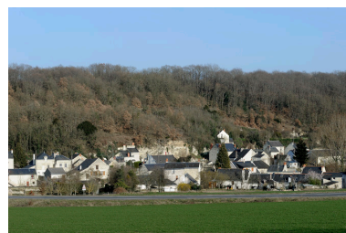
Vue des Roches et de son extension du Creux-Chemin (au premier plan), depuis les Closards. Phot. Bruno Rousseau, Phot. Youenn Communeau IVR52_20114900686NUCA
