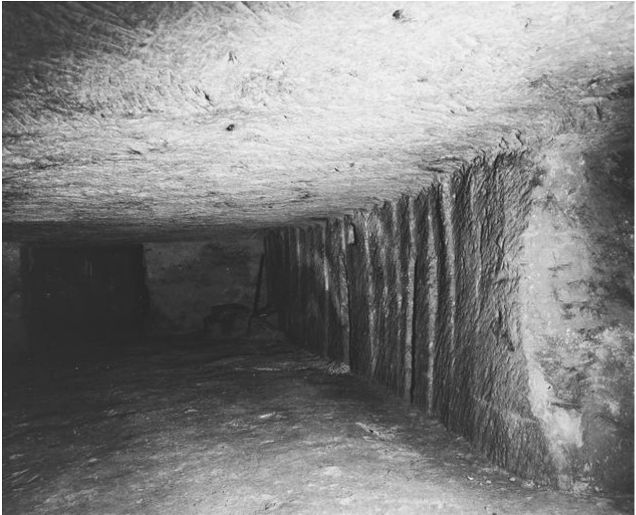
Carrière des Roches, traces verticales d'extraction, témoignant de la progression de l'exploitation de la carrière de tuffeau
