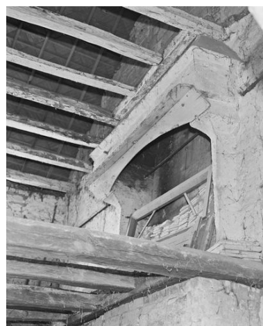
62, avenue des Roches. Cheminée du XVe siècle à l'étage-carré de la maison.
