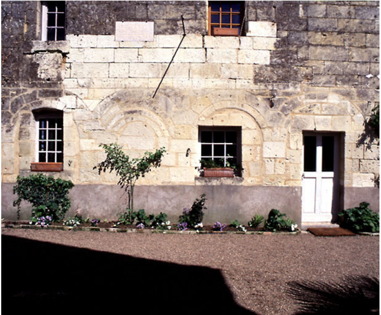
68, avenue des Roches. Maison remaniée autour de 1800, mais conservant en élévation des arcades (murées) vraisemblablement du XVI e siècle.
