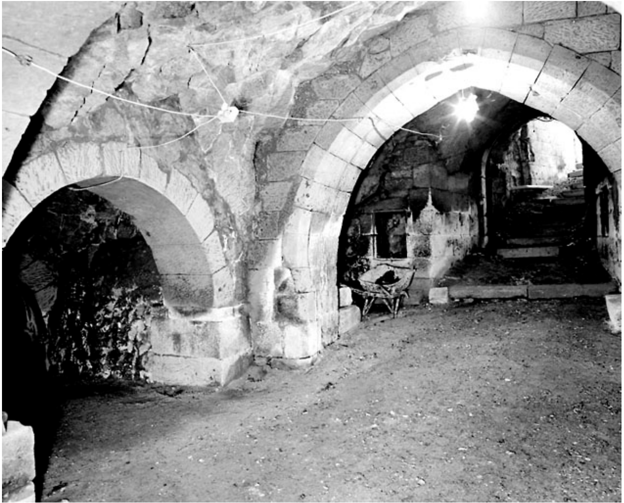
68, avenue des Roches. Sous-sol de la maison, avec confortement de la galerie creusée dans la roche par un arc doubleau brisé et chanfreiné, de facture médiévale.
