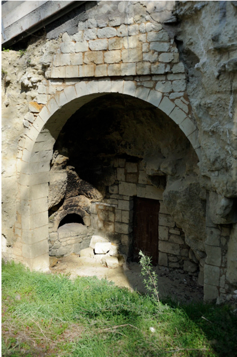
Un abri troglodytique abandonné aux Roches : cave demeurante et four à pain (92, avenue de Rochechouart, cadastre 1813 : F1 240 à 240-ter).
