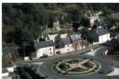
Vue aérienne du rond-point des Roches. Logis alignés sur rue et, en arrière-plan, étagement des dépendances et abris troglodytiques.
