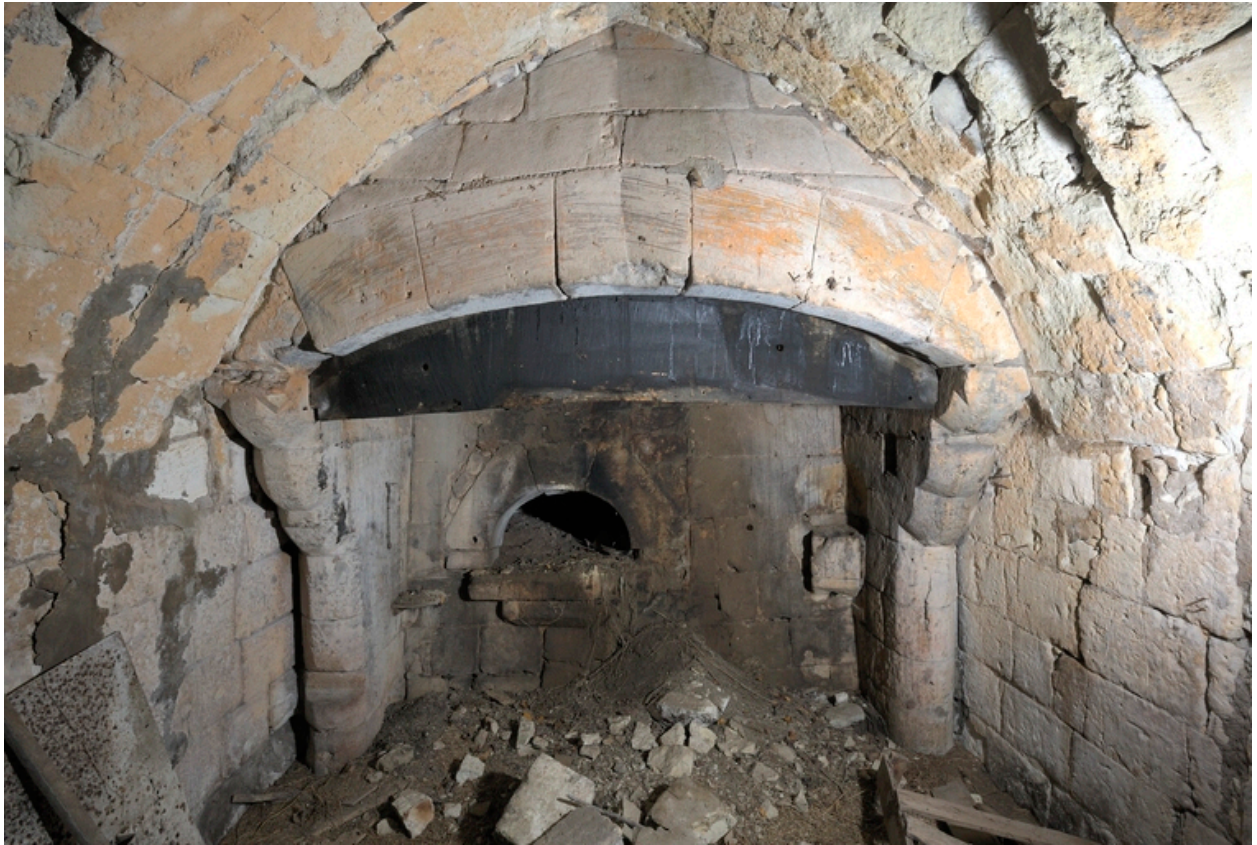
122, avenue des Roches. Abri troglodytique, avec cheminée du XIII e ou XIV e siècle (bouche du four à pain plus tardive).
