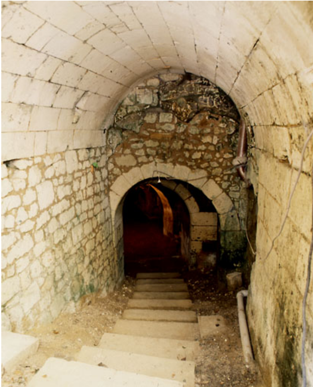
68, avenue des Roches. Sous-sol de la maison, avec réseau de caves anciennes, dont la descente fut couverte d'une voûte lors de la construction d'une extension de l'habitation.
