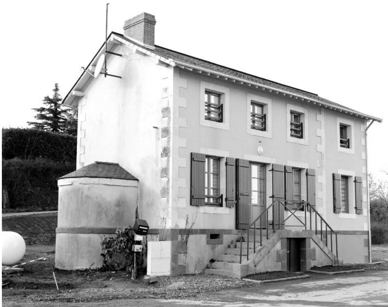
La maison éclusière en 2002.
