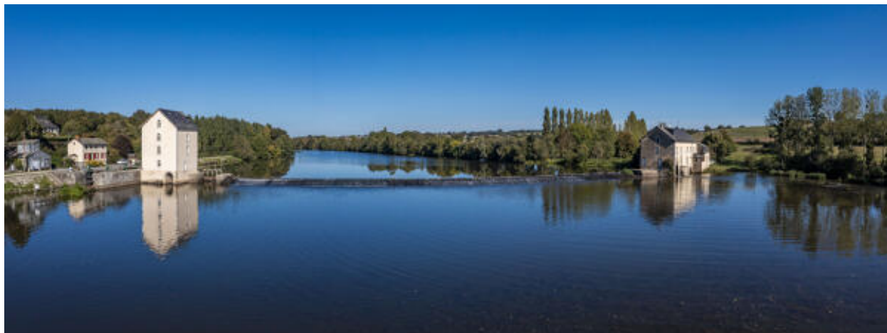
Le barrage et l'écluse de Neuville.
