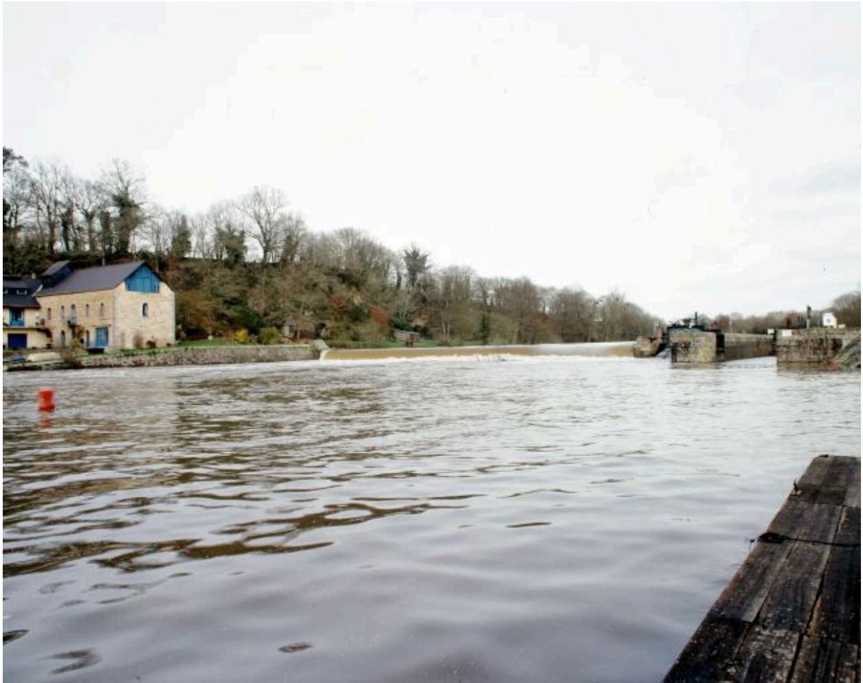
Vue d'ensemble du site d'écluse depuis le ponton situé en aval sur la rive gauche : moulin, barrage, centrale hydroélectrique, écluse.
