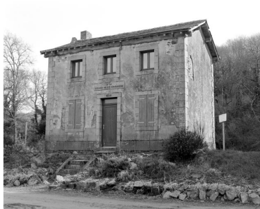
La maison éclusière. Phot. François Lasa IVR52_20015300561X
