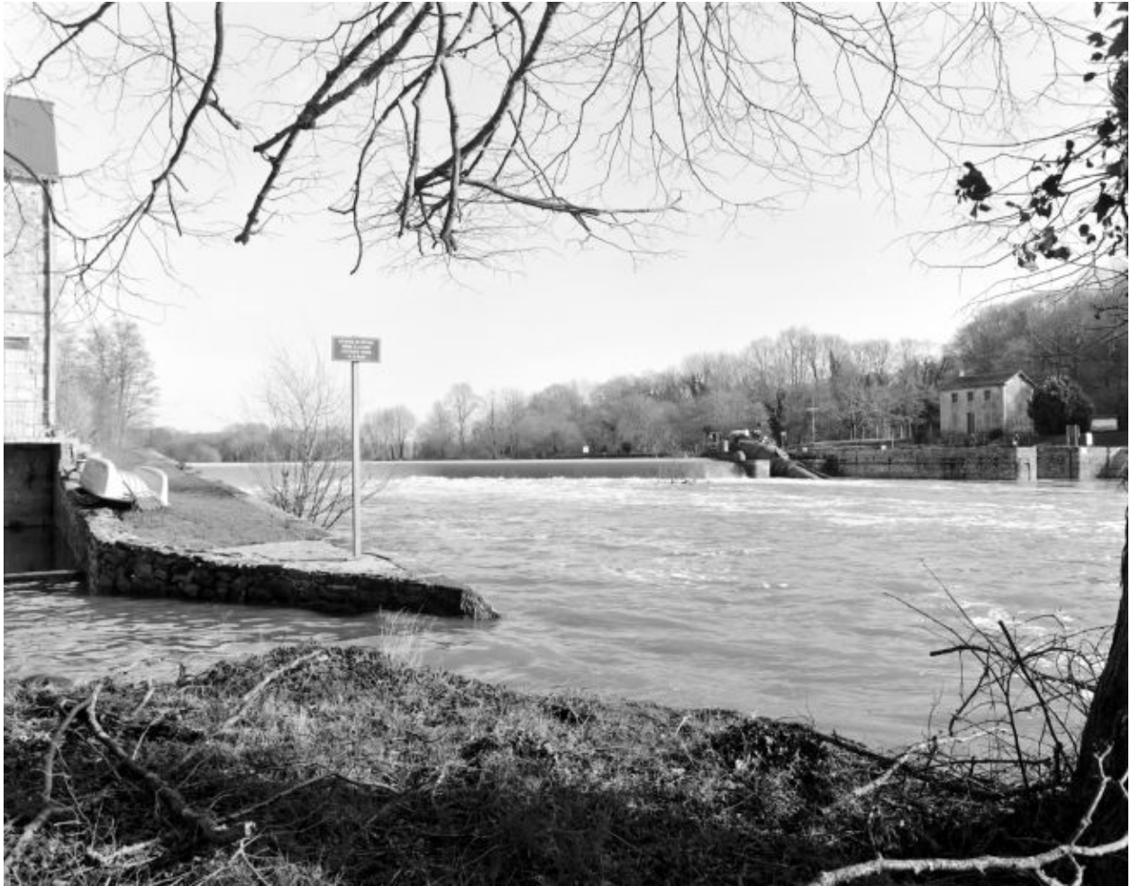
Vue d'ensemble du site depuis la rive droite en aval : canal de fuite du moulin, barrage, micro-centrale hydroélectrique, écluse, maison éclusière.
