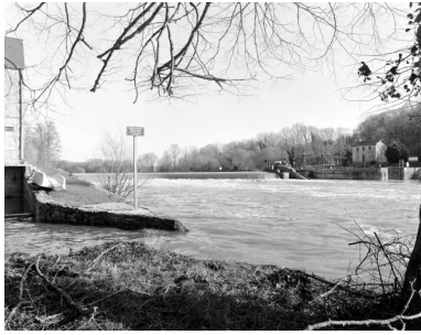
Vue d'ensemble du site depuis la rive droite en aval : canal de fuite du moulin, barrage, micro-centrale hydroélectrique, écluse, maison éclusière.
