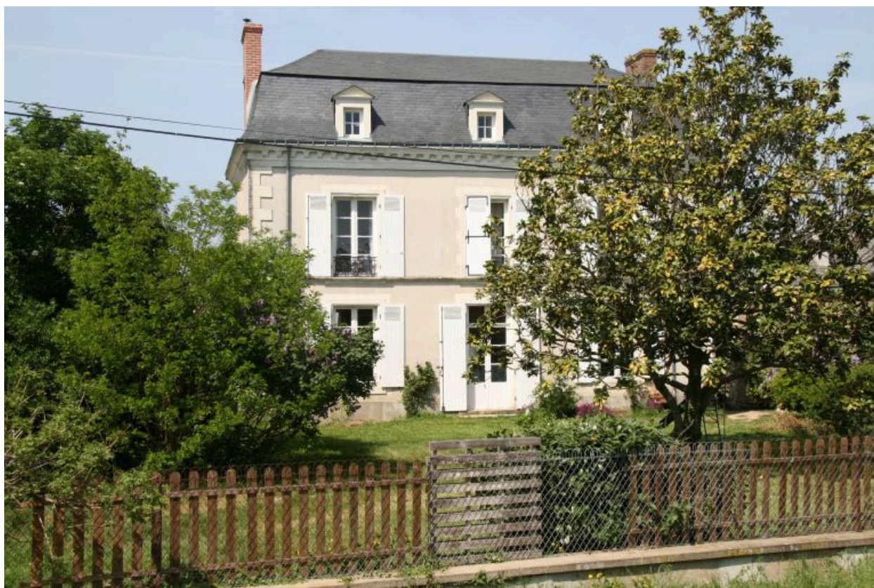
Façade antérieure sur le chemin.
