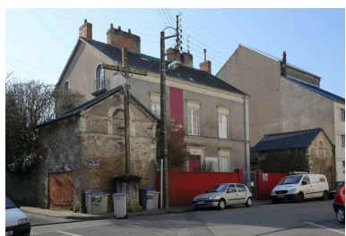
Presbytère. Phot. Denis Pillet IVR52_20134401261NUCA
