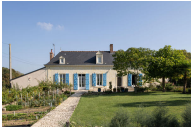
Vue d'ensemble. Phot. Jeanne Minier IVR52_20257200702NUCA
