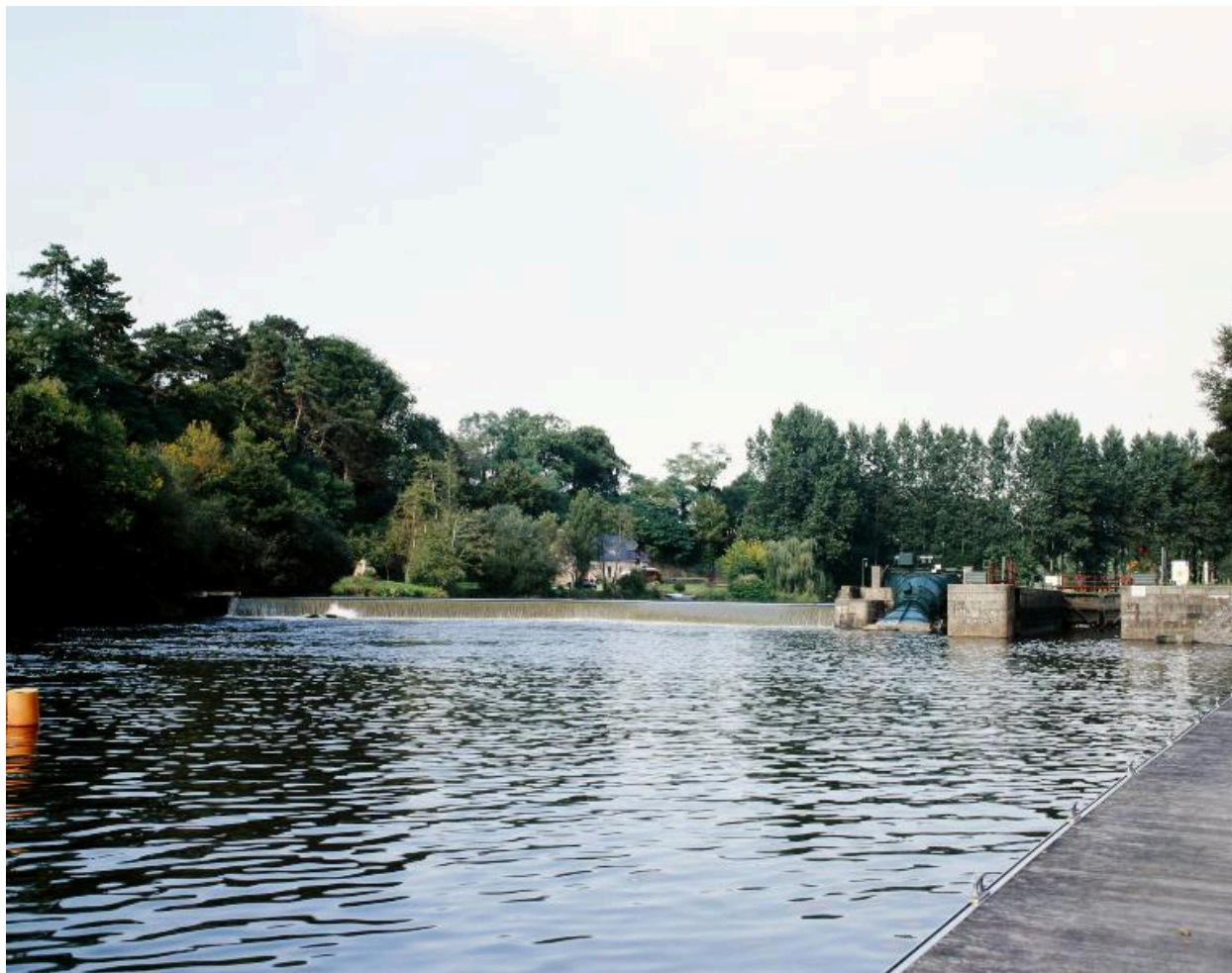
Vue d'ensemble du site d'écluse depuis le ponton situé en aval : barrage, centrale hydroélectrique, écluse.
