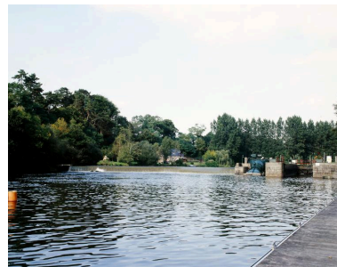
Vue d'ensemble du site d'écluse depuis le ponton situé en aval : barrage, centrale hydroélectrique, écluse. Phot. François Lasa IVR52_20015300476XA
