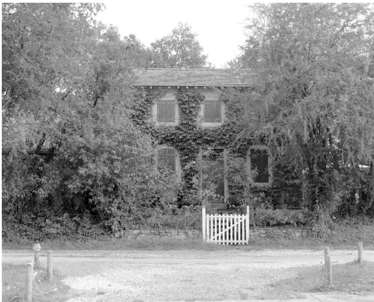
La maison éclusière
