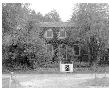
La maison éclusière Phot. François Lasa IVR52_20015300474X
