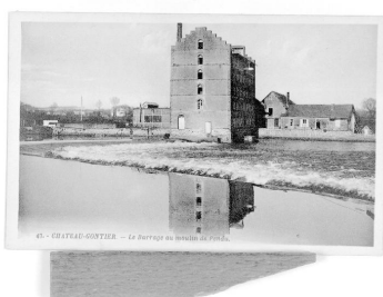
La façade ouest du moulin. A droite, la maison du meunier. Repro. François Lasa IVR52_20015300342X
