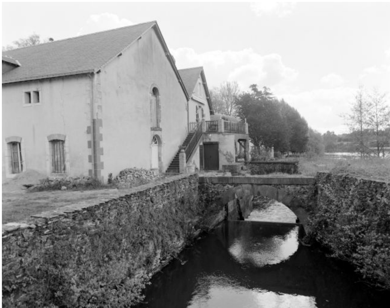
Vestiges du moulin : le coursier de rive vu d'amont. A gauche, la remise, surmontée d'un entrepôt, et un ancien bâtiment agricole (transformé en habitation).
