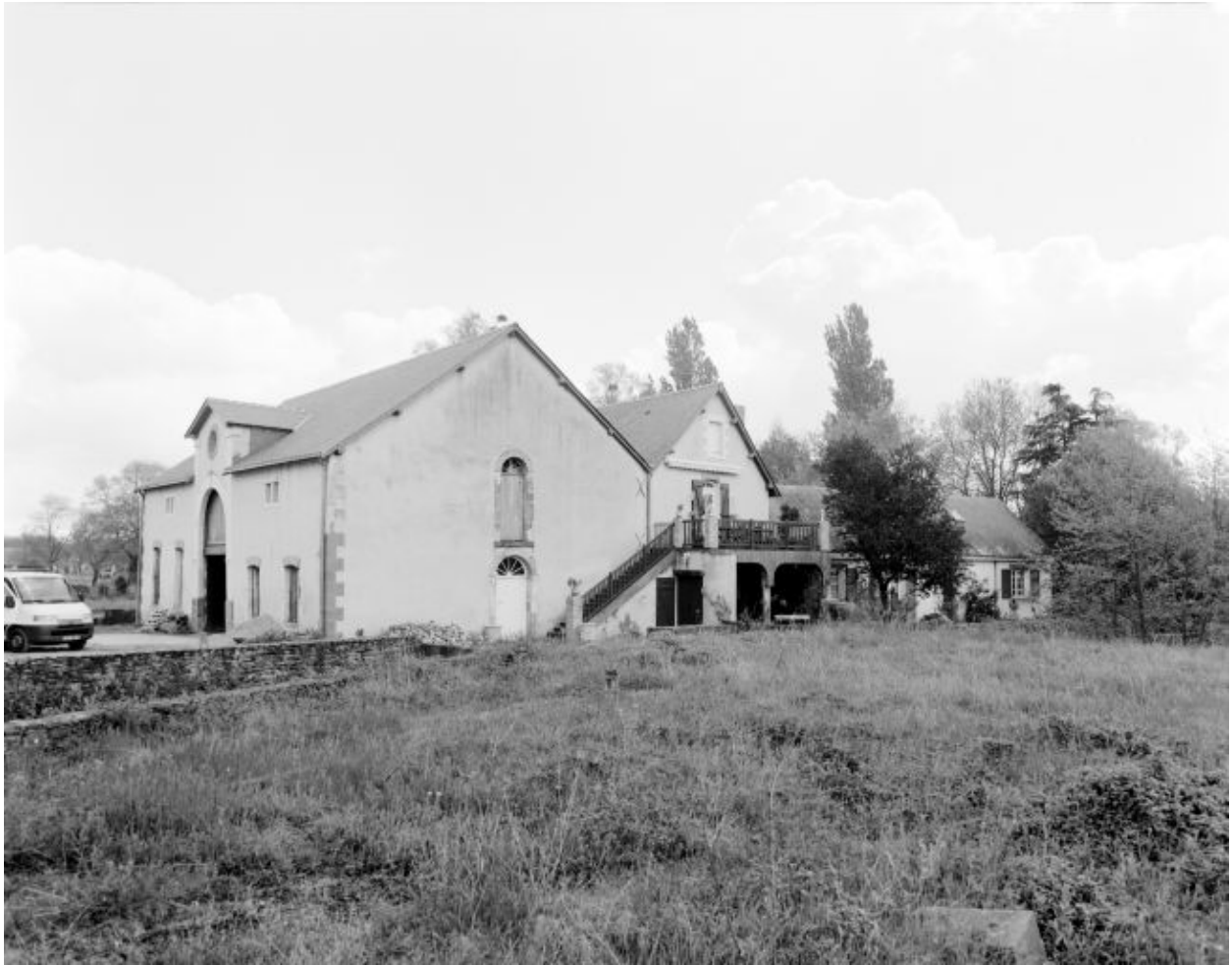
Les anciennes dépendances vues du nord-ouest : remise, surmontée d'un entrepôt, bâtiment agricole (transformé en habitation), maison du meunier (défigurée).
