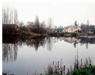
Vue d'ensemble du site du moulin depuis la rive droite : à gauche, derrière les peupliers, les anciens bureaux ; à droite, l'emplacement du moulin détruit et, derrière, les anciennes dépendances : remise, bâtiment agricole (transformé en habitation), logement du meunier (dénaturé). Phot. François Lasa IVR52_20015300749XA
