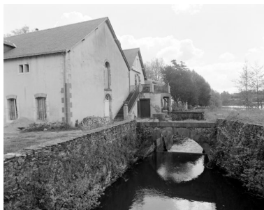
Vestiges du moulin : le coursier de rive vu d'amont. A gauche, la remise, surmontée d'un entrepôt, et un ancien bâtiment agricole (transformé en habitation).
