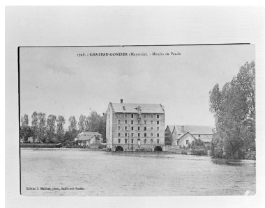
Vue d'aval : la façade sud du moulin. A gauche, les bureaux. A droite, la remise, une dépendance agricole et, en retour, le logis du meunier. Autr. J. Malicot, Repro. François Lasa IVR52_20025300805X
