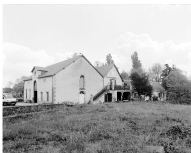
Les anciennes dépendances vues du nord-ouest : remise, surmontée d'un entrepôt, bâtiment agricole (transformé en habitation), maison du meunier (défigurée).
