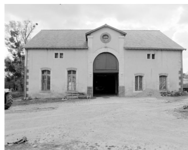
Le bâtiment qui abritait la remise et, à l'étage, un entrepôt. Vue du nord.
