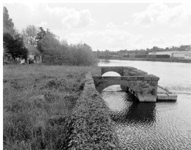
Vestiges du moulin : le coursier du large vu d'amont. A gauche, le logement du meunier (dénaturé).
