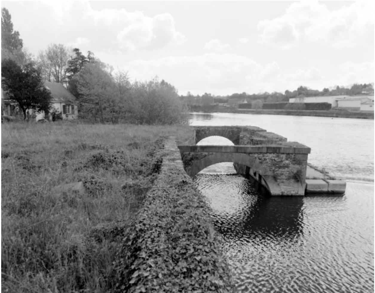
Vestiges du moulin : le coursier du large vu d'amont. A gauche , le logement du meunier (dénaturé).
