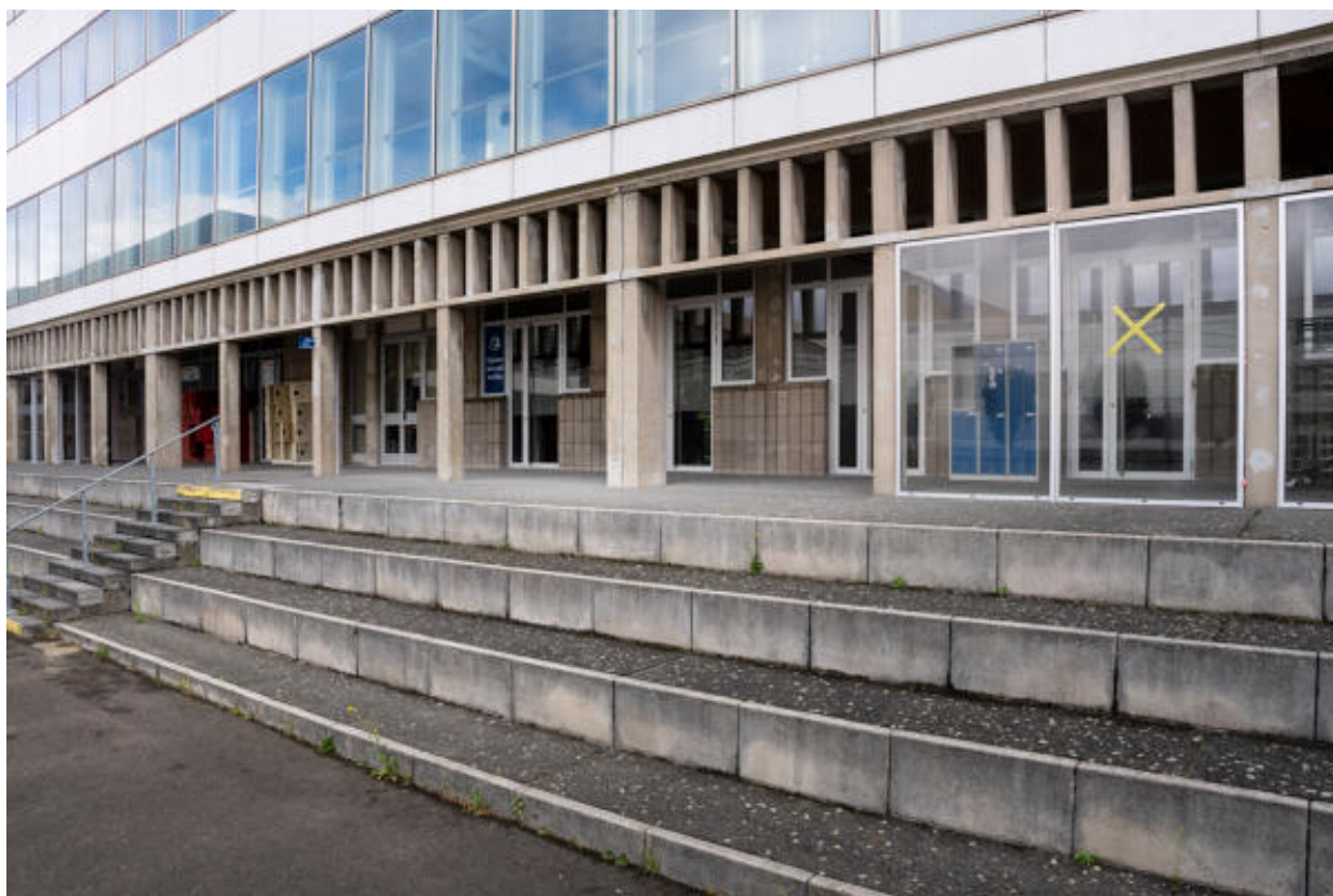
Vue de la galerie en rez-de-chaussée de l'aile est du lycée depuis le sud-ouest.
