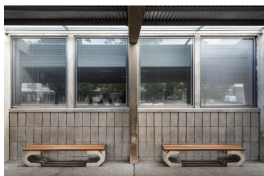
Vue du rez-de-chaussée de l'aile nord-est depuis le sud.
