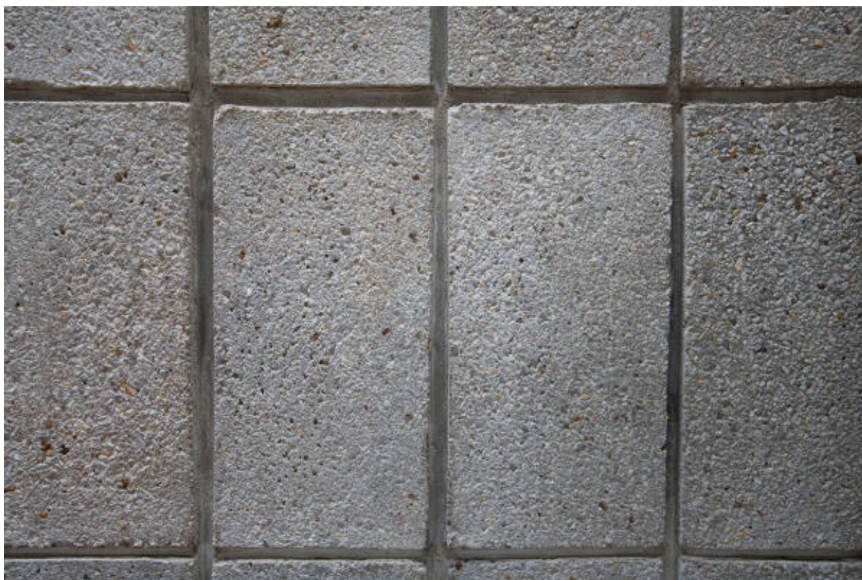
Détail du matériau béton brut avec motif quadrillé au rez-de-chaussée de l'aile nord-est du lycée.
