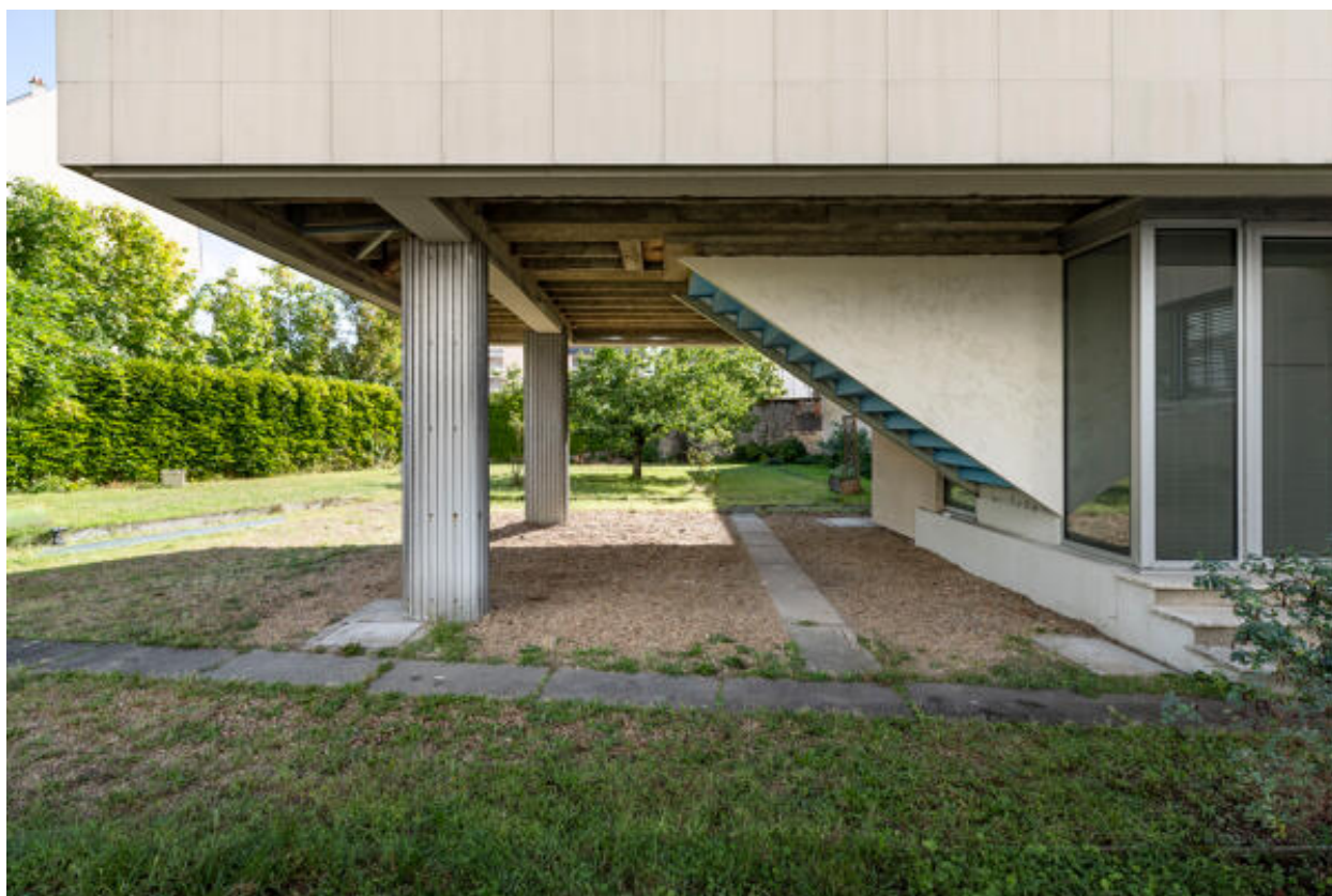
Vue de la structure sur pilotis de la maison du proviseur depuis la partie ouest du jardin.
