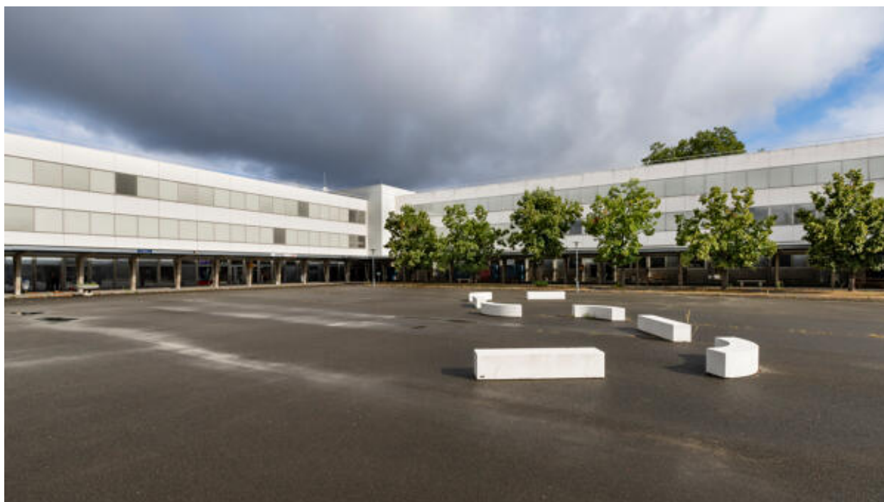
Vue des ailes nord et ouest du lycée depuis la cour est.
