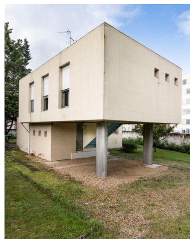
Vue des façades nord et est de la maison du proviseur depuis le jardin.
