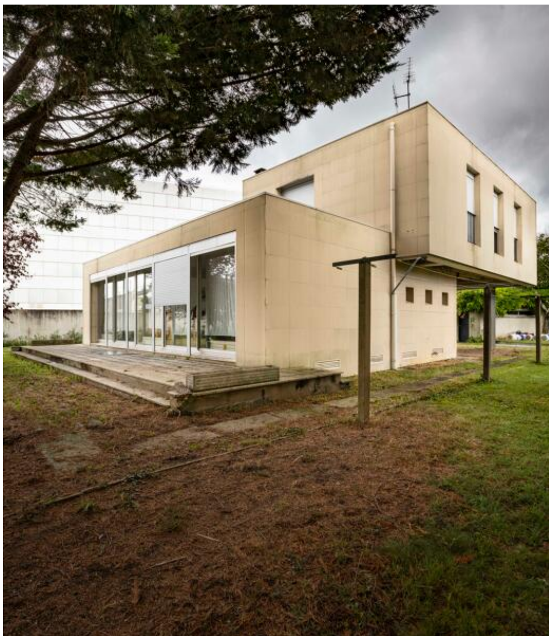
Vue des façades sud et est de la maison du proviseur depuis le jardin.
