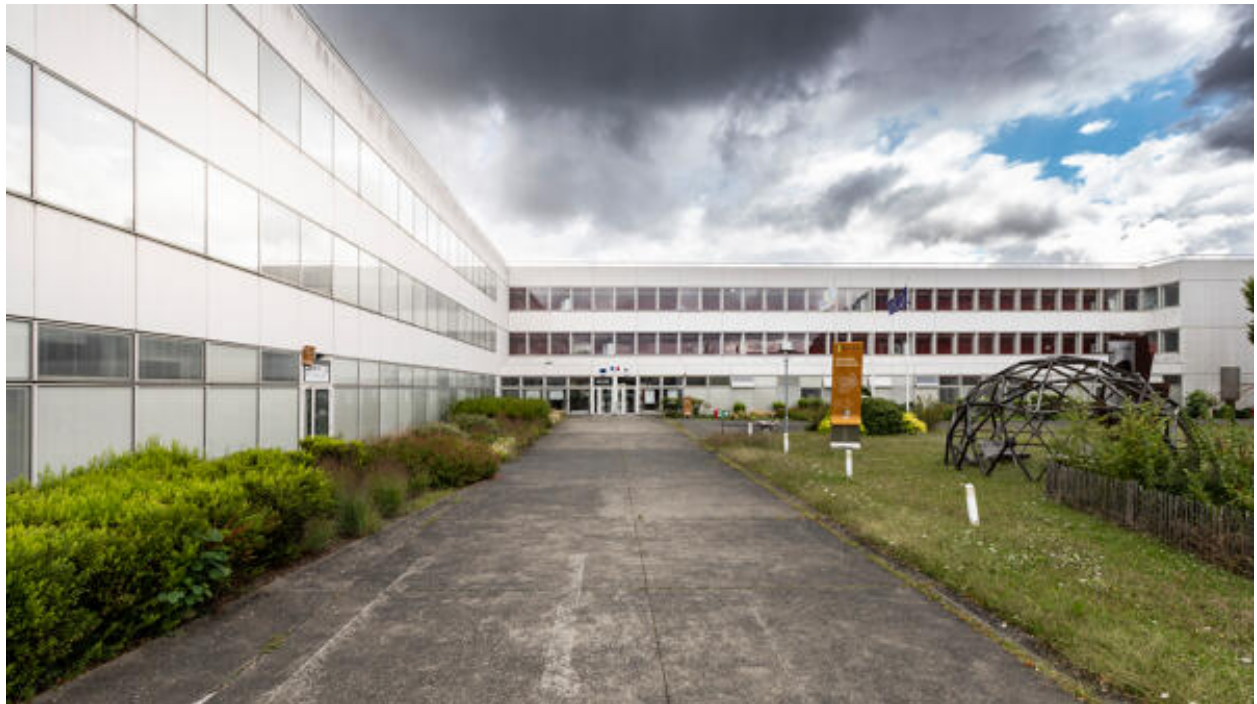
Vue des ailes centrale et nord depuis la cour ouest du lycée.
