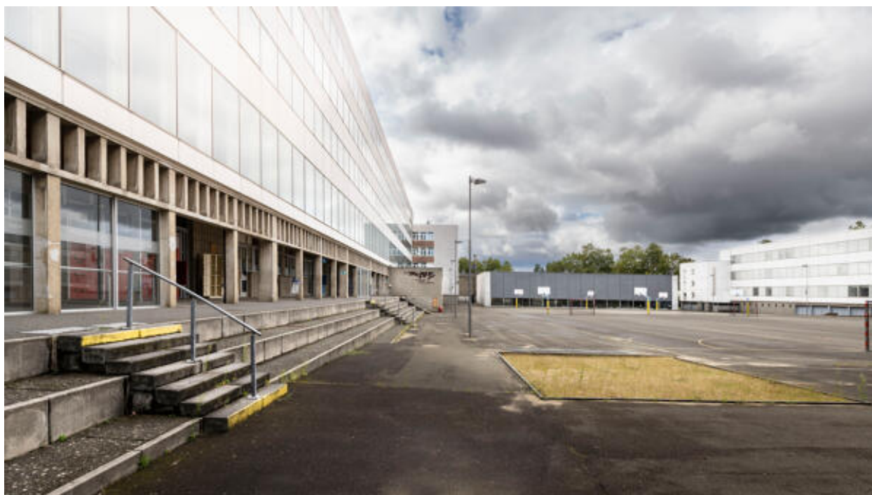
Vue de la cour sud du lycée depuis le nord.
