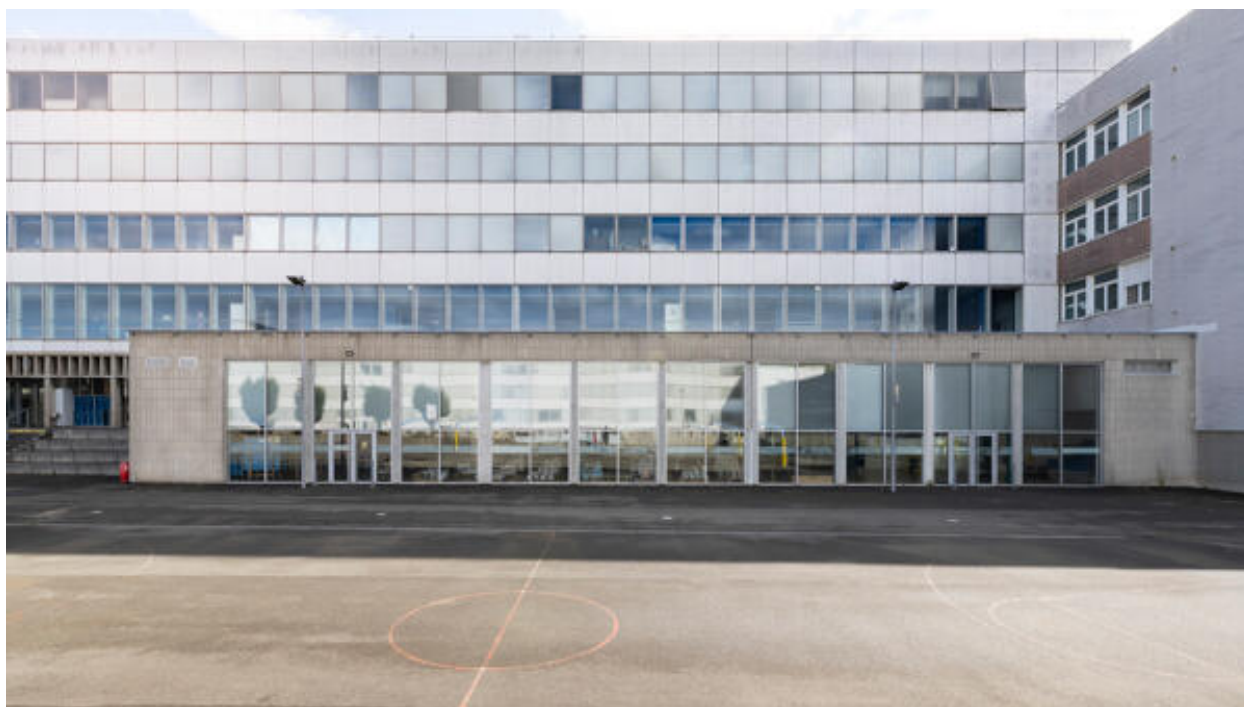
Vue du gymnase accolé à l'aile est du lycée depuis l'ouest.
