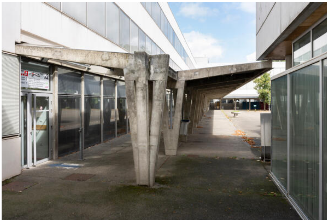
Vue du premier pilier du préau longeant le rez-de-chaussée de l'aile centrale depuis le sud.
