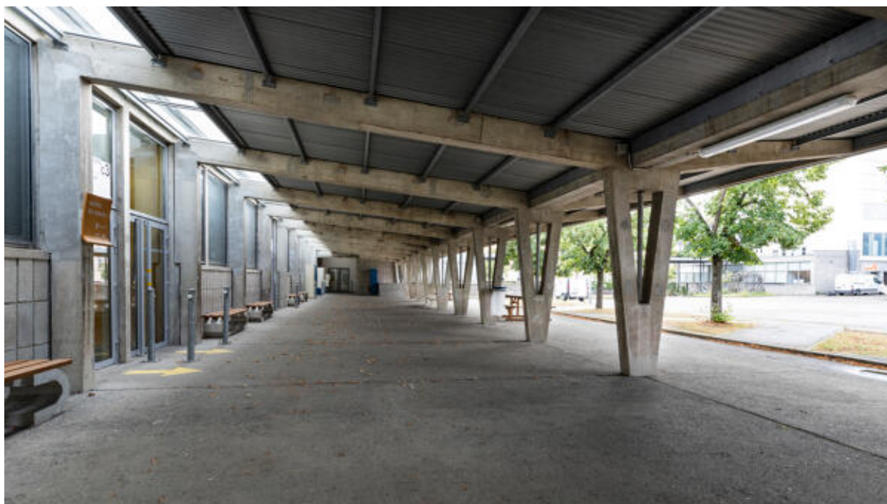
Vue du porte-à-faux en béton soutenu par les poteaux du auvent longeant l'aile nord-est du lycée depuis l'ouest.
