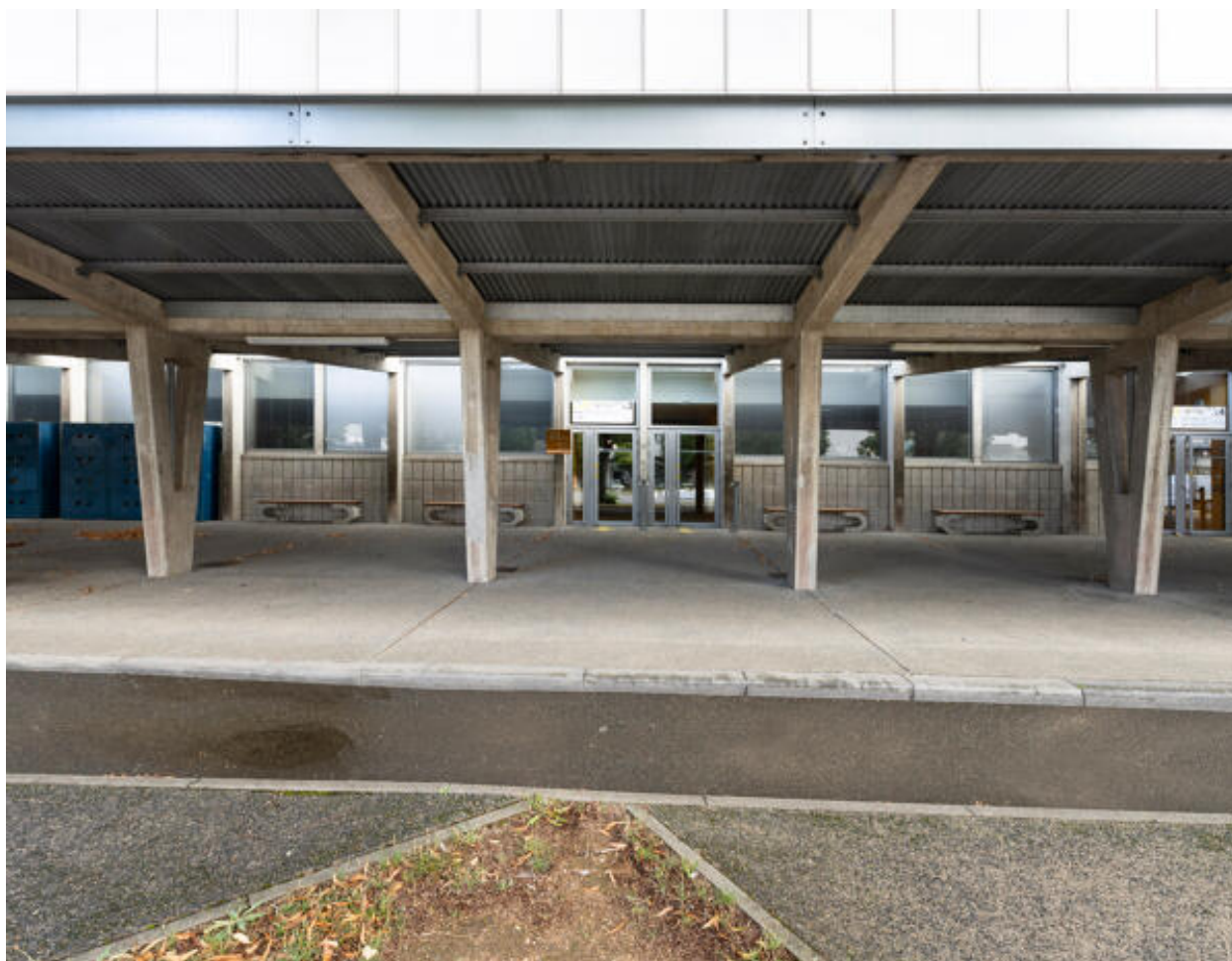
Vue du porte-à-faux en béton soutenu par les poteaux du auvent longeant l'aile nord-est du lycée, depuis le sud.
