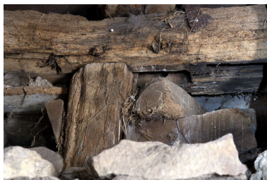
Détail du pan de bois du mur nord de l'ancien logis : l'assemblage de la sablière et du poteau vu depuis l'extérieur. Phot. François Lasa IVR52_20055301590NUCA
