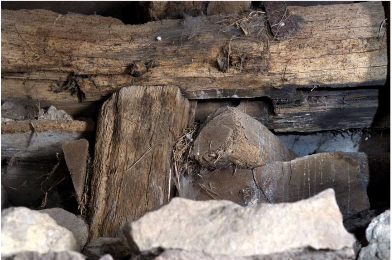
Détail du pan de bois du mur nord de l'ancien logis : l'assemblage de la sablière et du poteau vu depuis l'extérieur.
