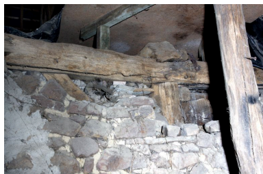
Détail du pan de bois du mur nord de l'ancien logis : la sablière et les extrémités du poteau et du lien oblique vus depuis l'extérieur. Phot. François Lasa IVR52_20055301589NUCA
