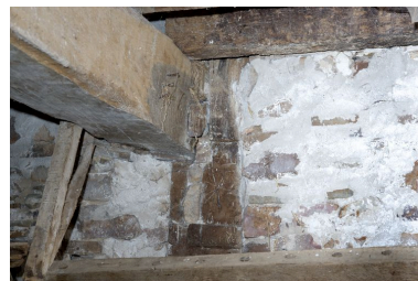
Détail du pan de bois du mur nord de l'ancien logis : la sablière, le poteau et l'entrait vus depuis l'intérieur. Phot. François Lasa IVR52_20055301591NUCA
