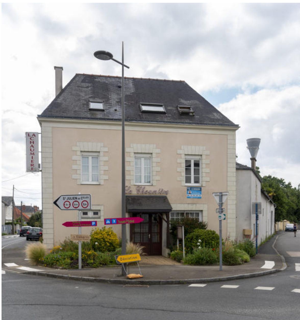
Vue générale de la façade antérieure.
