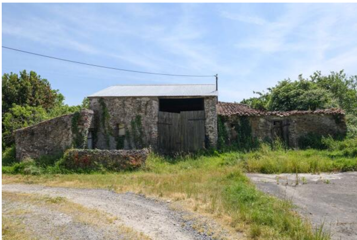
La Jolivetière. Ferme n° 1. Vue de l'ensemble : toit à porcs, grange, étable.
