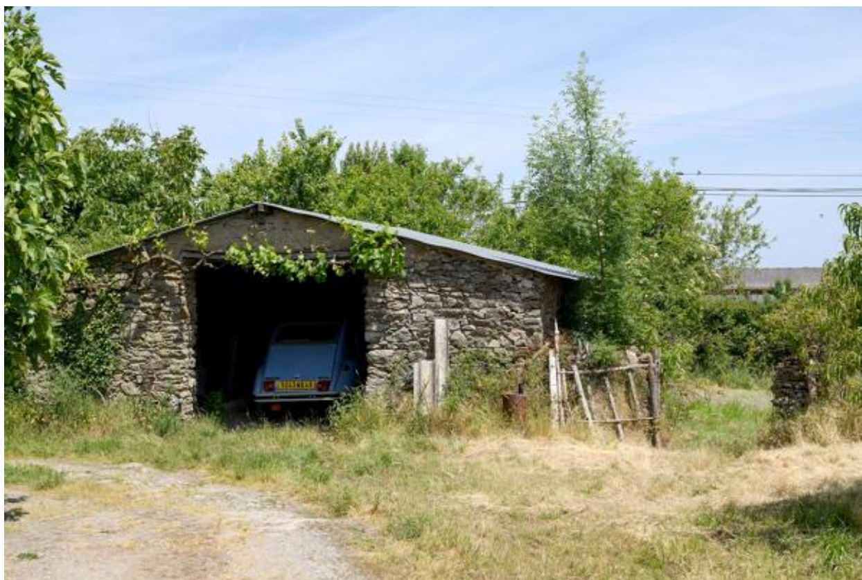
La Jolivetière. Ferme n° 1. Vue de la remise.
