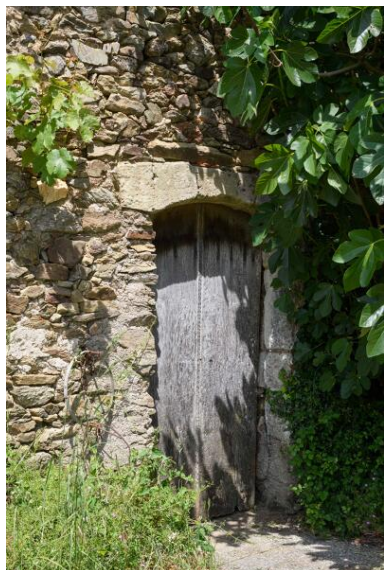
La Jolivetière. Ferme n° 1. Détail de la porte de la chambre sud.
