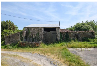
La Jolivetière. Ferme n° 1. Vue de l'ensemble : toit à porcs, grange, étable. Phot. Armelle Maugin IVR52_20254900760NUCA
