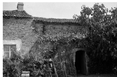
La Jolivetière. Ferme n° 1. Vue de la chambre sud en 1972. Phot. Marie-Anne Eon IVR52_19724900556Z
