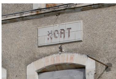
Détail sur la façade côté quai.
