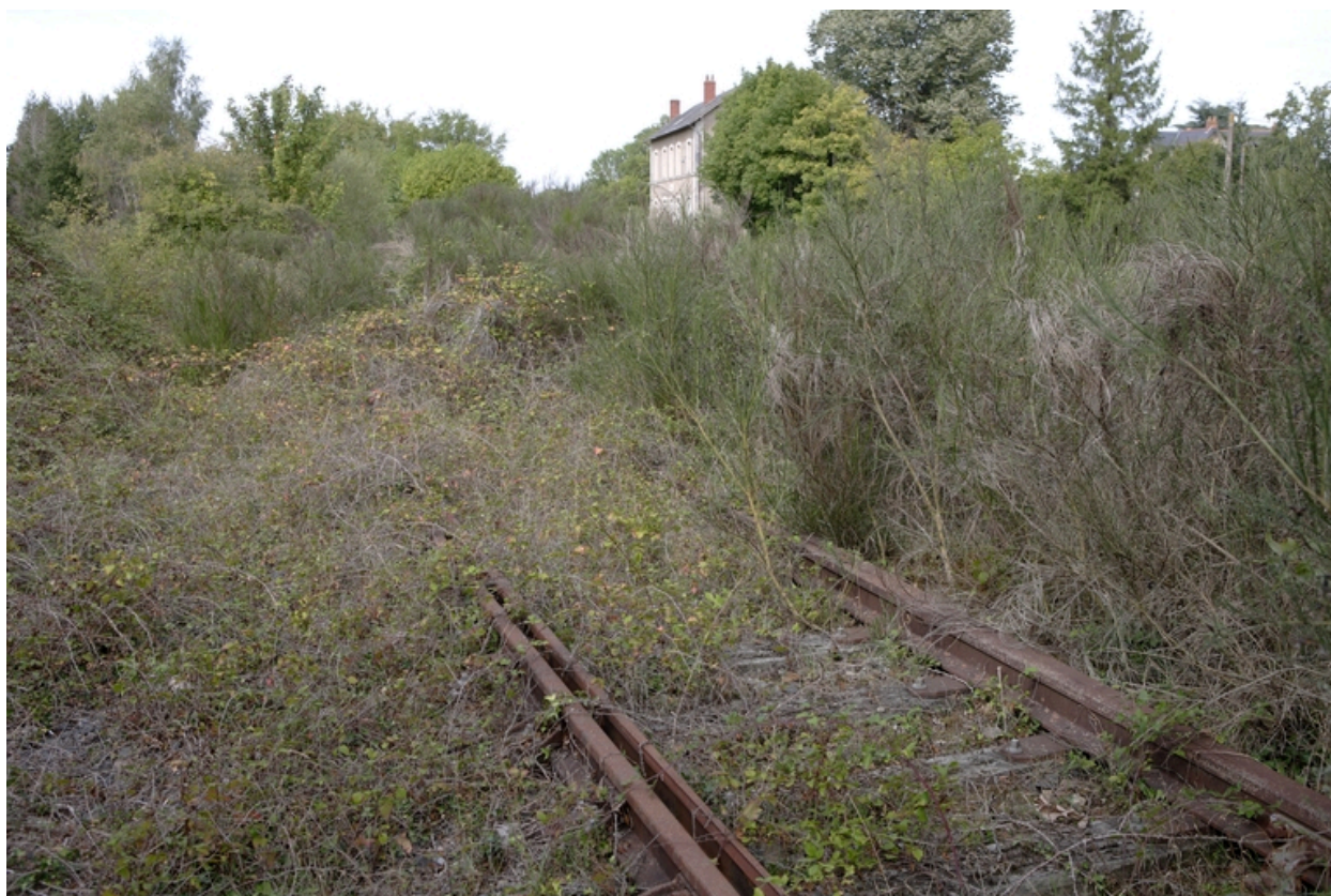
Voies de la zone industrielle.
