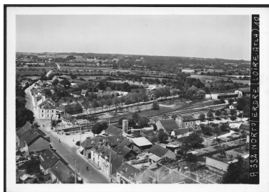
PN 326 et entrée de la gare, 1955-1960. IVR52_20134401051NUCA
