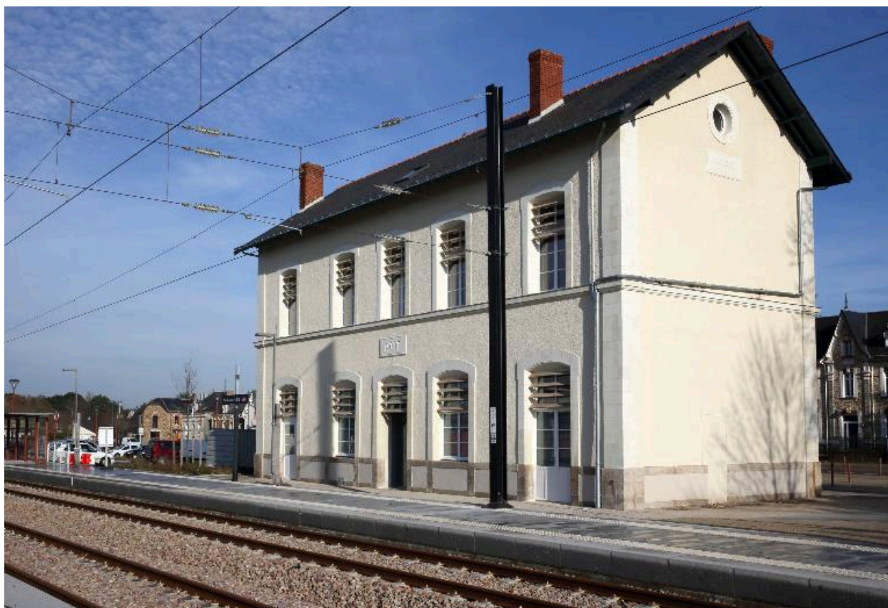
Façade côté voie après rénovation.
