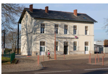
Façade côté cour après rénovation. Phot. Denis Pillet IVR52_20144400060NUCA
