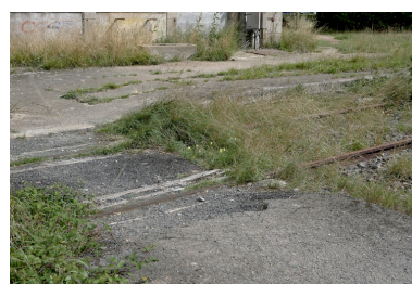
Bateau permettant l'accès aux quais. Phot. Denis Pillet IVR52_20104402178NUCA
