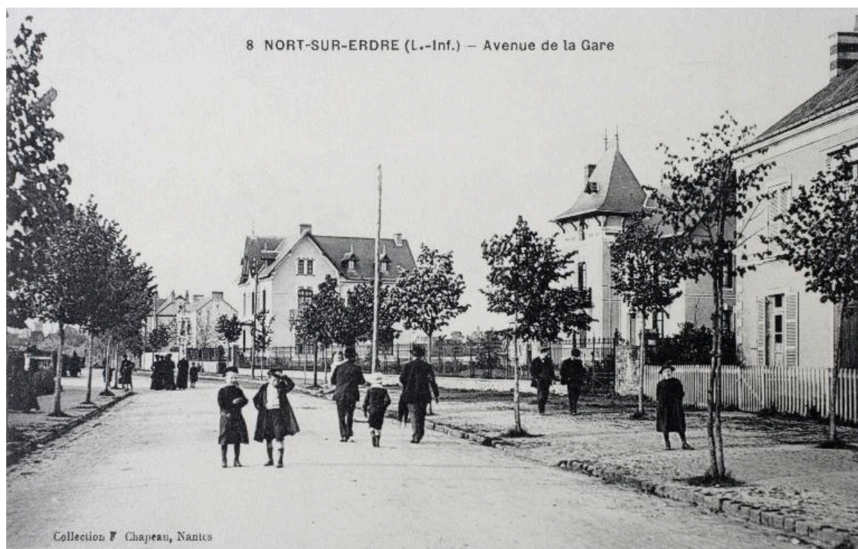
Avenue de la gare, fin du XIXe siècle.
