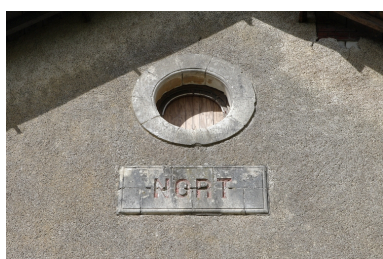
Plaque d'arrêt sur le pignon côté Nantes.
