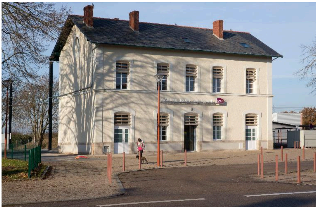
Façade côté cour après rénovation.
