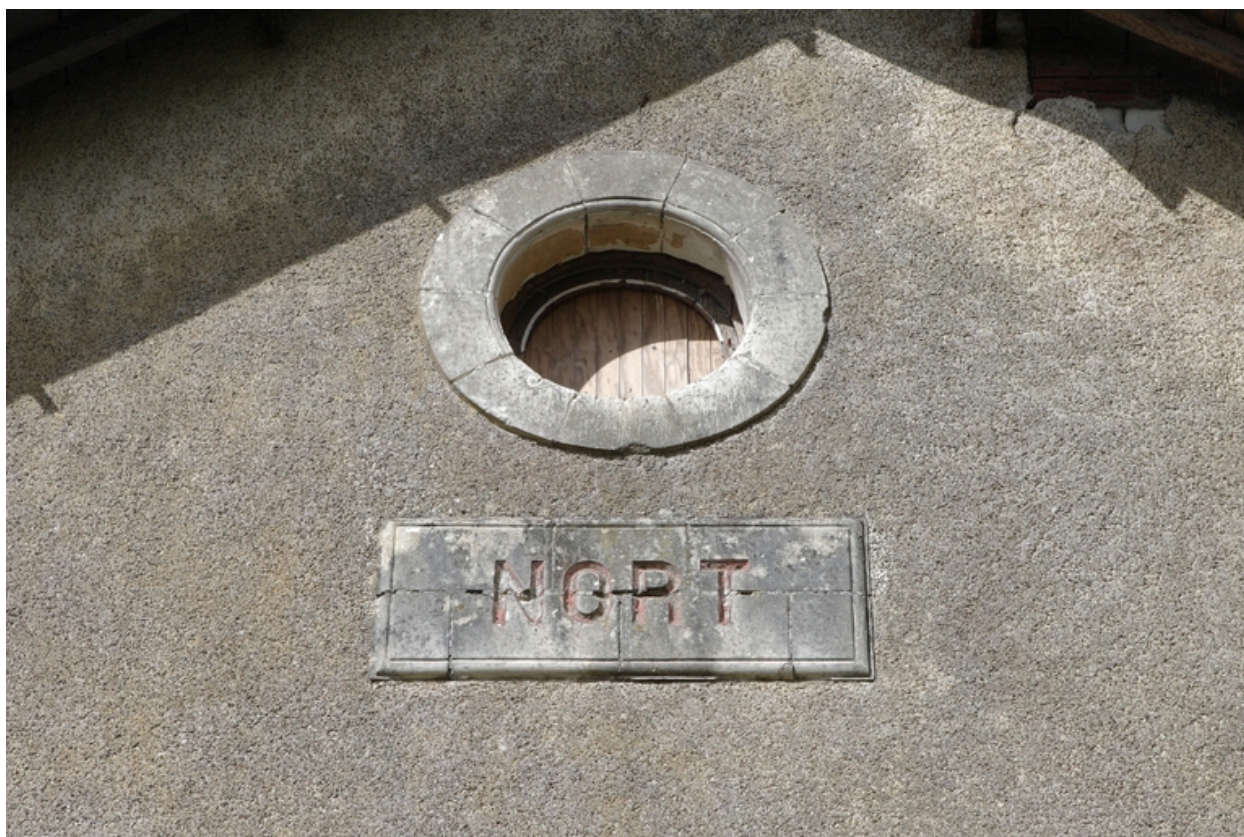
Plaque d'arrêt sur le pignon côté Nantes.
