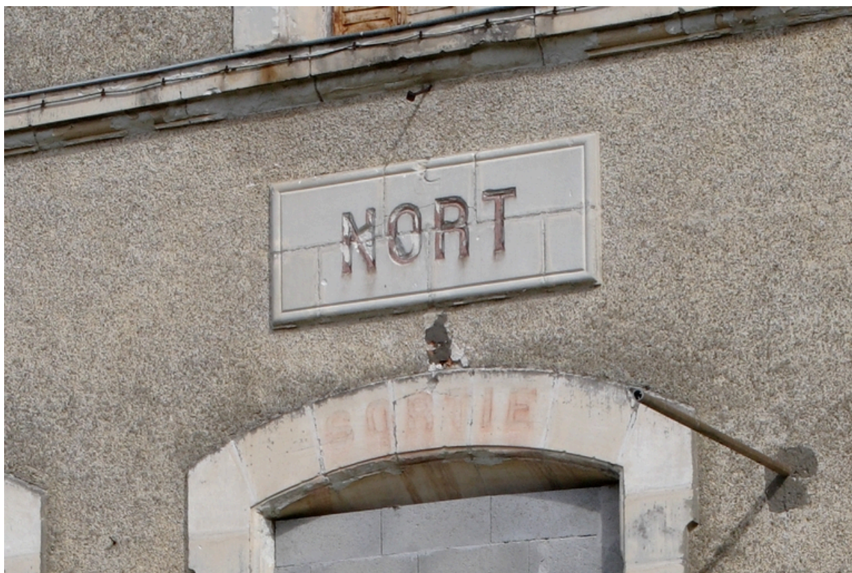
Détail sur la façade côté quai.
