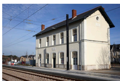
Façade côté voie après rénovation. Phot. Denis Pillet IVR52_20144400073NUCA
