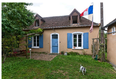
Elévation antérieure de la maison.
