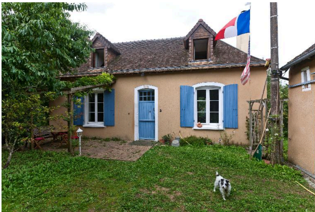
Elévation antérieure de la maison.
