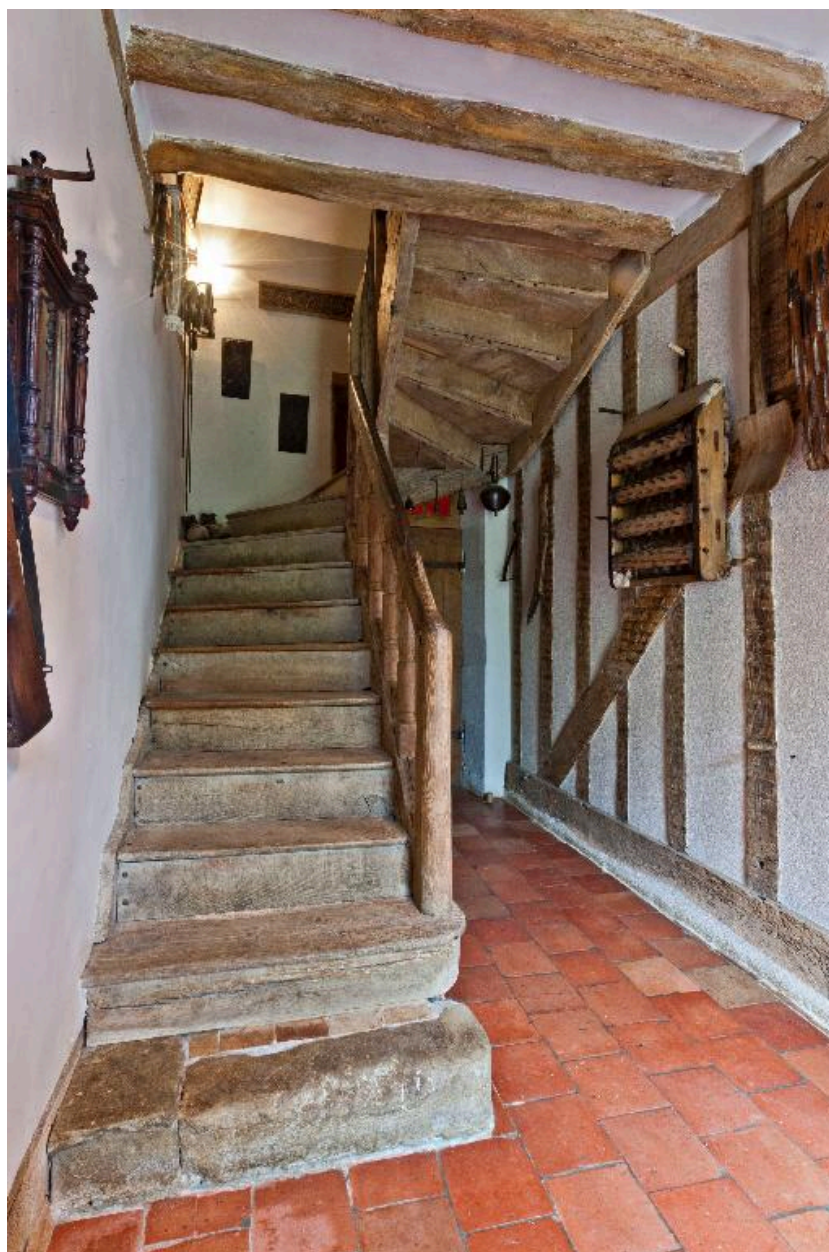
L'escalier vu du rez-de-chaussée.
