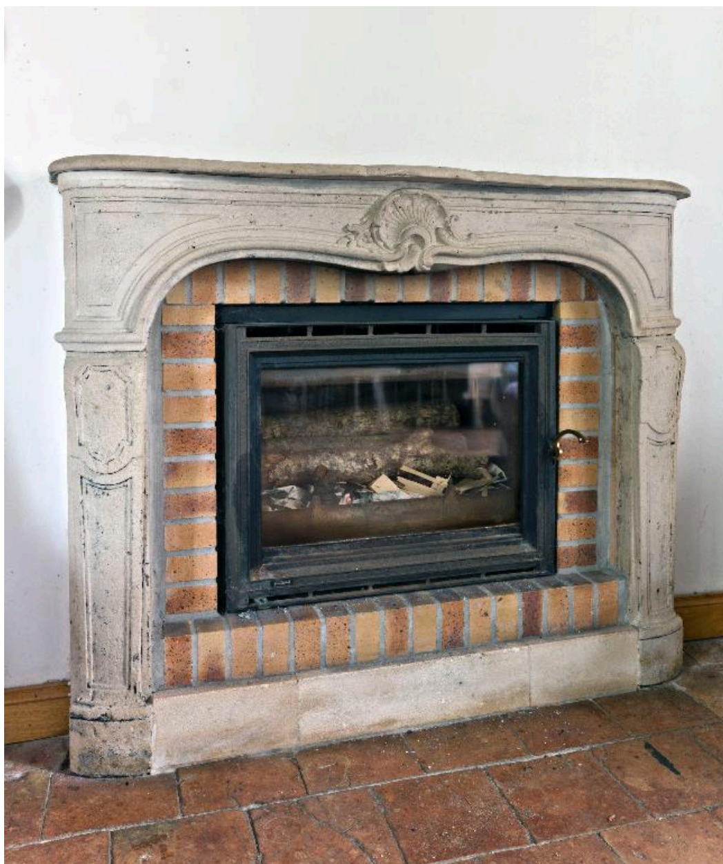
Cheminée de la pièce gauche.
