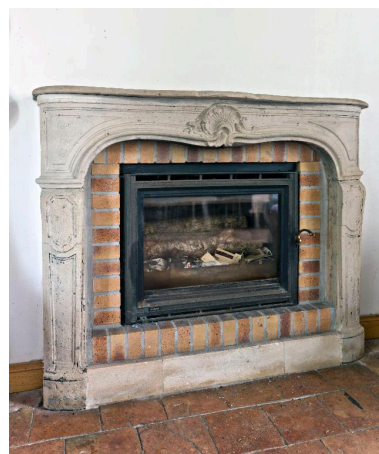
Cheminée de la pièce gauche.
