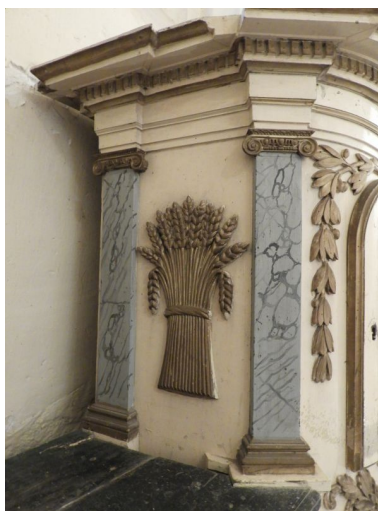
Le tabernacle, côté gauche. Phot. Yannis Suire IVR52_20188500845NUCA
