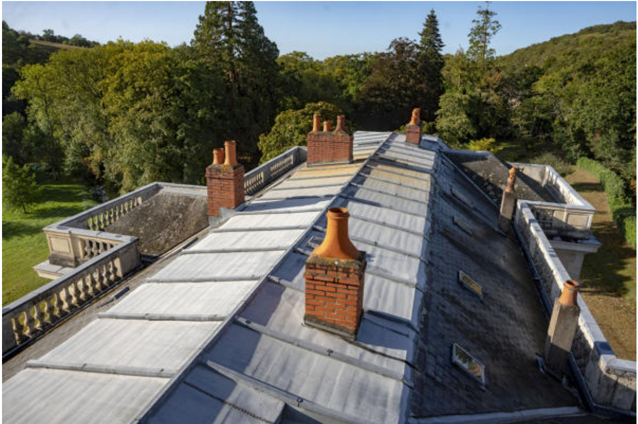
La toiture du château.
