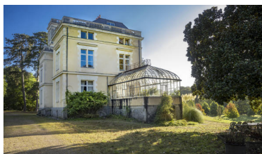
Le mur-pignon sud du château. Phot. Pierre-Bernard Fourny IVR52_20215301332NUCA
