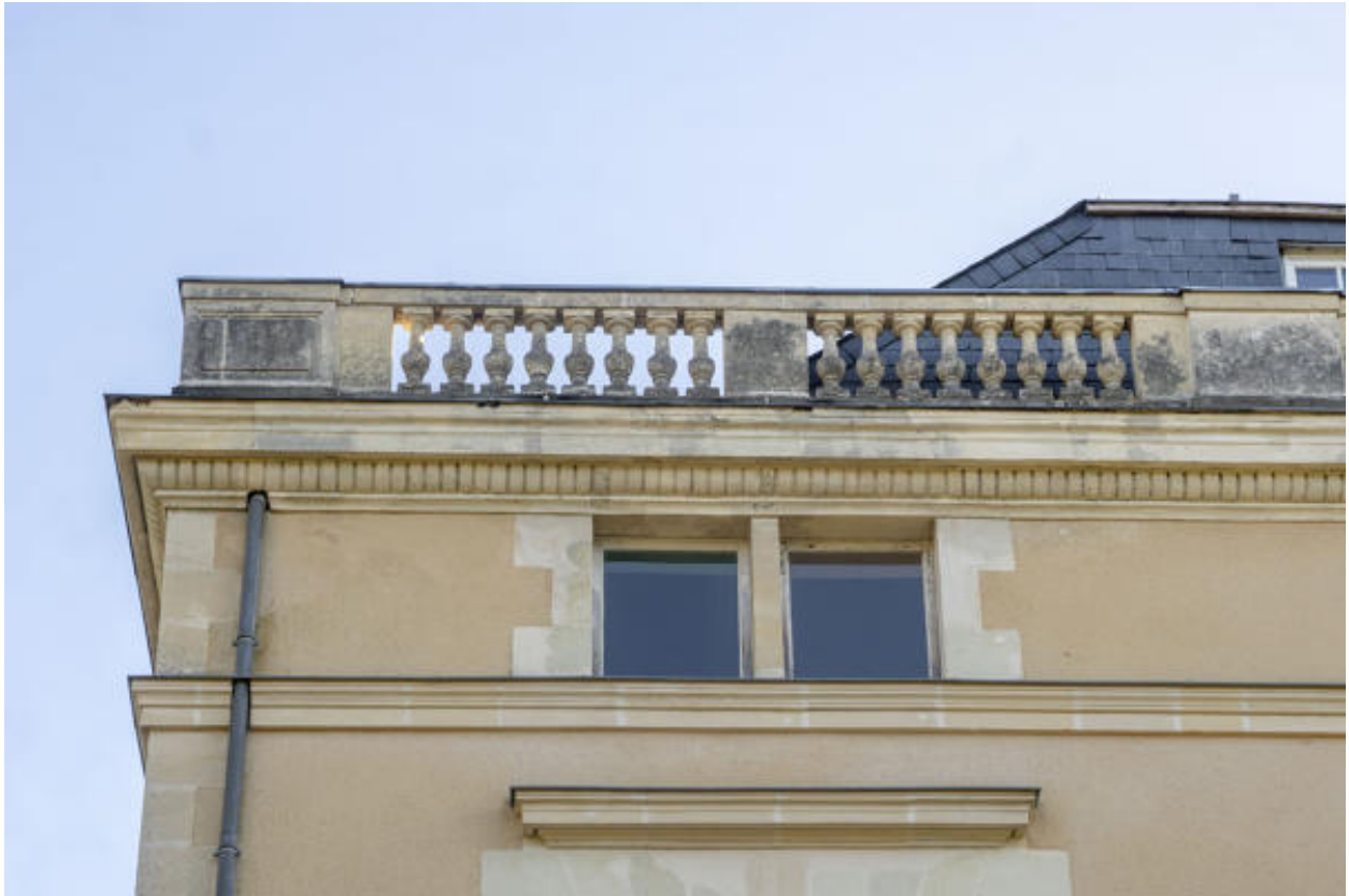
Un détail de la balustrade.
