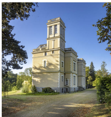
Le mur-pignon nord et le belvédère. Phot. Pierre-Bernard Fourny IVR52_20215301336NUCA
