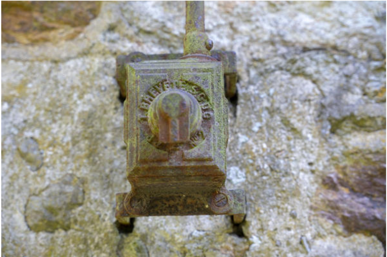
Un détail du mécanisme du store de l'ancien garage.
