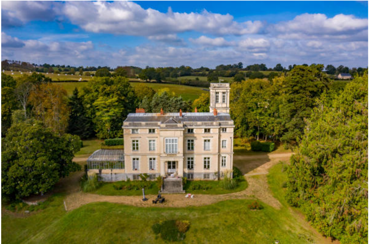
Une vue aérienne du château, depuis l'est.
