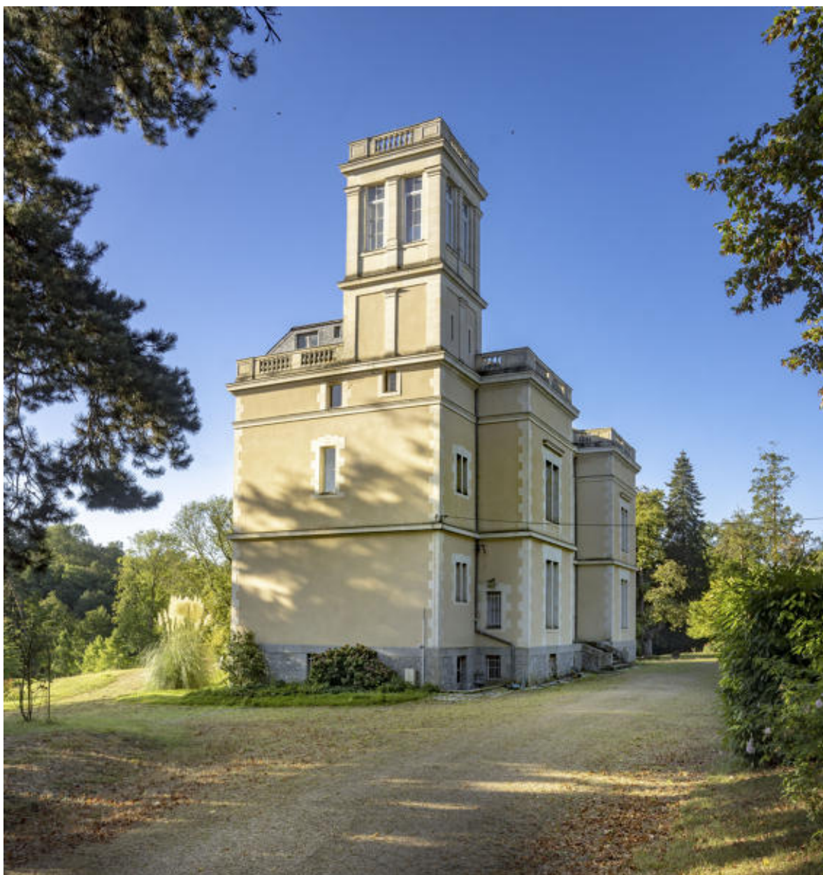
Le mur-pignon nord et le belvédère.
