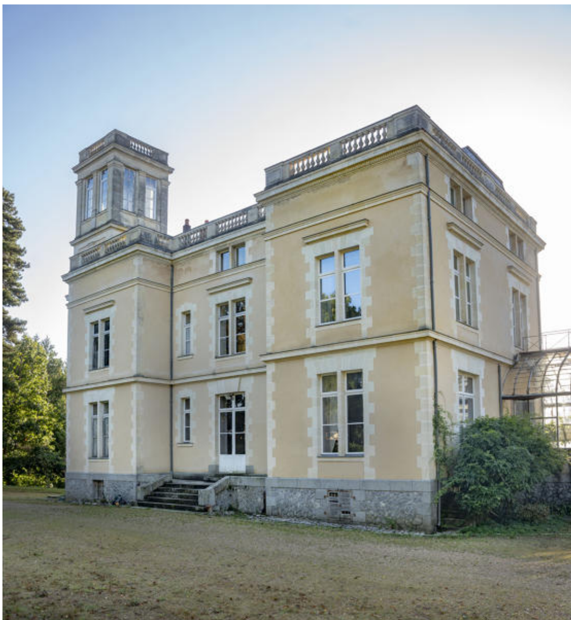
La façade postérieure du château.
