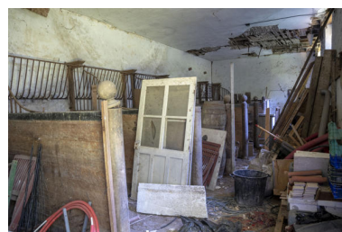
L'ancienne écurie. Phot. Pierre-Bernard Fourny IVR52_20215301341NUCA
