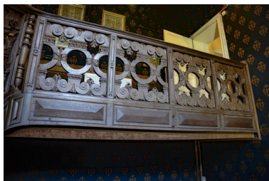
L'escalier d'honneur, détail du garde-corps. Phot. Pierre-Bernard Fourny IVR52_20215301318NUCA
