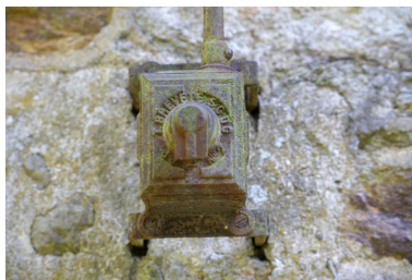
Un détail du mécanisme du store de l'ancien garage. Phot. Pierre-Bernard Fourny IVR52_20215301342NUCA
