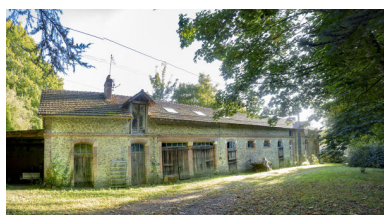
Le corps de dépendances. Phot. Pierre-Bernard Fourny IVR52_20215301340NUCA
