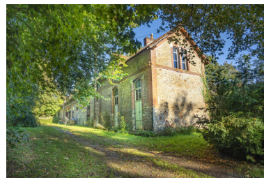
Le corps de dépendances. Phot. Pierre-Bernard Fourny IVR52_20215301344NUCA
