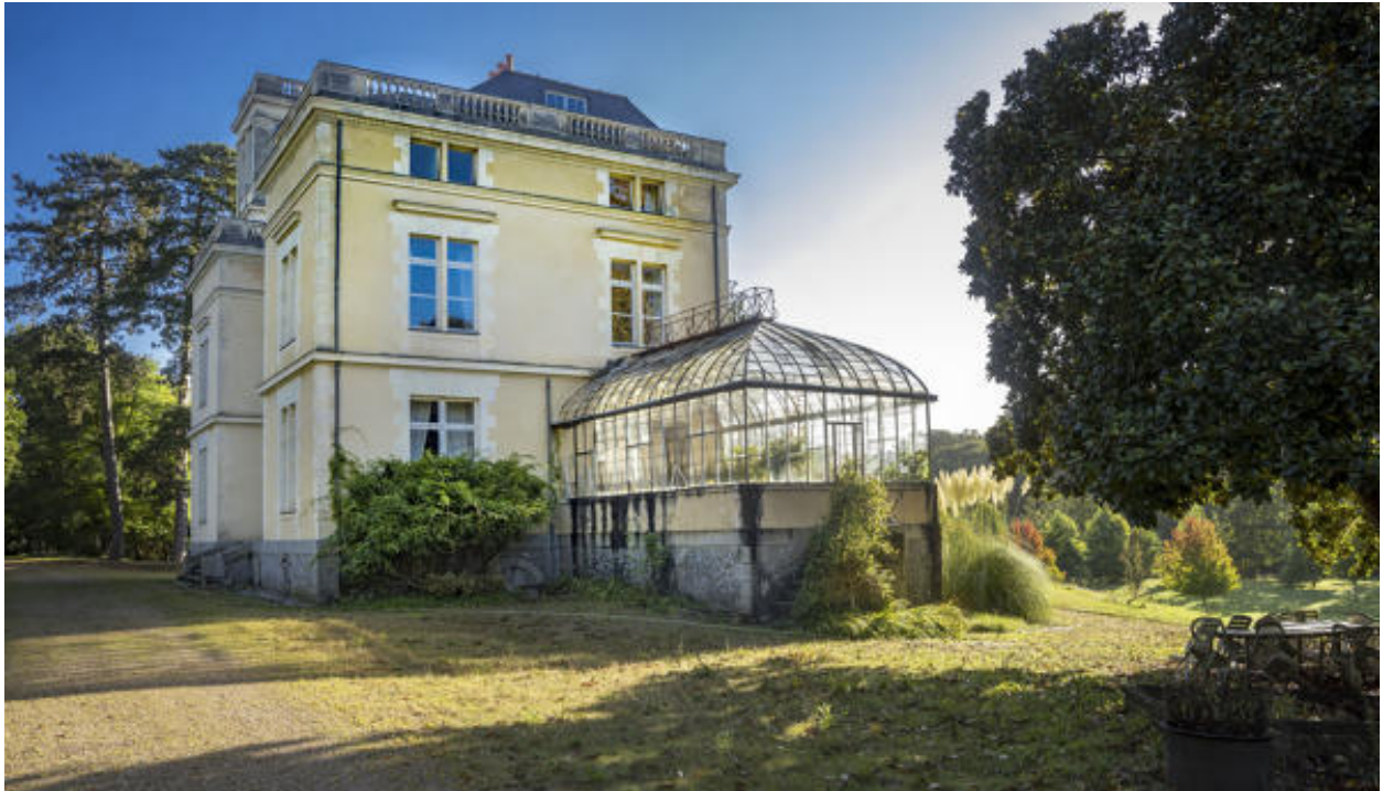
Le mur-pignon sud du château.
