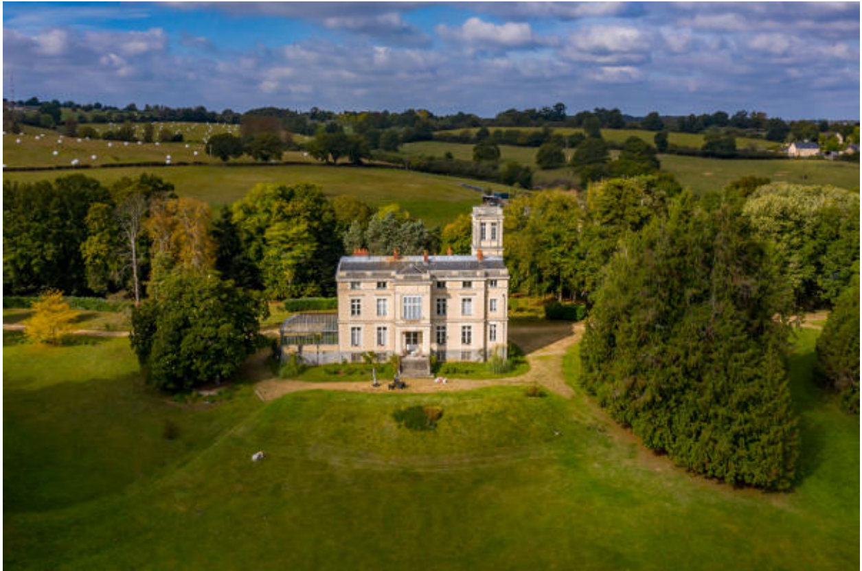
Une vue aérienne du château, depuis l'est.
