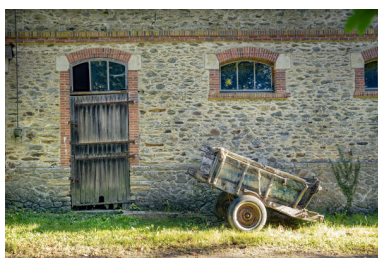
L'ancienne écurie. Phot. Pierre-Bernard Fourny IVR52_20215301339NUCA
