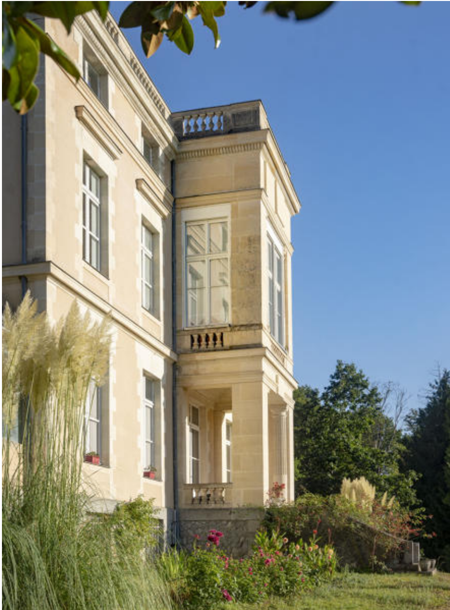
L'avant-corps de la façade antérieure.
