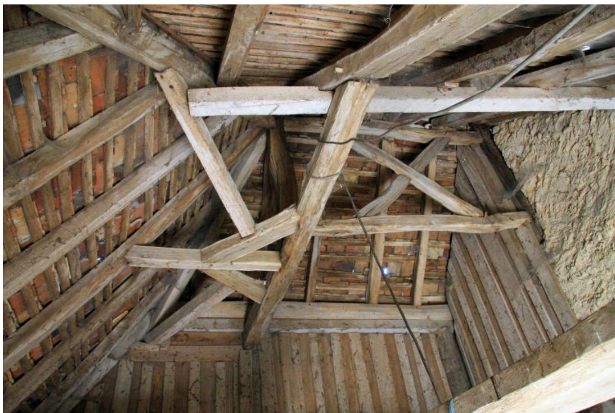
La ferme du château, cabane : charpente en pavillon.
