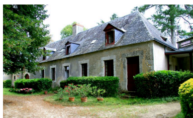
Les dépendances reliées au château : façade sur la cour. Phot. Jean-Baptiste Darrasse IVR52_20087201686NUCA
