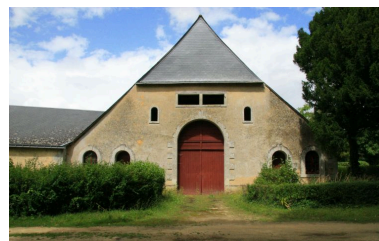
La basse-cour du château : façade de la grange modernisée. Phot. Jean-Baptiste Darrasse IVR52_20087201694NUCA
