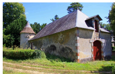
Les communs de la basse- cour : bâtiment en retour d'équerre cantonné d'une tourelle. Phot. Jean-Baptiste Darrasse IVR52_20087201721NUCA
