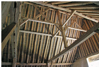
La grange : charpente à pannes, avec sous-faîtage et faux entrails à encoches pour les pannes. Phot. Jean-Baptiste Darrasse IVR52_20087201724NUCA
