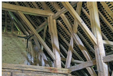
La grange : assemblages des poteaux de la nef avec les entrails de la charpente. Phot. Jean-Baptiste Darrasse IVR52_20087201725NUCA
