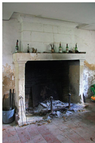
Les communs : cheminée de la 1ère salle. Phot. Jean-Baptiste Darrasse IVR52_20087201687NUCA
