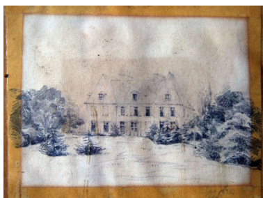
Le logis : façade sud. Dessin (collection particulière). Phot. Jean-Baptiste (reproduction) Darrasse IVR52_20087201679NUCA
