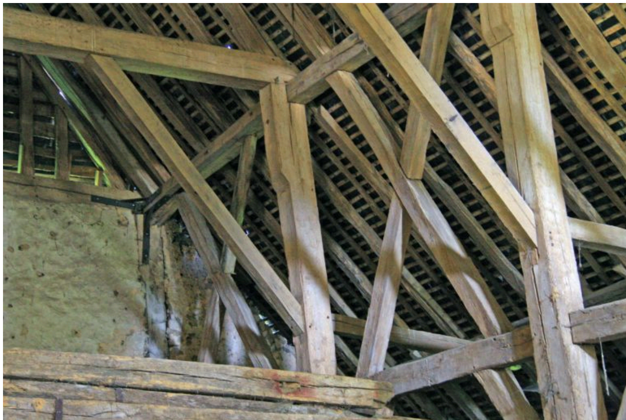
La grange : assemblages des poteaux de la nef avec les entrails de la charpente.
