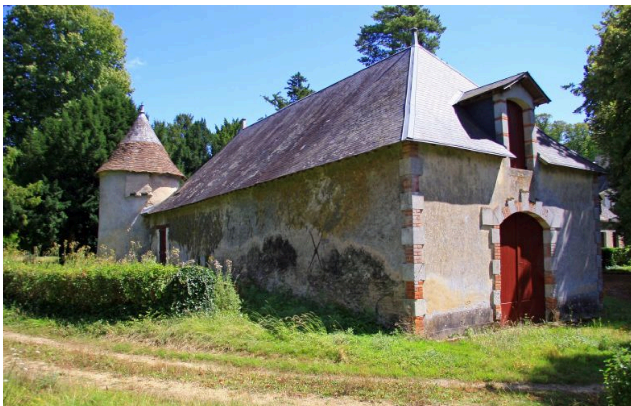
Les communs de la basse-cour : bâtiment en retour d'équerre cantonné d'une tourelle.
