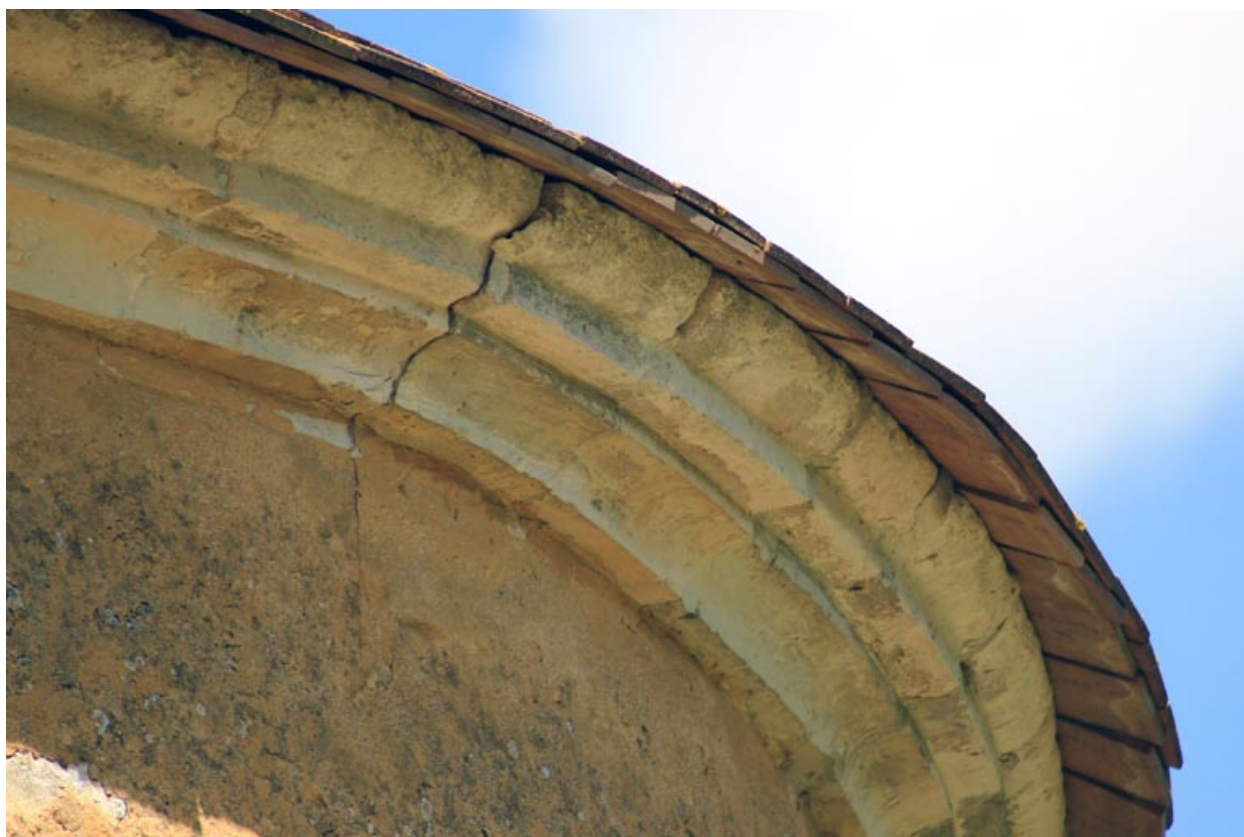
La basse-cour, le pigeonnier : corniche.
