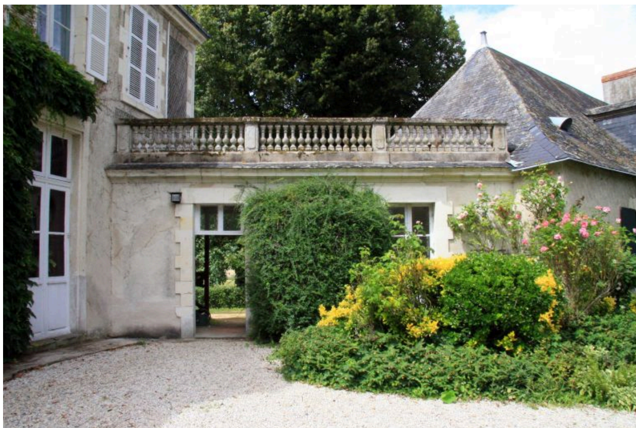
Passage reliant le logis aux communs : face côté parc.
