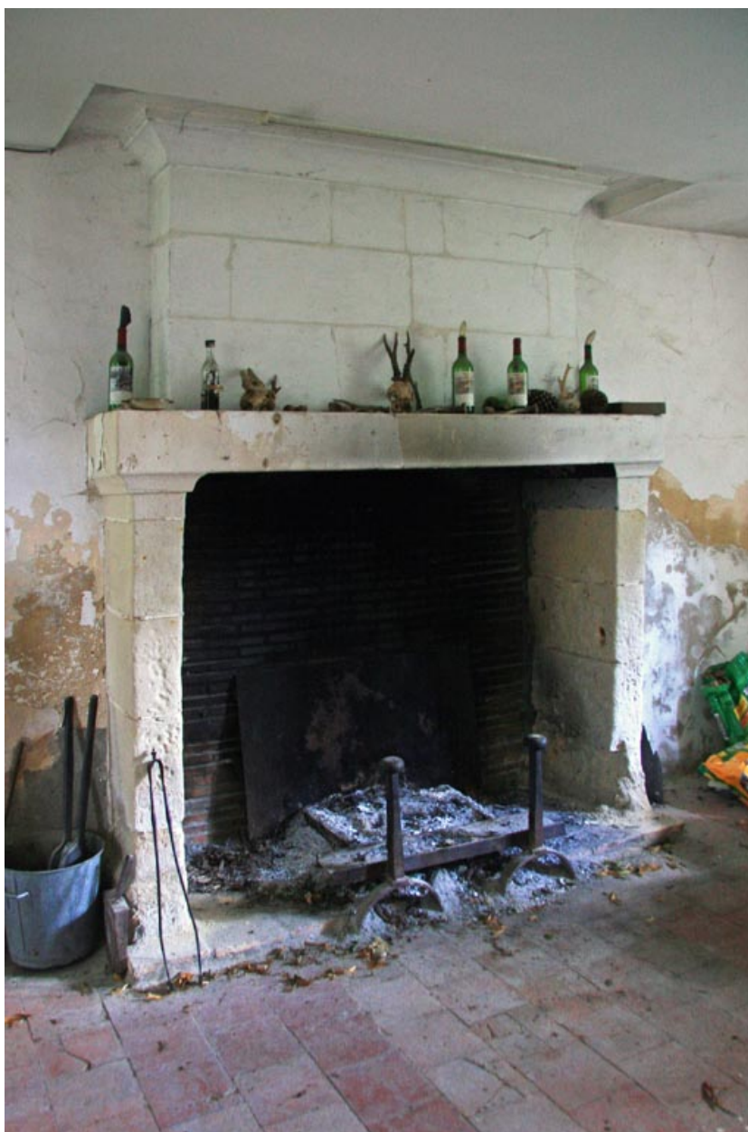
Les communs : cheminée de la 1ère salle.
