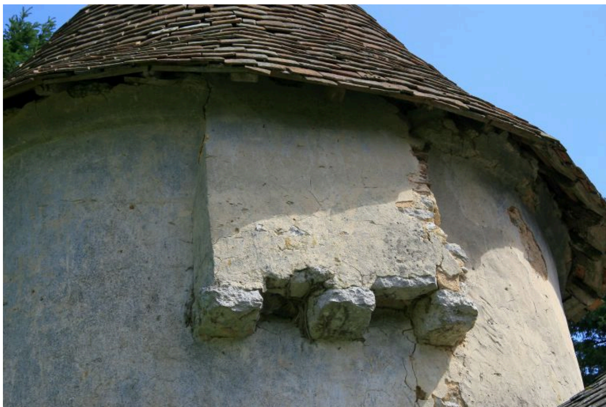
Tourelle nord-ouest des communs : anciennes latrines ?
