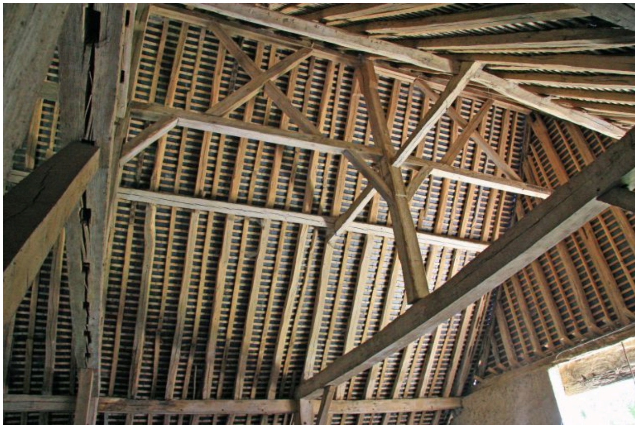
La grange : charpente à pannes, avec sous-faîtage et faux entrails à encoches pour les pannes.
