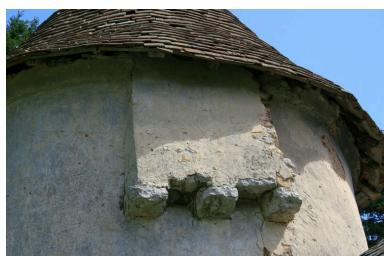
Tourelle nord-ouest des communs : anciennes latrines ? Phot. Jean-Baptiste Darrasse IVR52_20087201733NUCA
