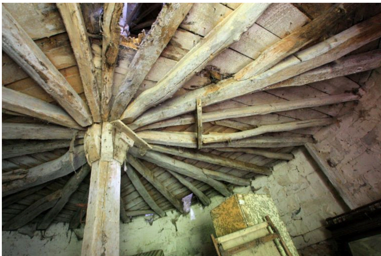
La basse-cour du château, pigeonnier : rez-de-chaussée.
