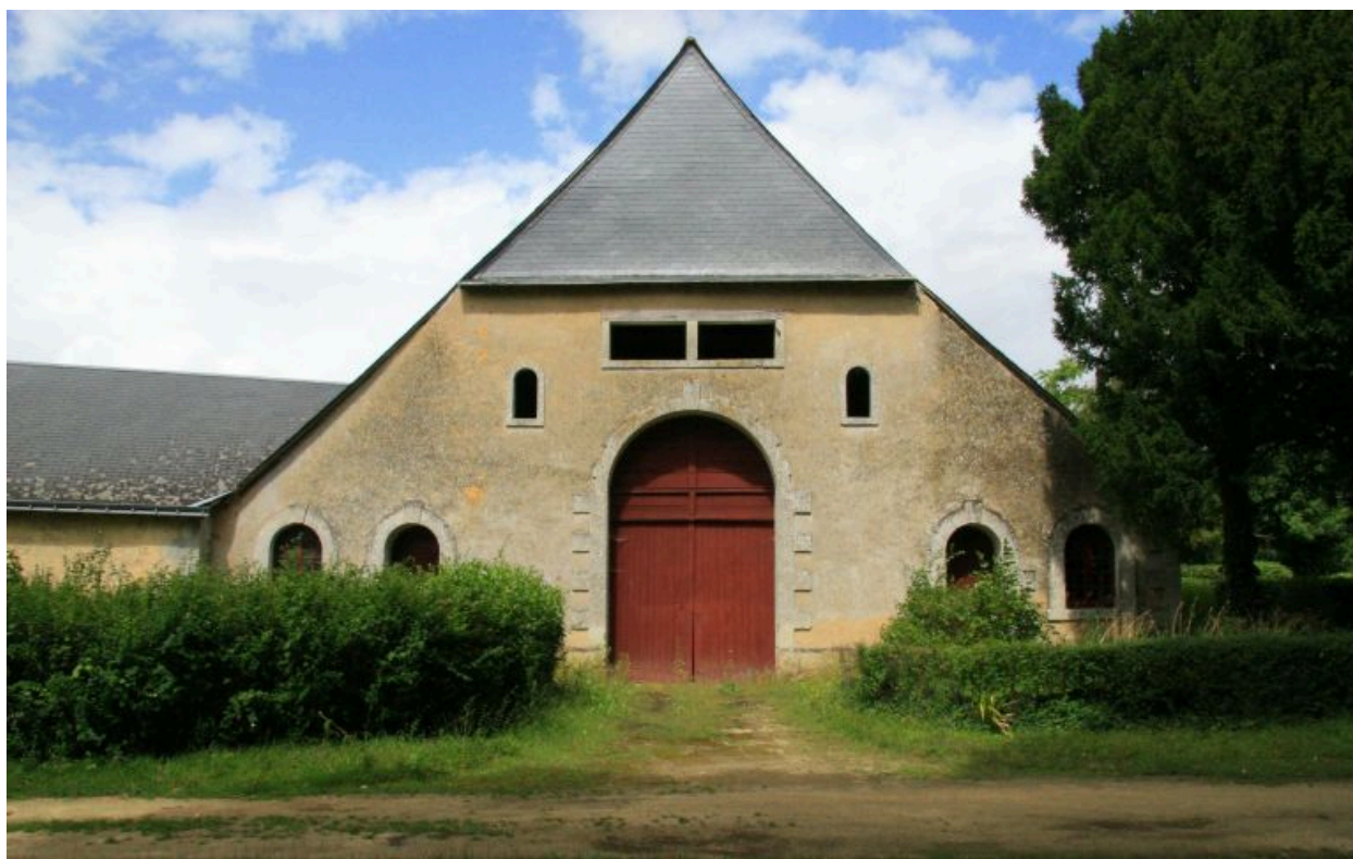
La basse-cour du château : façade de la grange modernisée.
