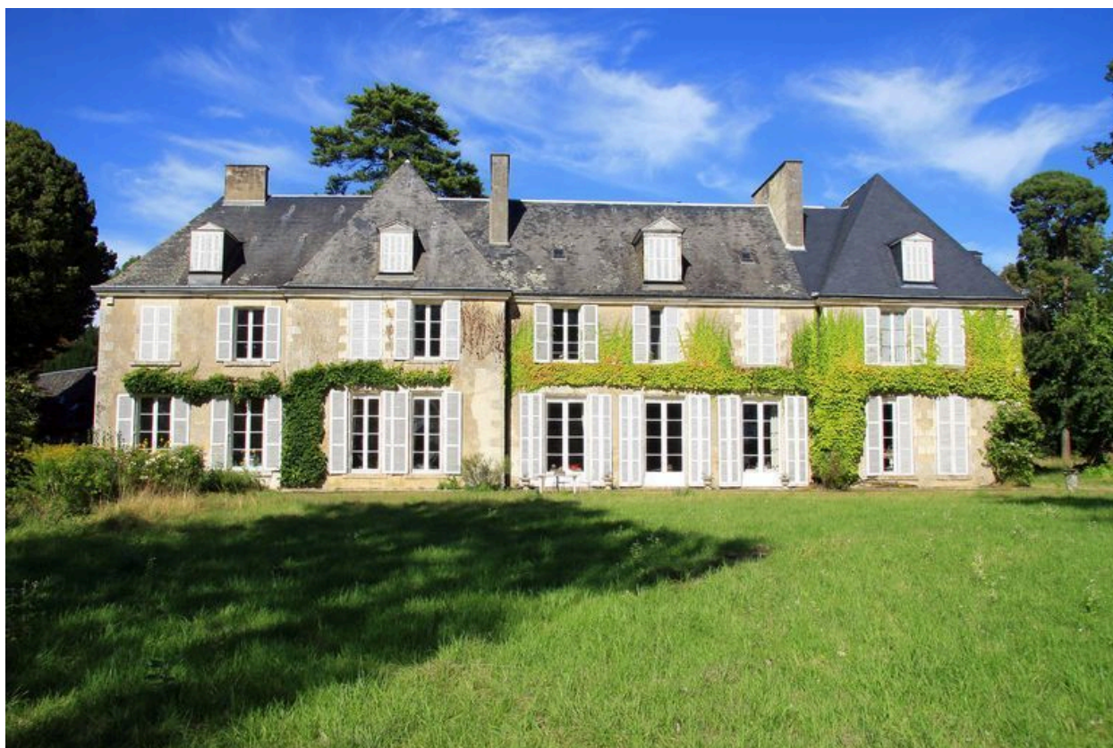
Le logis : façade principale.
