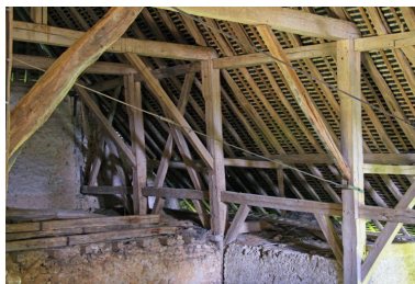
La grange : nef à bas-côtés. Phot. Jean-Baptiste Darrasse IVR52_20087201722NUCA
