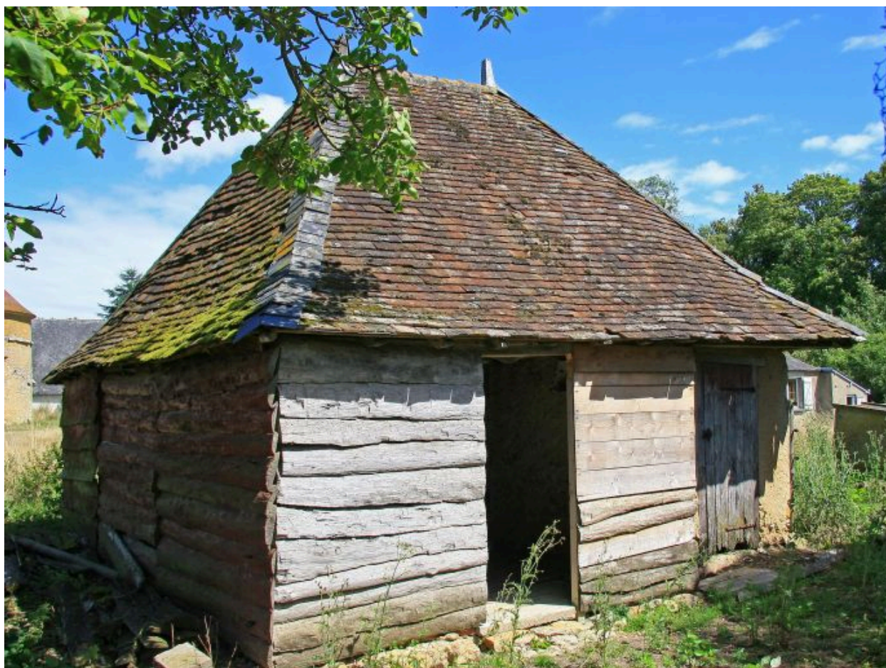
La ferme du château, cabane en bois : façade postérieure.
