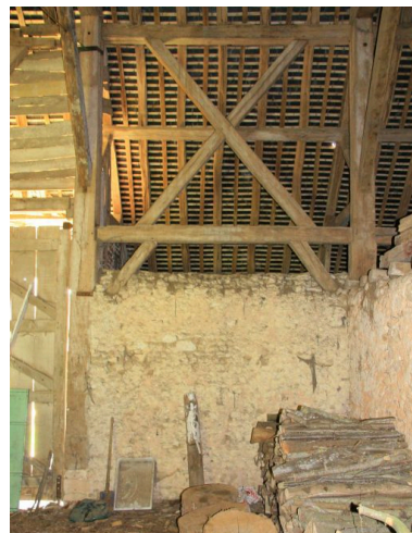
La grange : travée maçonnée entre deux poteaux des bas-côtés. Phot. Jean-Baptiste Darrasse IVR52_20087201730NUCA
