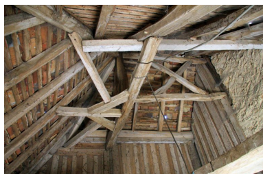
La ferme du château, cabane : charpente en pavillon. Phot. Jean-Baptiste Darrasse IVR52_20087201717NUCA
