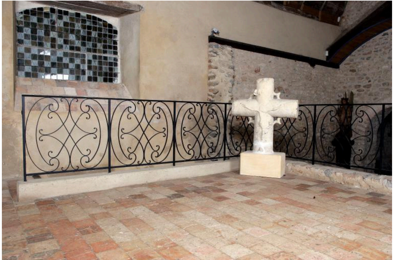
Garde-corps en fer forgé.
