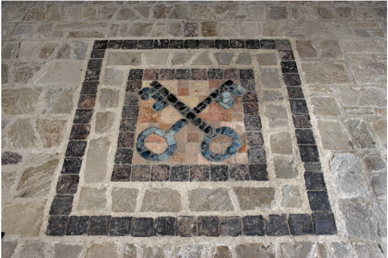
Pavage réalisé en laitier de forge.
