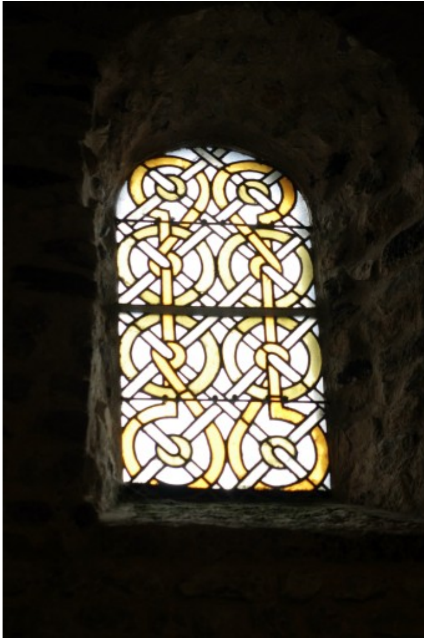
Verrière du mur nord de la croisée.
