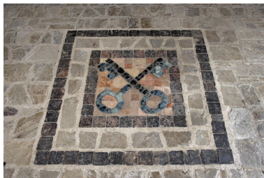
Pavage réalisé en laitier de forge. Phot. François Lasa IVR52_20075302256NUCA
