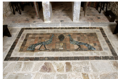
Pavage réalisé en laitier de forge. Phot. François Lasa IVR52_20075302259NUCA
