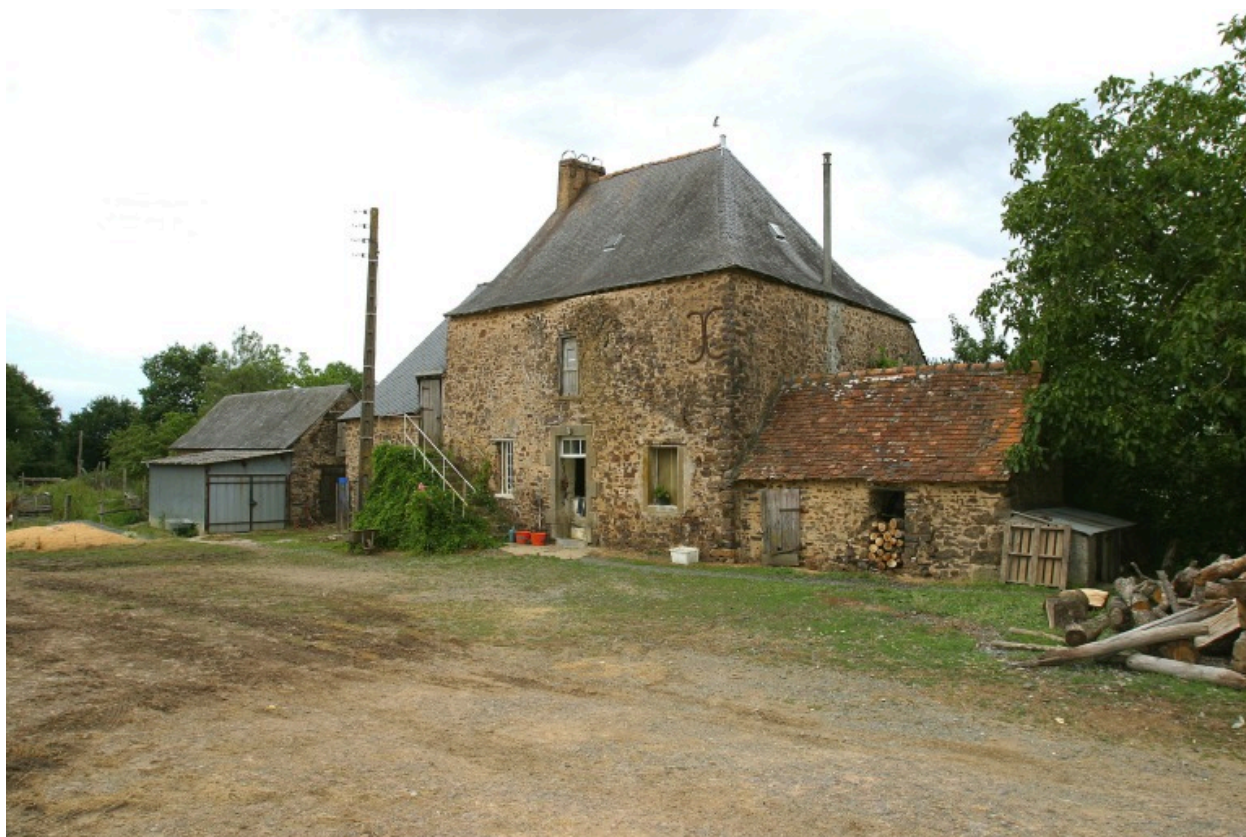
Le logis vu depuis le sud-ouest.
