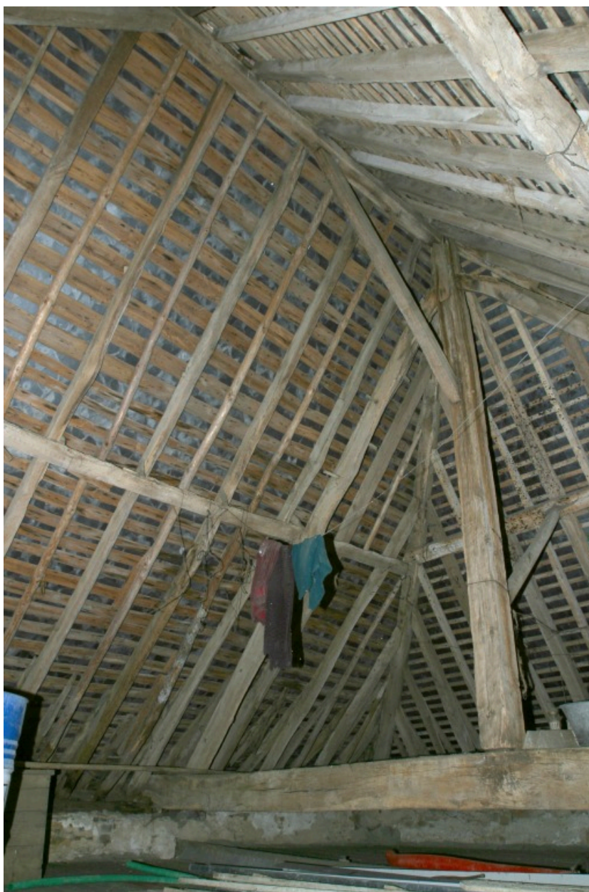
Détail de la charpente : la ferme sud.
