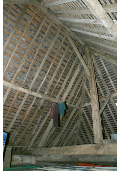
Détail de la charpente : la ferme sud. Phot. François Lasa IVR52_20035302228NUCA
