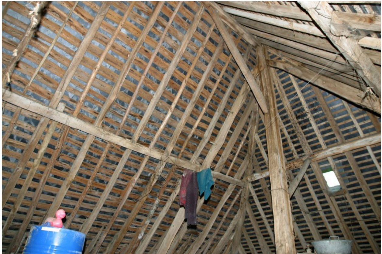
La charpente vue depuis le nord.
