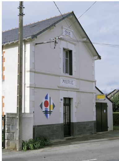
Hommage à Jean Gobin, vue d'ensemble de la facade fresquée. Phot. Denis Pillet IVR52_20004402002XA
