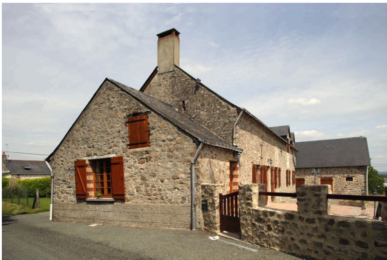
Le logis-étable sud vu depuis l'ouest.
