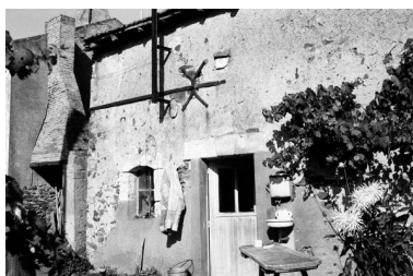
Élévation partielle, 1972. Phot. Marie-Anne Eon IVR52_19724900382Z
