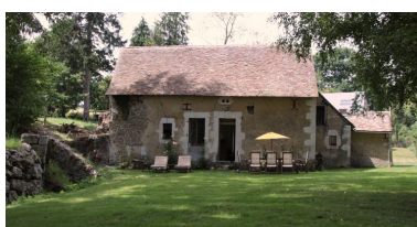
La façade sur le jardin : usine et maison. Phot. Jean-Baptiste Darrasse IVR52_20107201359NUCA
