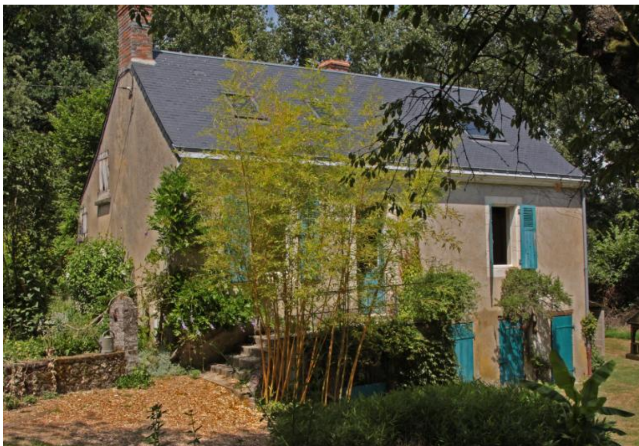
Maison construite avant 1930 en amont du moulin.
