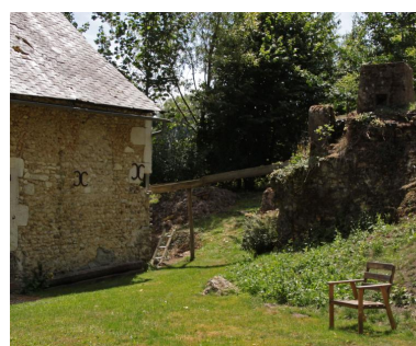
La jonction entre le moulin et le bief. Phot. Jean-Baptiste Darrasse IVR52_20107201351NUCA
