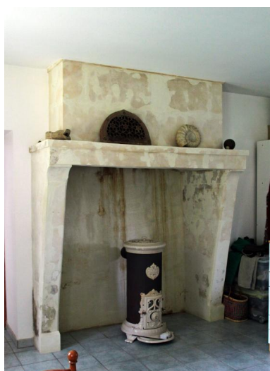
La cheminée de la maison du meunier. Phot. Jean-Baptiste Darrasse IVR52_20107201360NUCA
