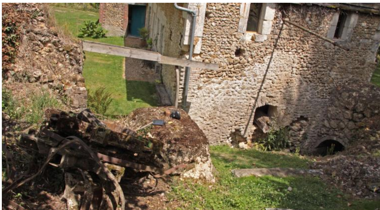
Le pignon du moulin sur le bief.
