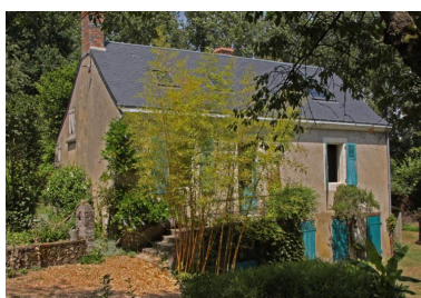
Maison construite avant 1930 en amont du moulin. Phot. Jean-Baptiste Darrasse IVR52_20107201349NUCA
