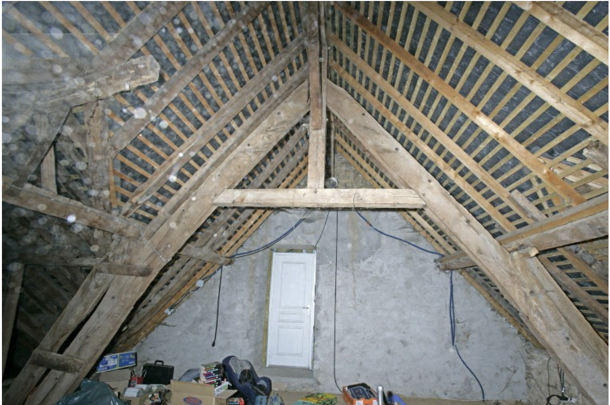
La charpente du logis dont le mur nord porte la date de 1624, vue depuis l'ouest.
