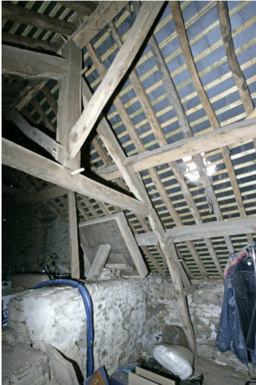
La charpente du fournil vue depuis le nord.
